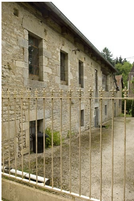
Façade ouest de l'atelier de fabrication (cadrage vertical).
