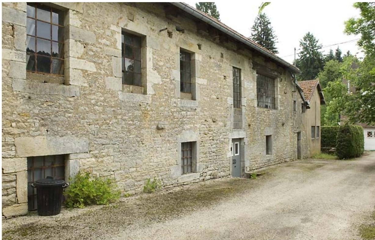
Façade ouest de l'atelier de fabrication.
