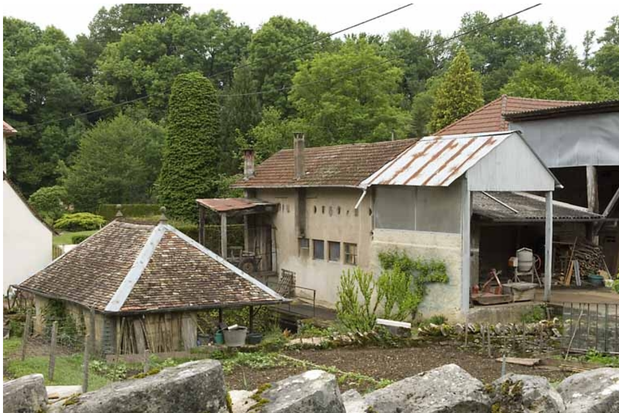
Les bâtiments industriels depuis le sud-est.
