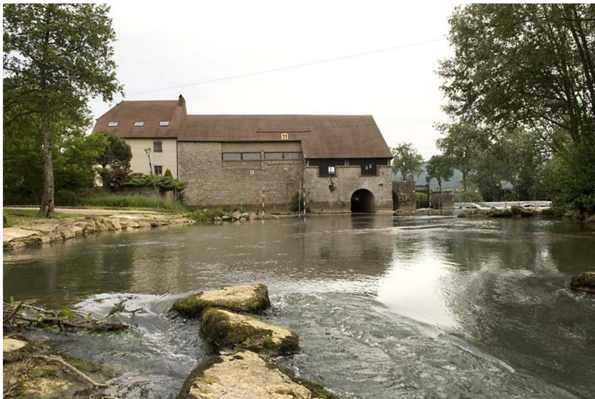
Vue d'ensemble depuis l'Ognon, en aval.
