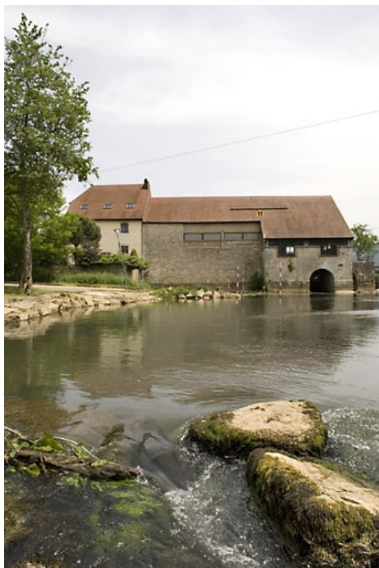
Façade ouest, depuis l'aval.
