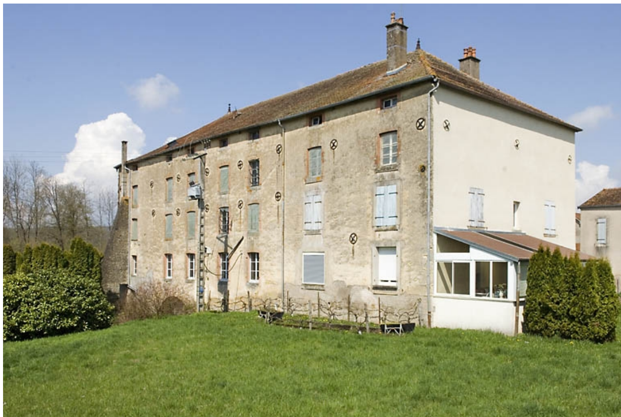
Façade postérieure vue de trois quarts arrière.
