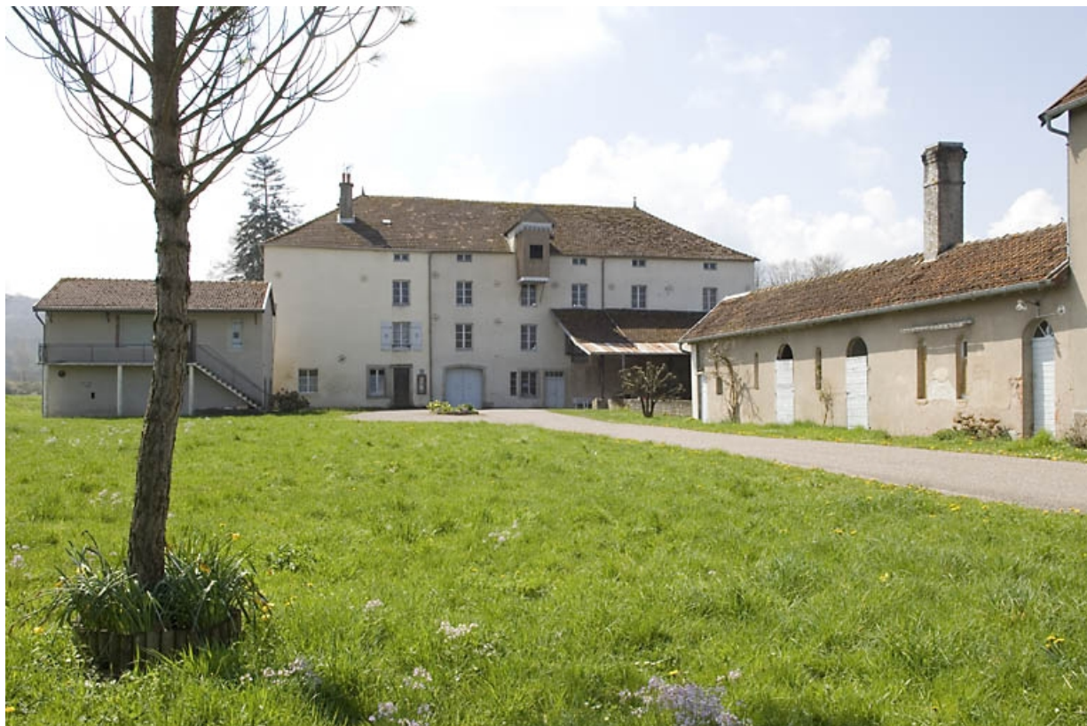
Façade antérieure et dépendances depuis l'entrée.
