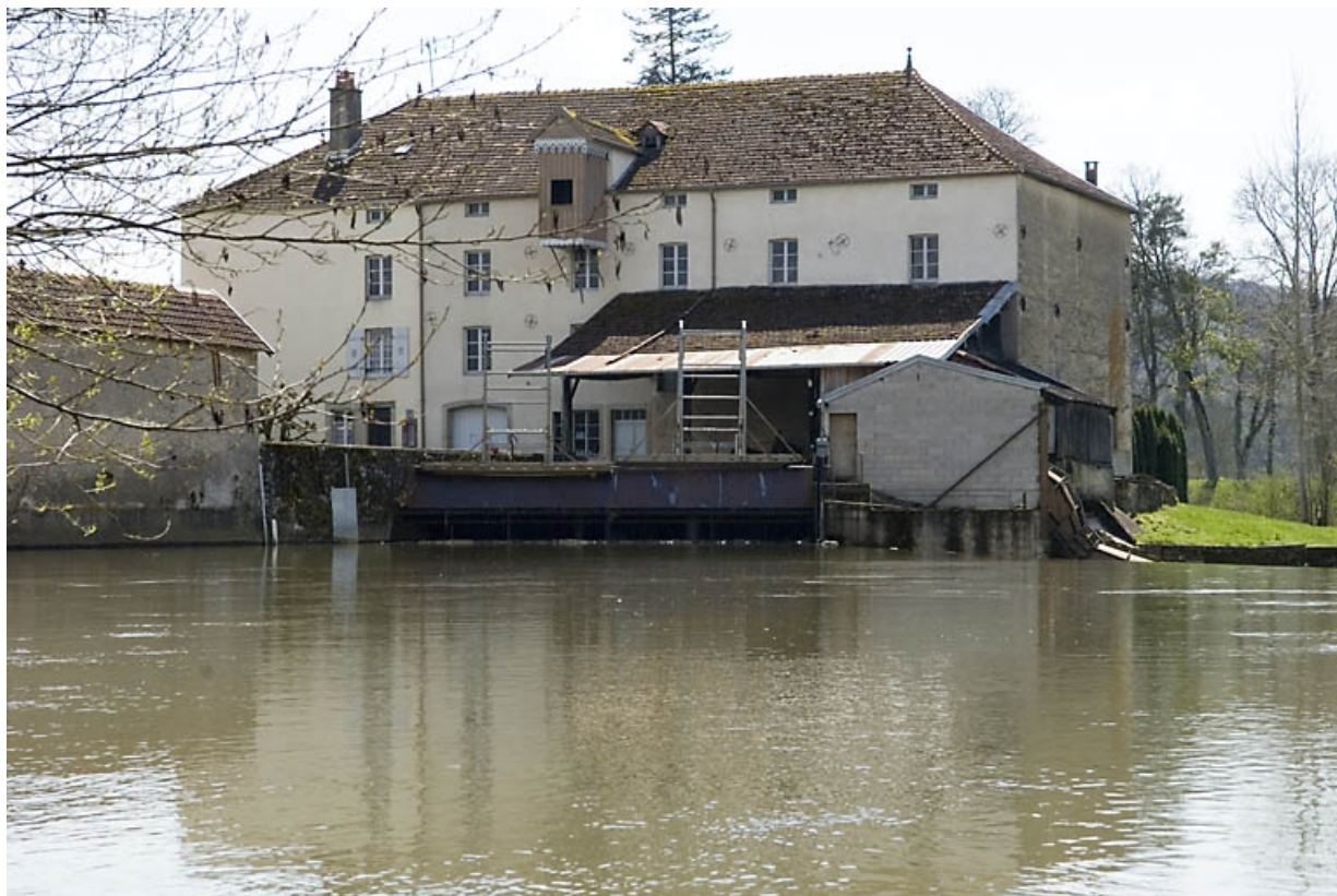
Façade antérieure depuis l'amont.
