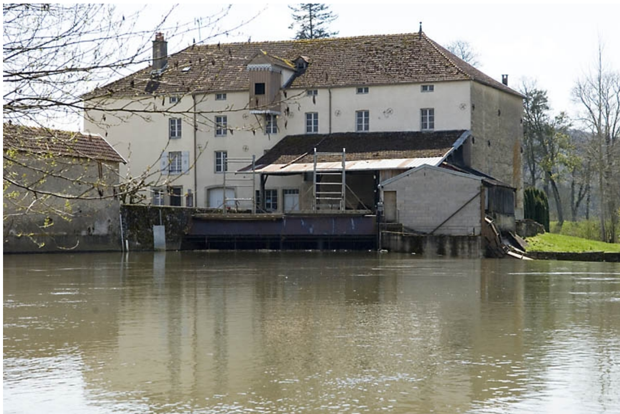
Façade antérieure depuis l'amont.
