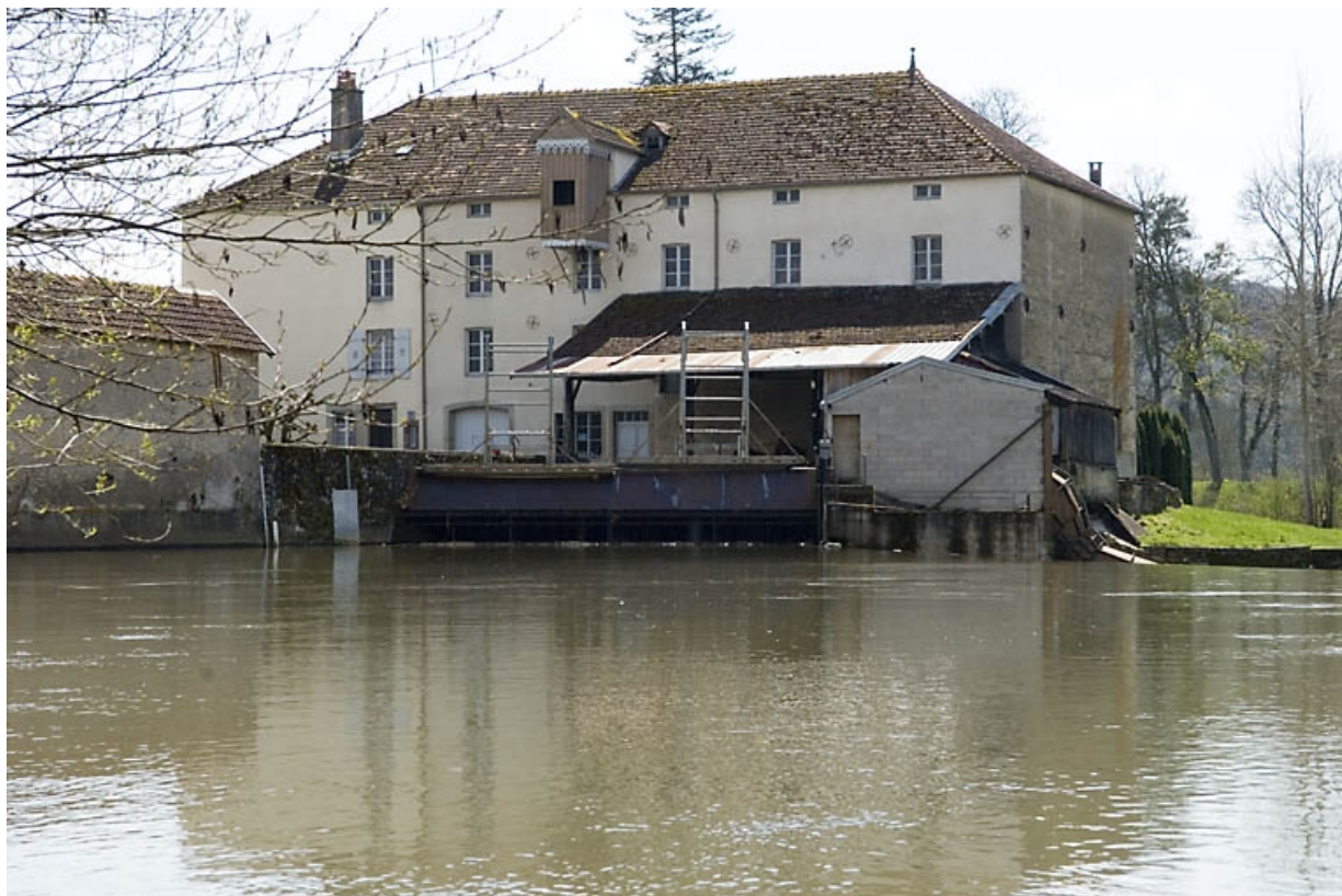
Façade antérieure depuis l'amont.
