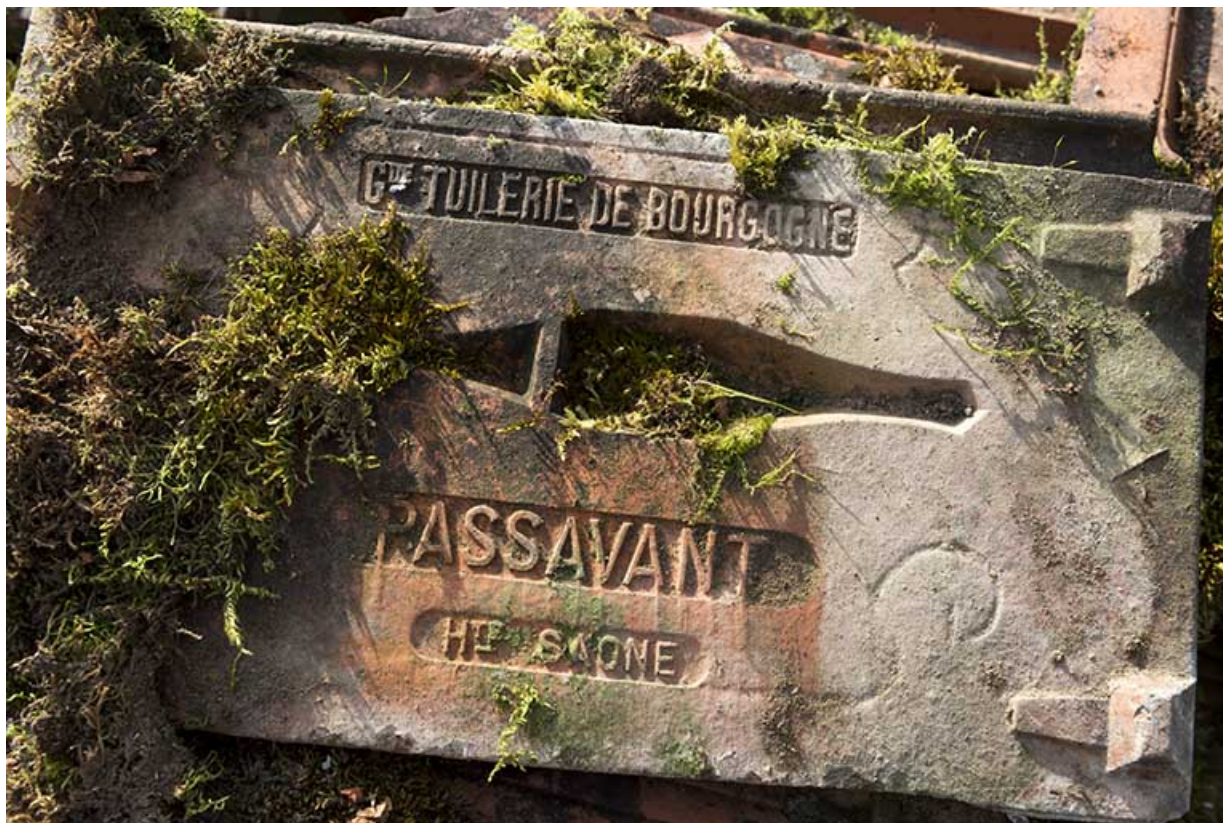
Tuile mécanique. Face interne.
