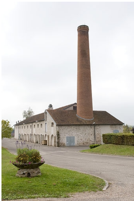
Vue depuis l'est (cadrage vertical).
