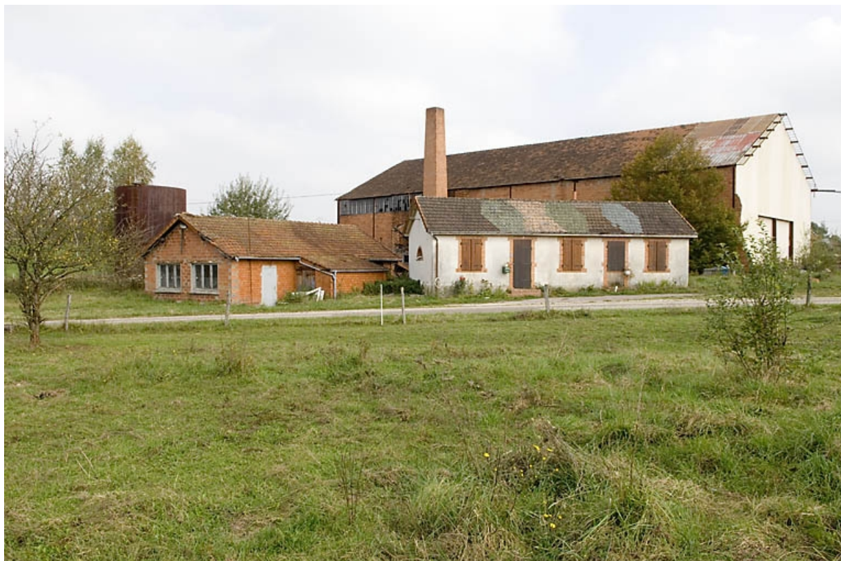
Vue d'ensemble depuis l'ouest.
