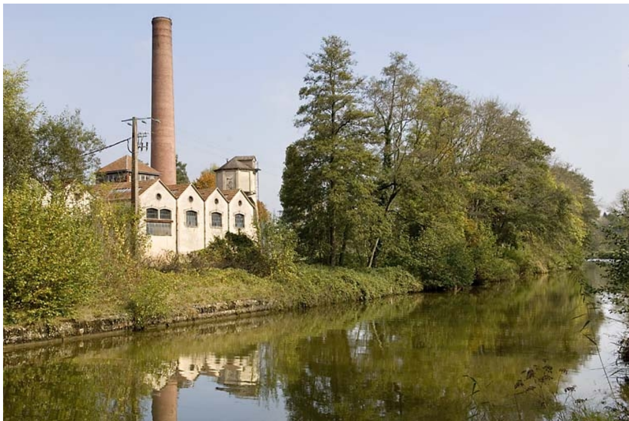
Vue d'ensemble depuis le sud du canal.
