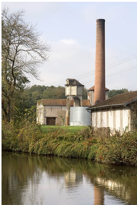
Chaufferie, château d'eau et cheminée depuis le sud-est.
