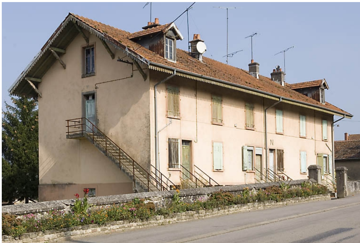
Maison ouvrière N au centre du village (24 Grande Rue).
