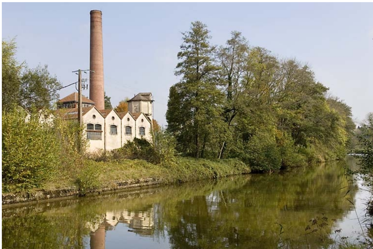
Vue d'ensemble depuis le sud du canal.
