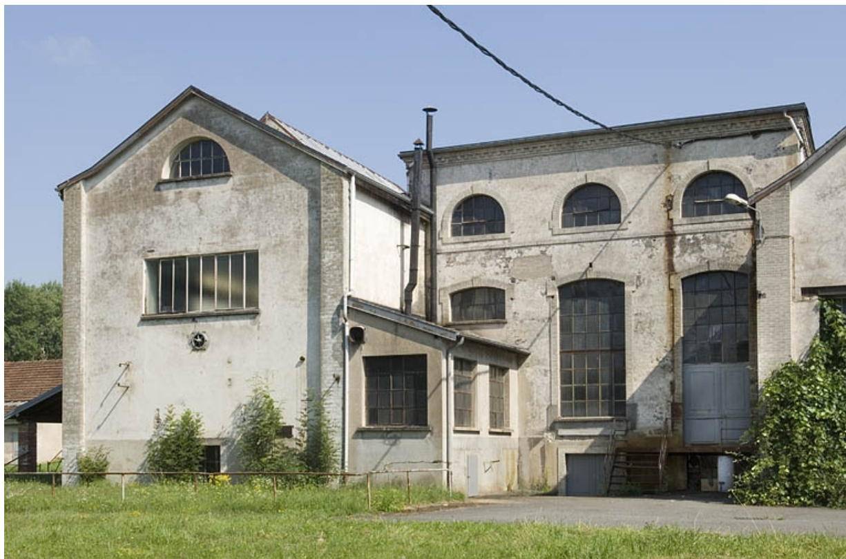
Façade sud de la salle des machines à vapeur.
