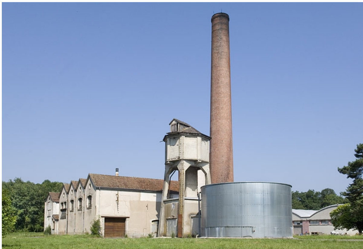
Chauterie, réservoirs industriels et cheminée vus de trois quarts droite.
