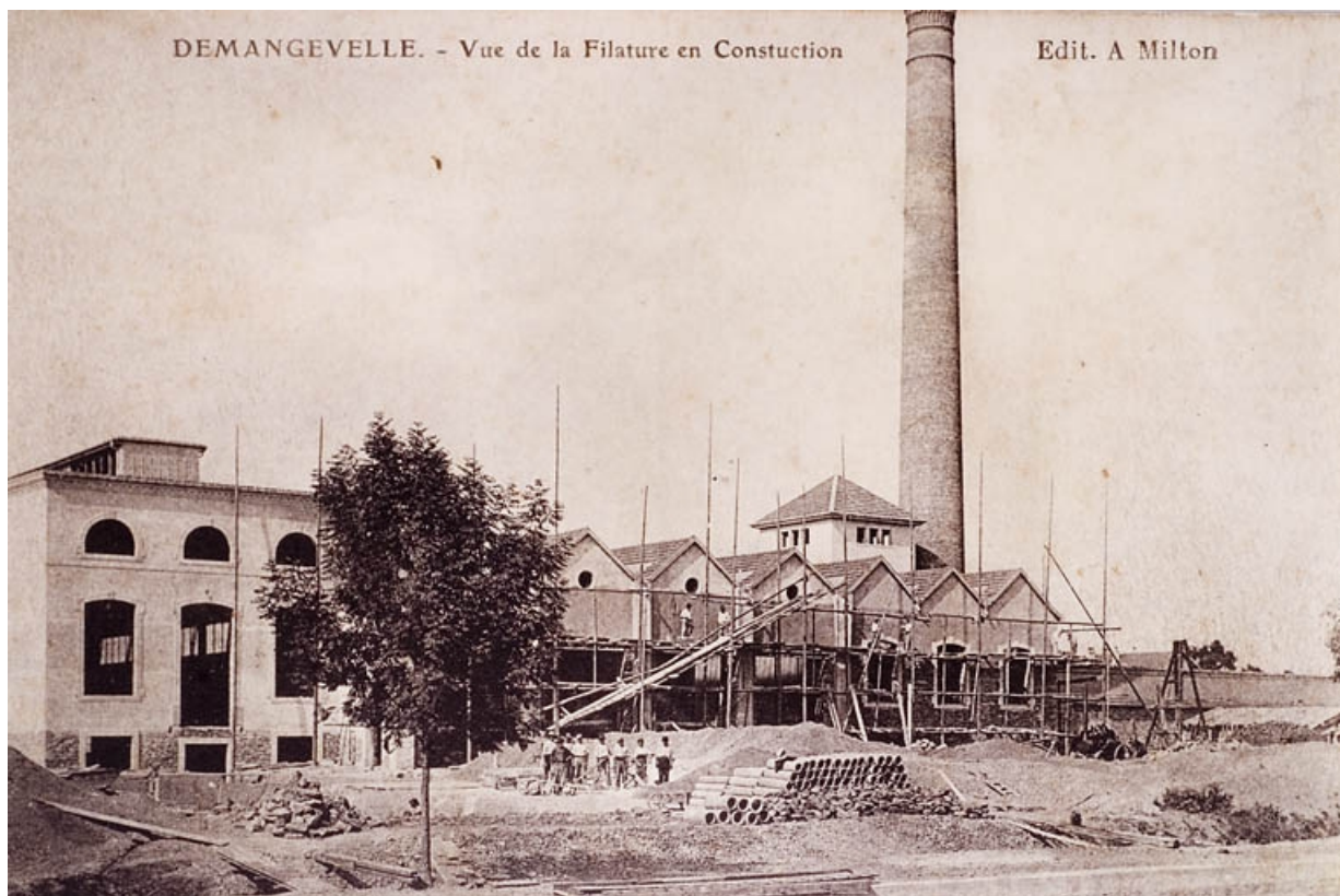
Demangevelle. - Vue de la filature en construction.
