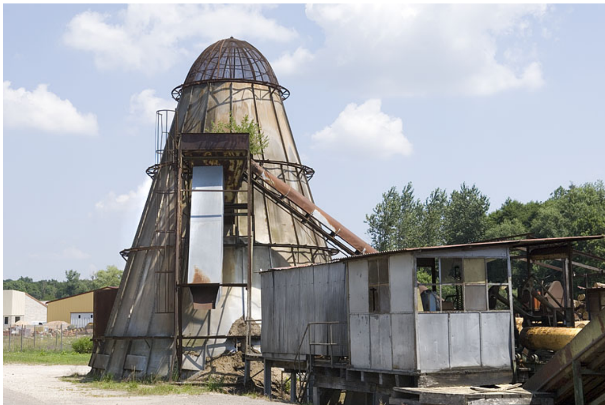
Poste d'écorçage et four à écorces.
