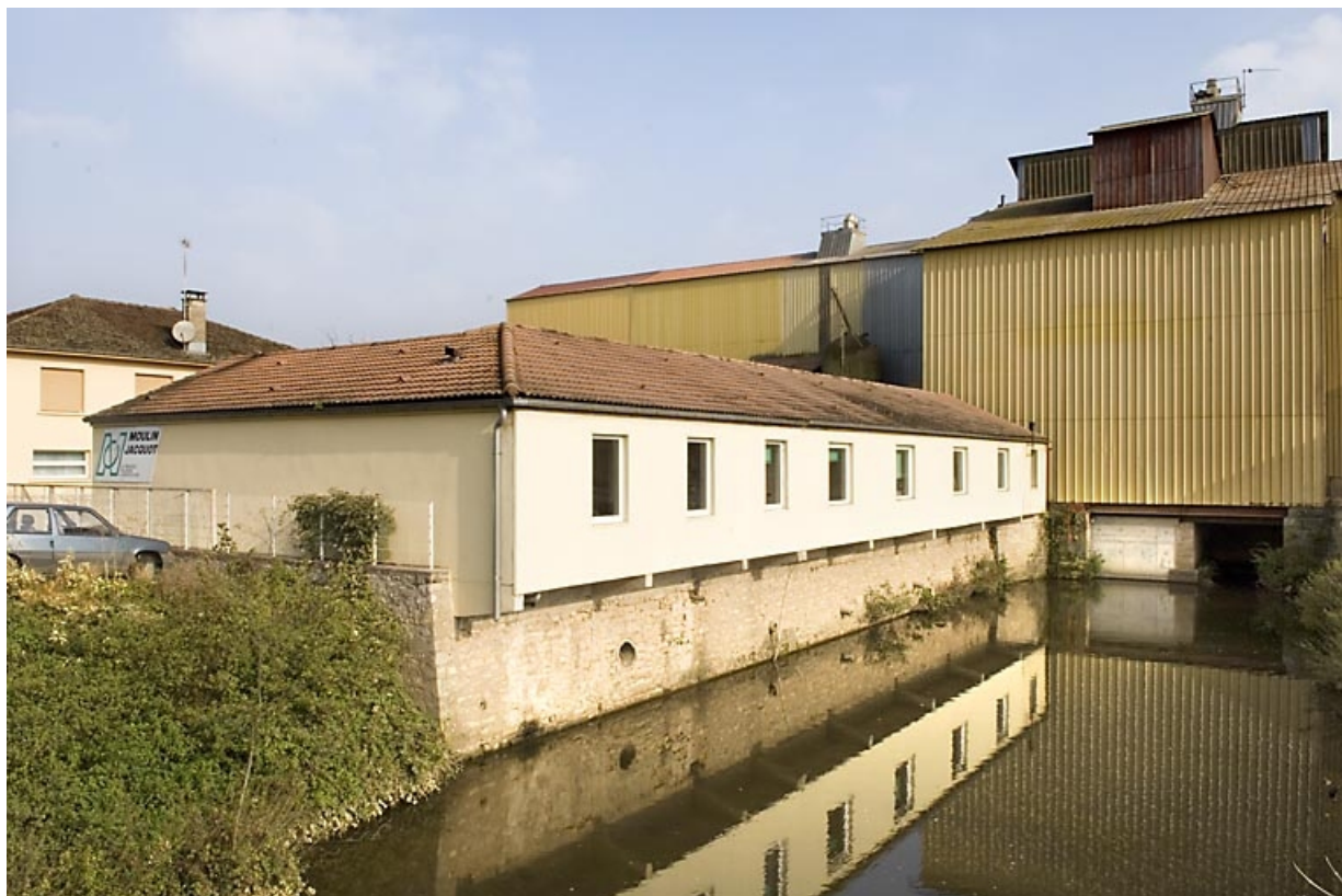
Bâtiment des bureaux sur le canal de fuite.
