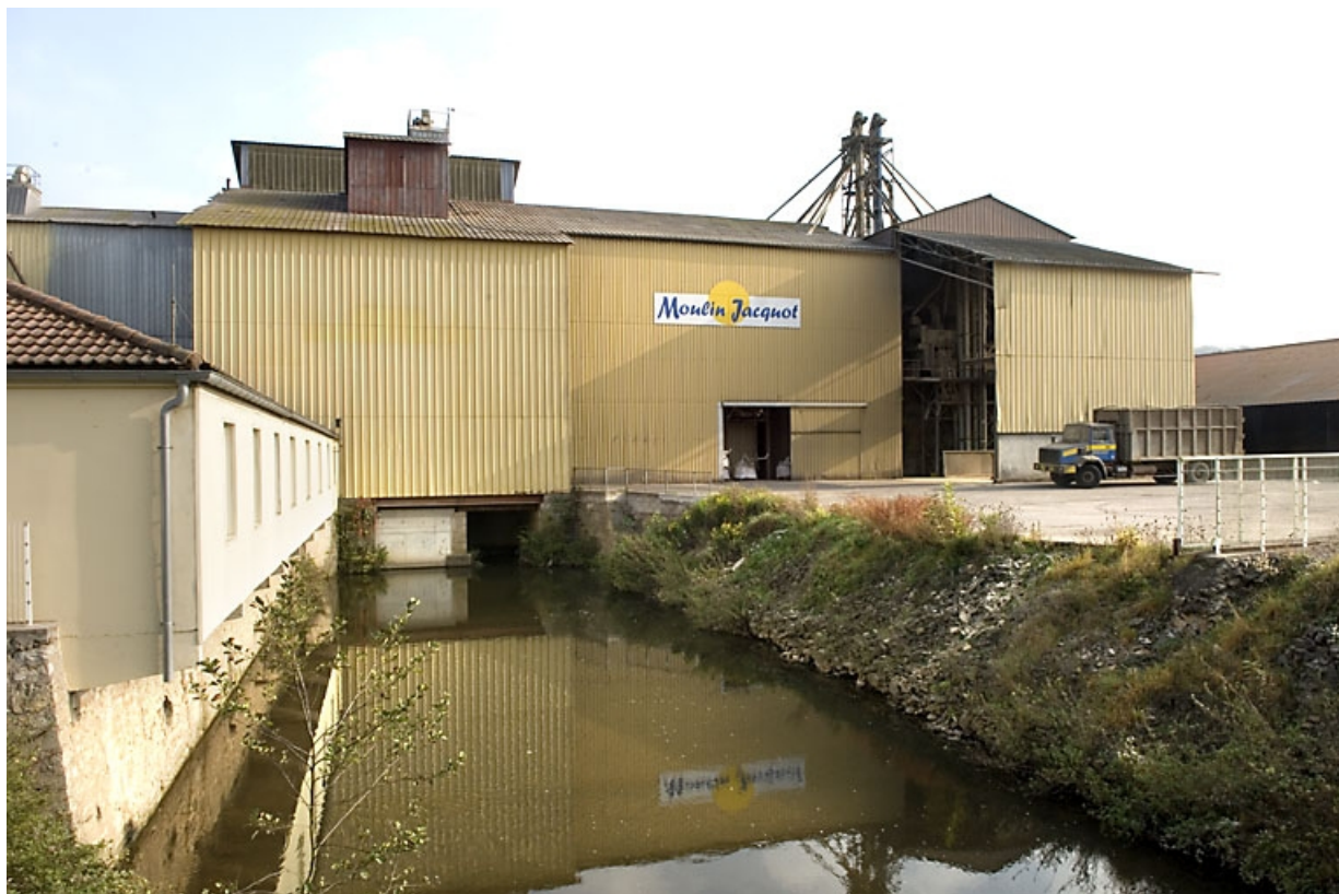
Canal de fuite et façade sud de la minoterie.
