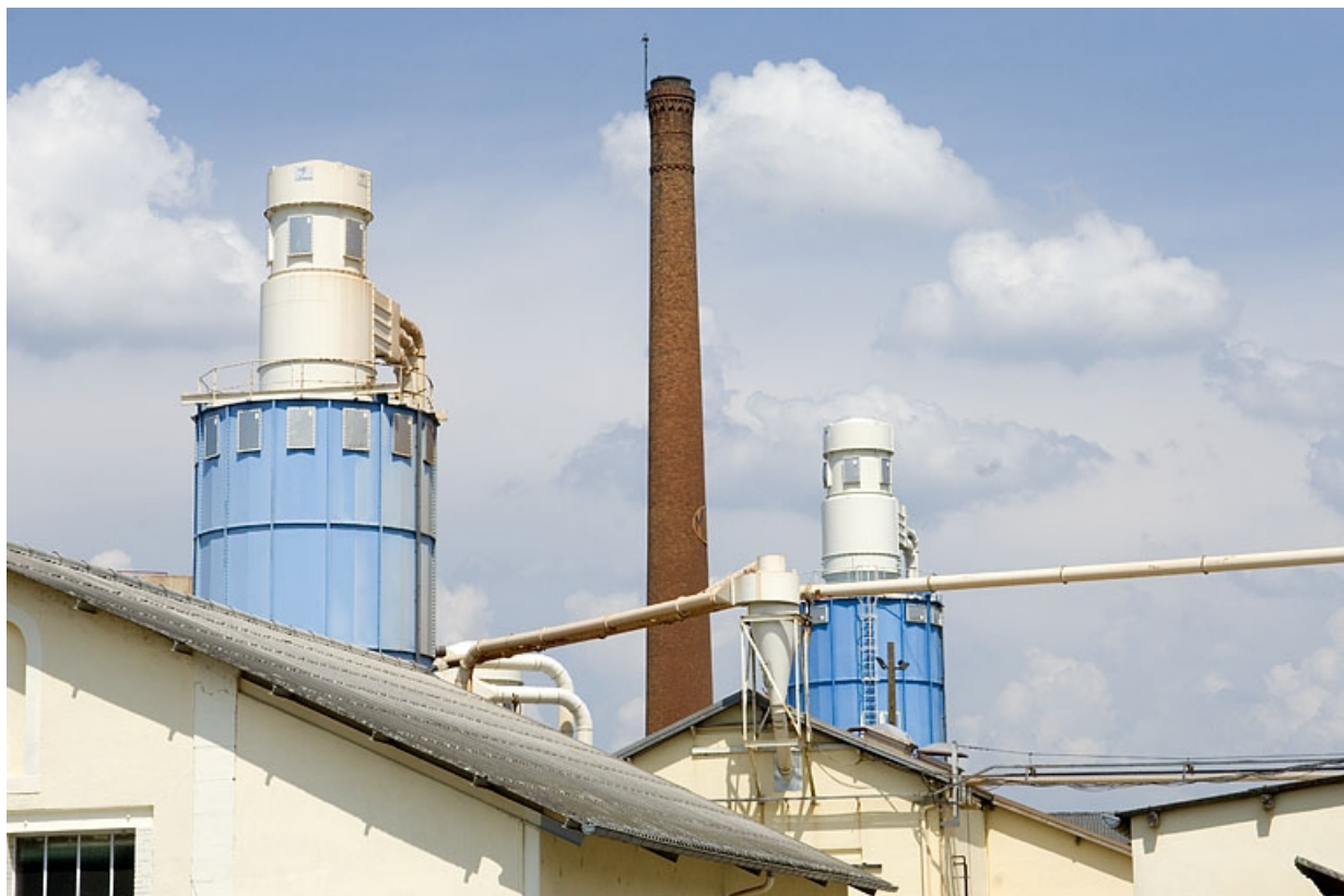
Silos et cheminée depuis le sud-ouest.
