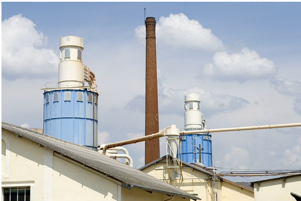
Silos et cheminée depuis le sud-ouest.
