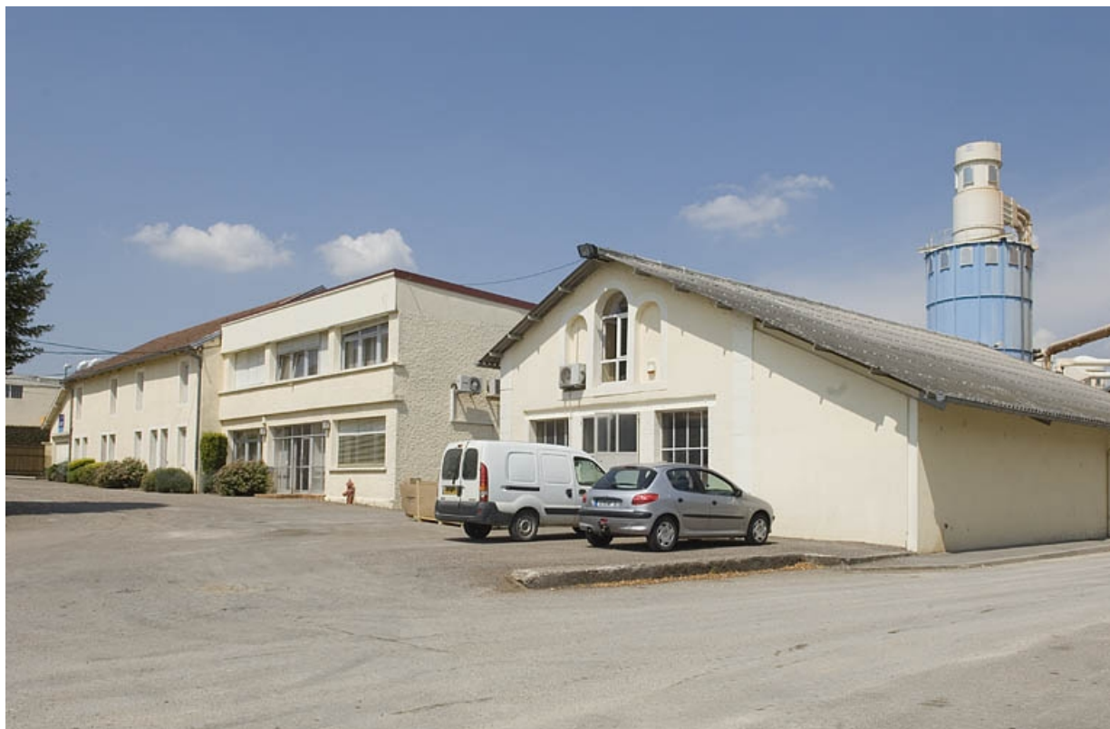
Logements, bureau et atelier de réparation depuis le sud.
