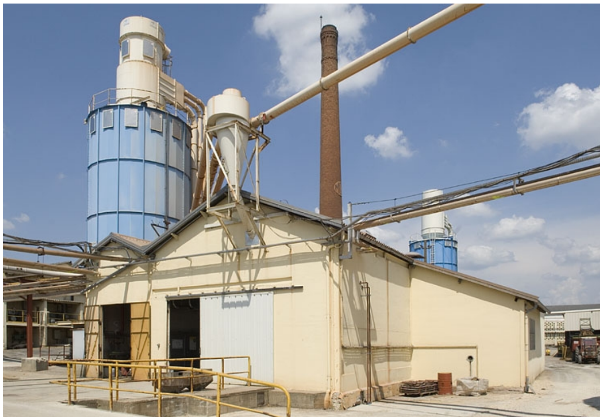
Salle des machines et chaufferie. 70, Jussey, 2 à 6 rue du 8 Mai 1945
