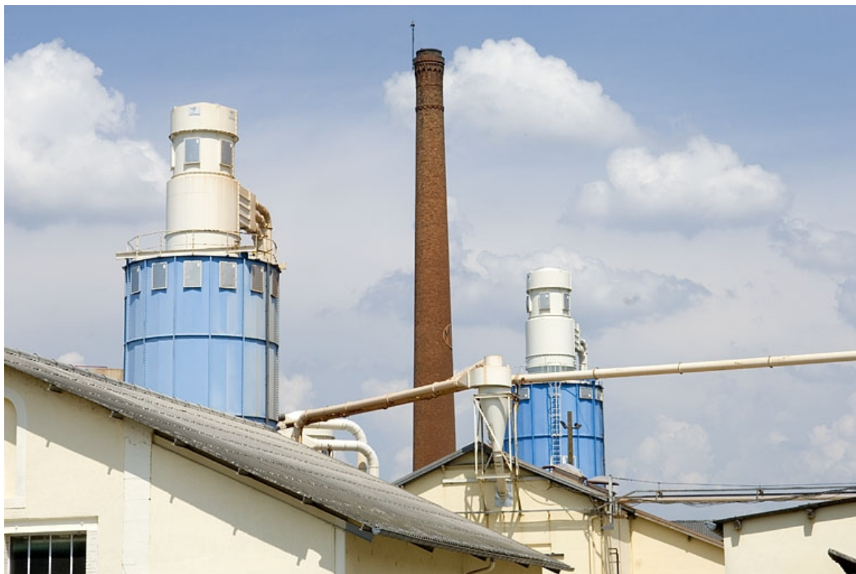
Silos et cheminée depuis le sud-ouest.
