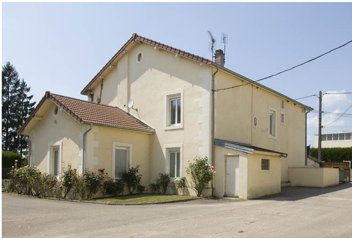
Logement (ancien bureau) vu de trois quarts arrière.
