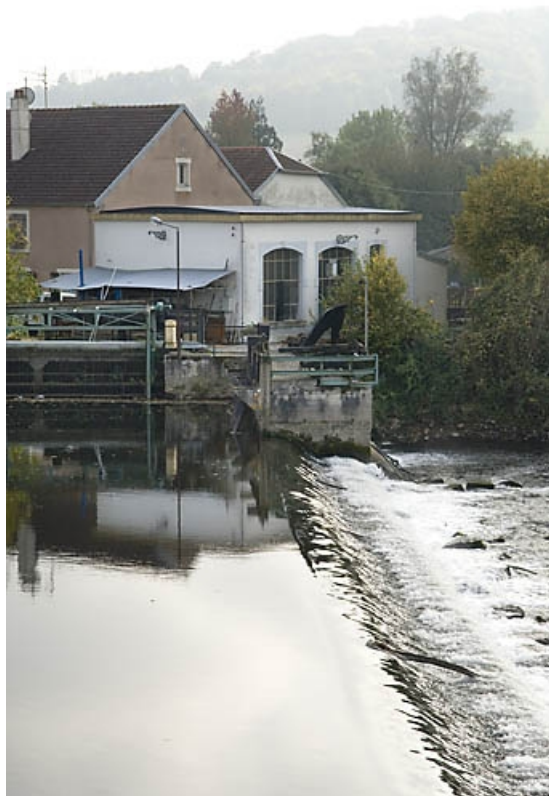
La centrale et le barrage depuis le pont.
