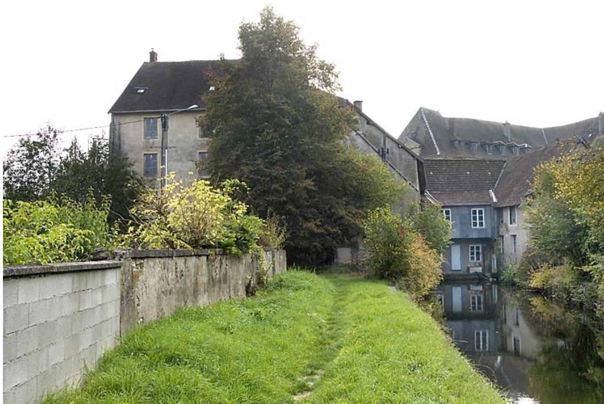
Façade postérieure depuis l'amont du bief.
