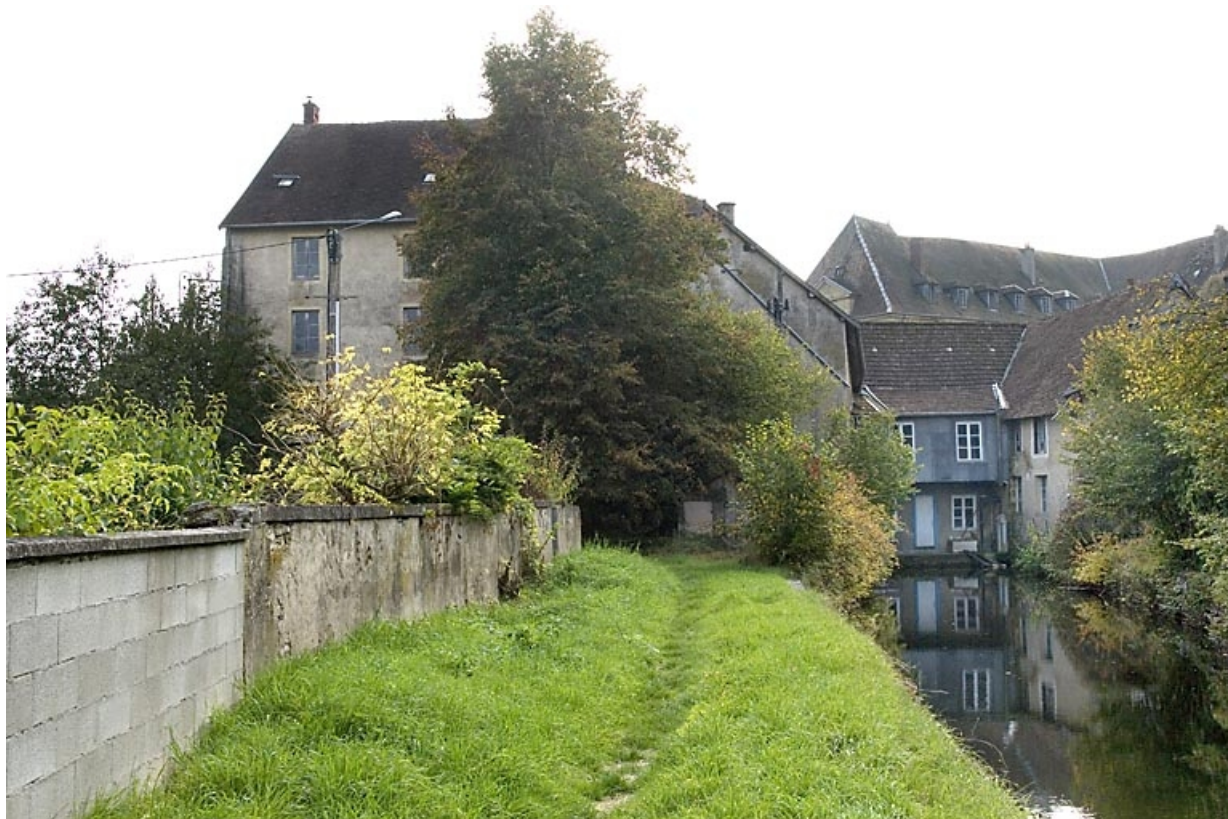
Façade postérieure depuis l'amont du bief.
