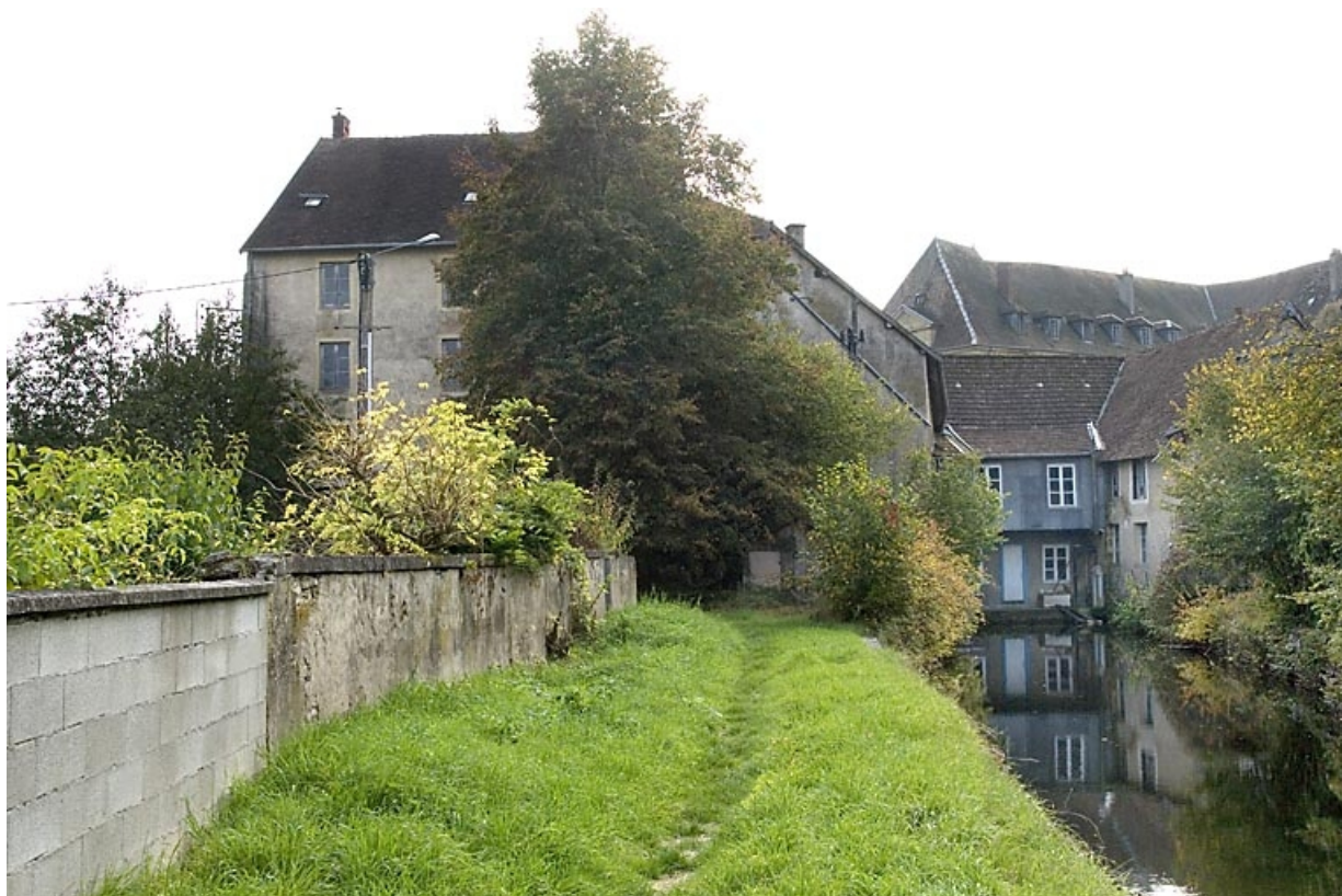
Façade postérieure depuis l'amont du bief.
