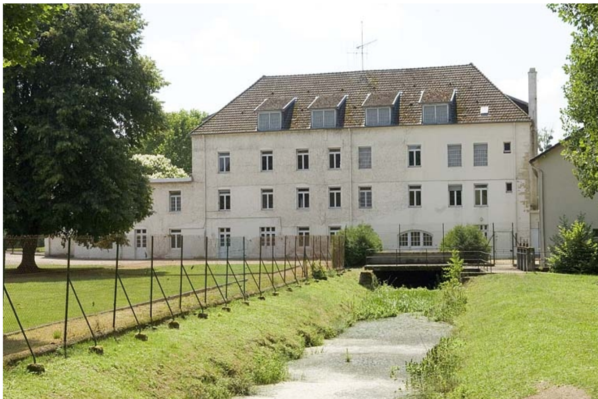
Façade antérieure depuis l'amont.
