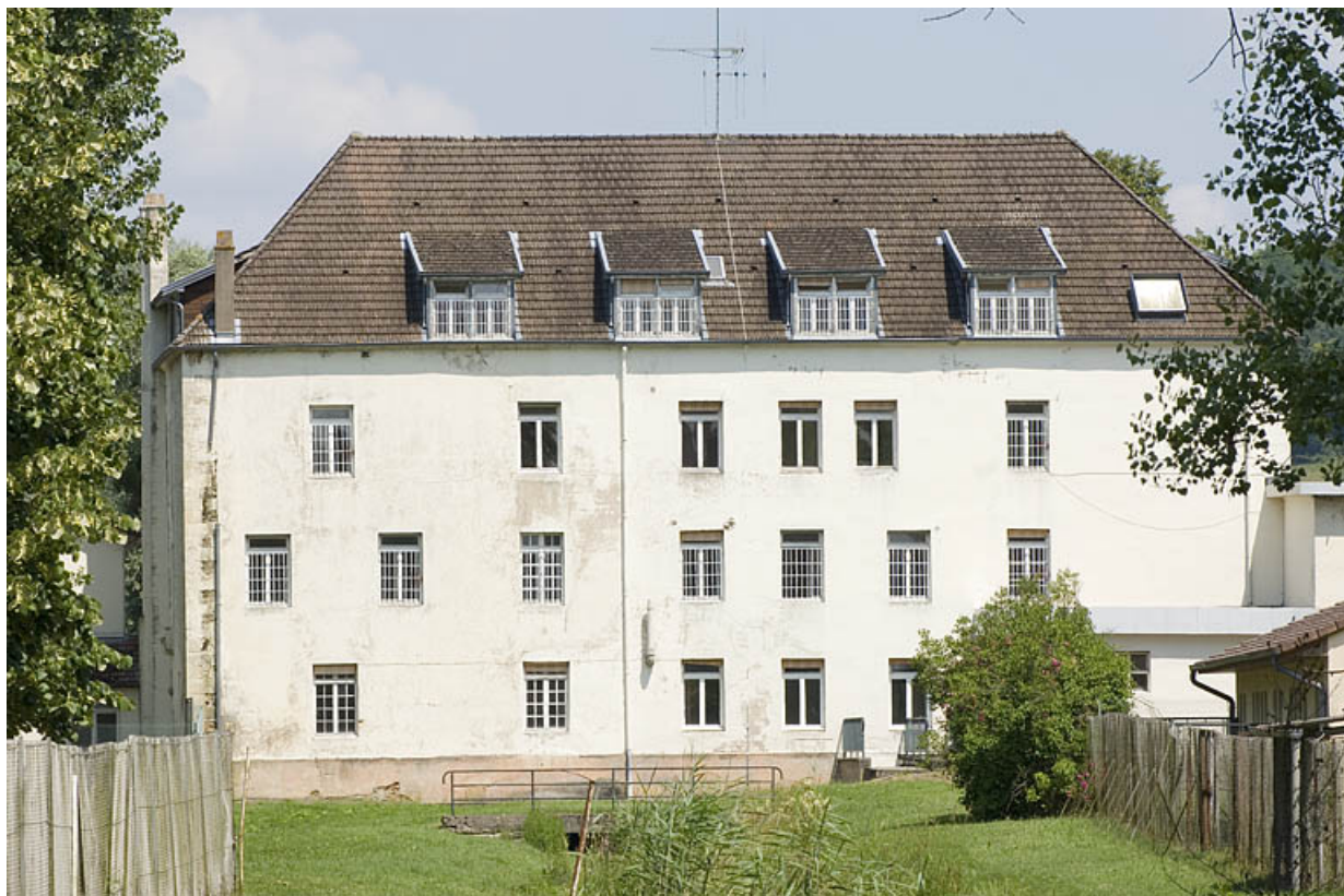
Façade postérieure depuis l'aval du bief.
