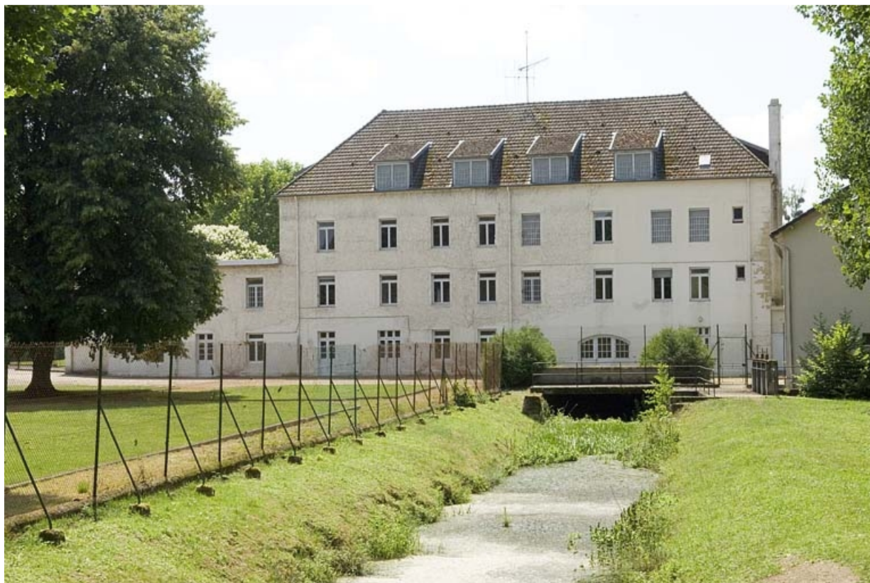
Façade antérieure depuis l'amont.
