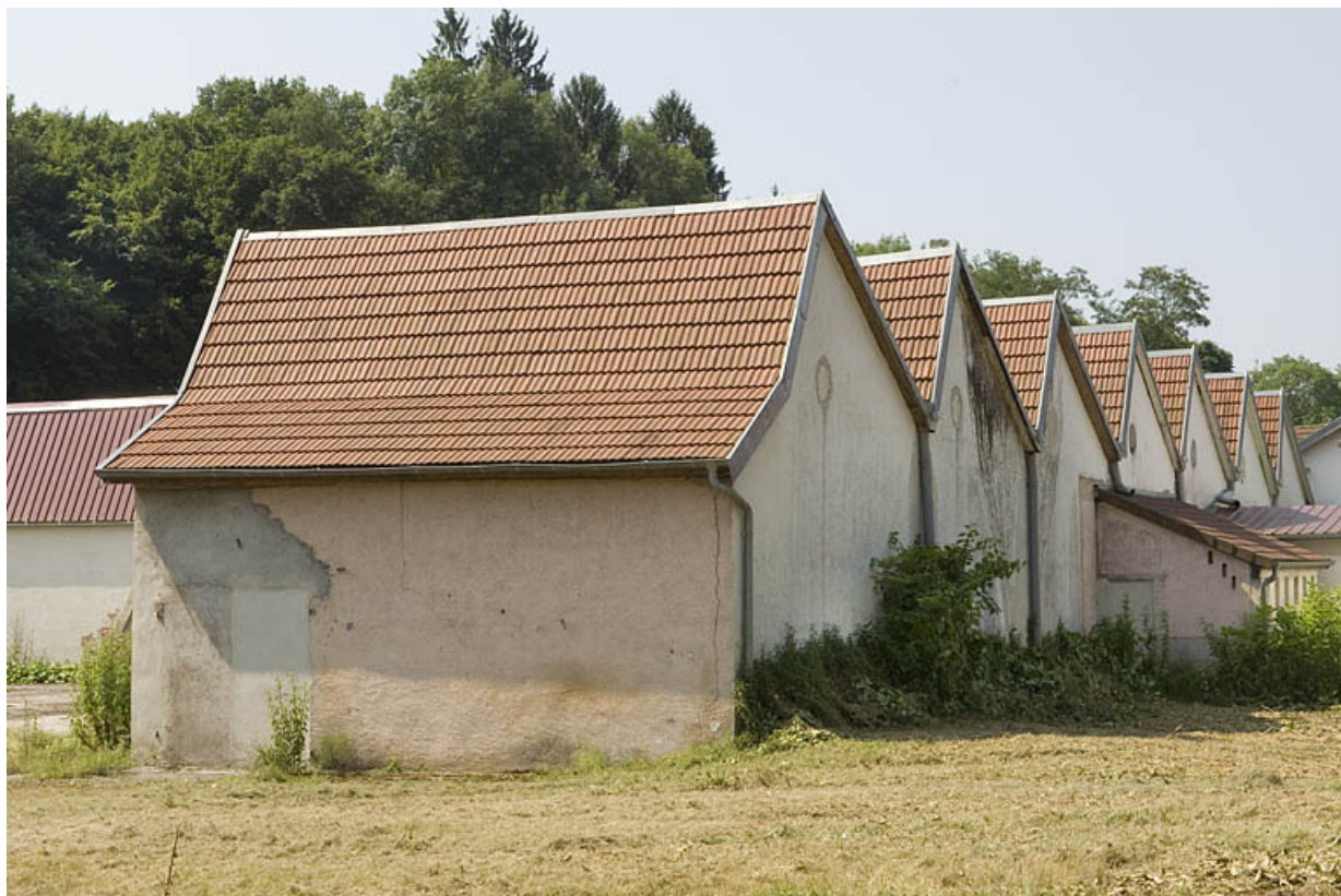
Atelier de fabrication couvert de sheds.
