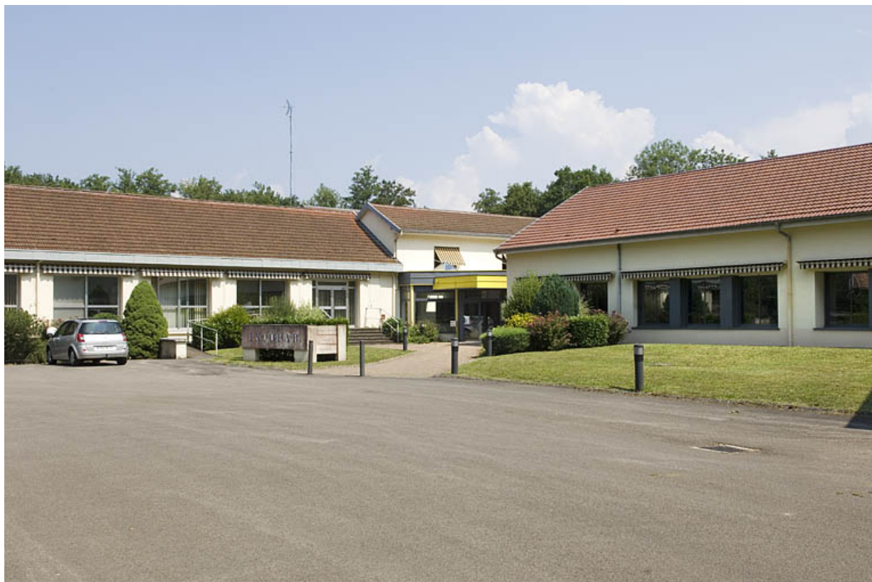
Vue d'ensemble depuis l'entrée.
