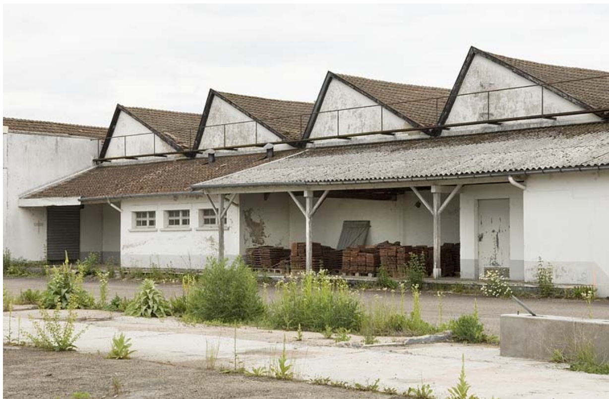
Détail des pignons des sheds de l'atelier de fabrication.
