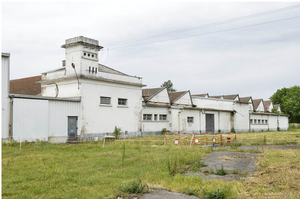
Façade est de l'atelier de fabrication.
