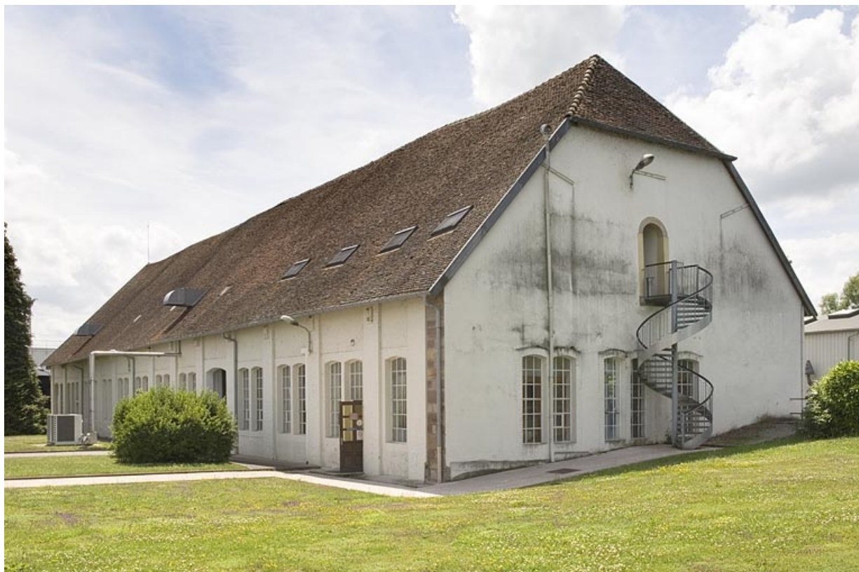
Atelier de fabrication dit forge neuve. Vue de trois quarts.
