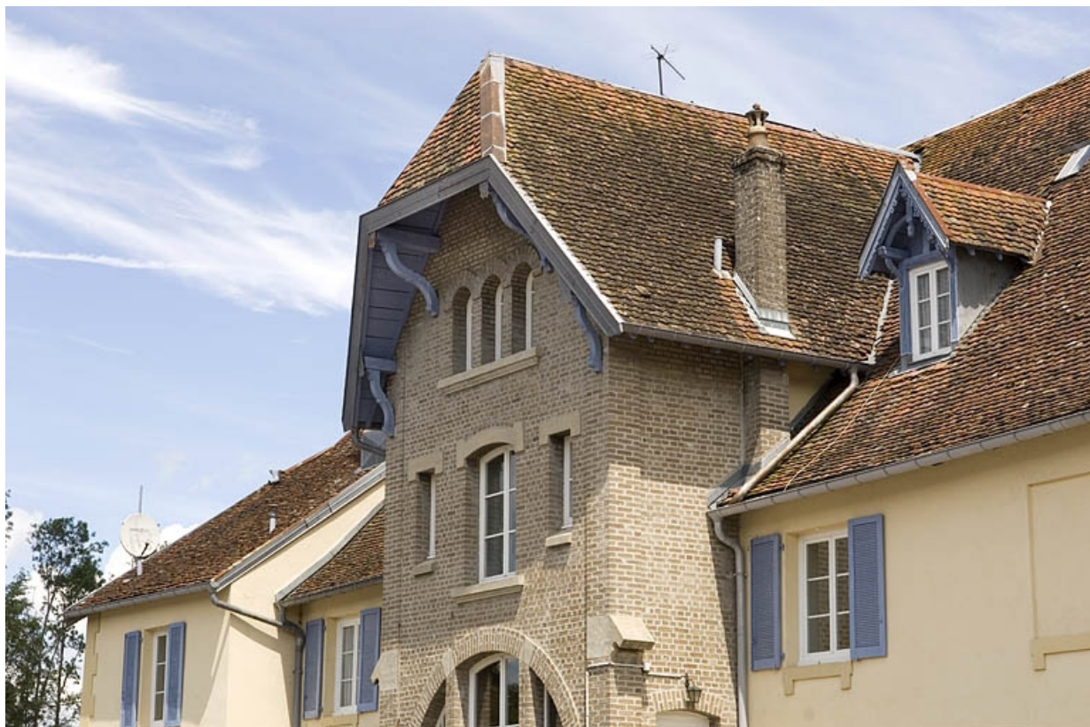
Façade ouest du logement patronal. Détail du corps central. Vue de trois quarts. 70, Magny-Vernois, 17 rue de la Forge, lieudit : la Forge
