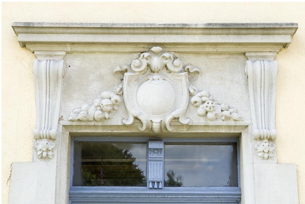
Logement patronal. Linteau sculpté d'une porte sur la façade est.
