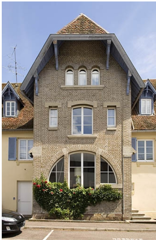
Façade ouest du logement patronal. Détail du corps central. Vue de face.
