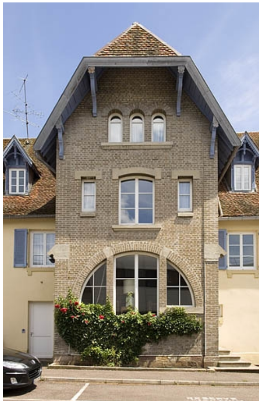
Façade ouest du logement patronal. Détail du corps central. Vue de face.
