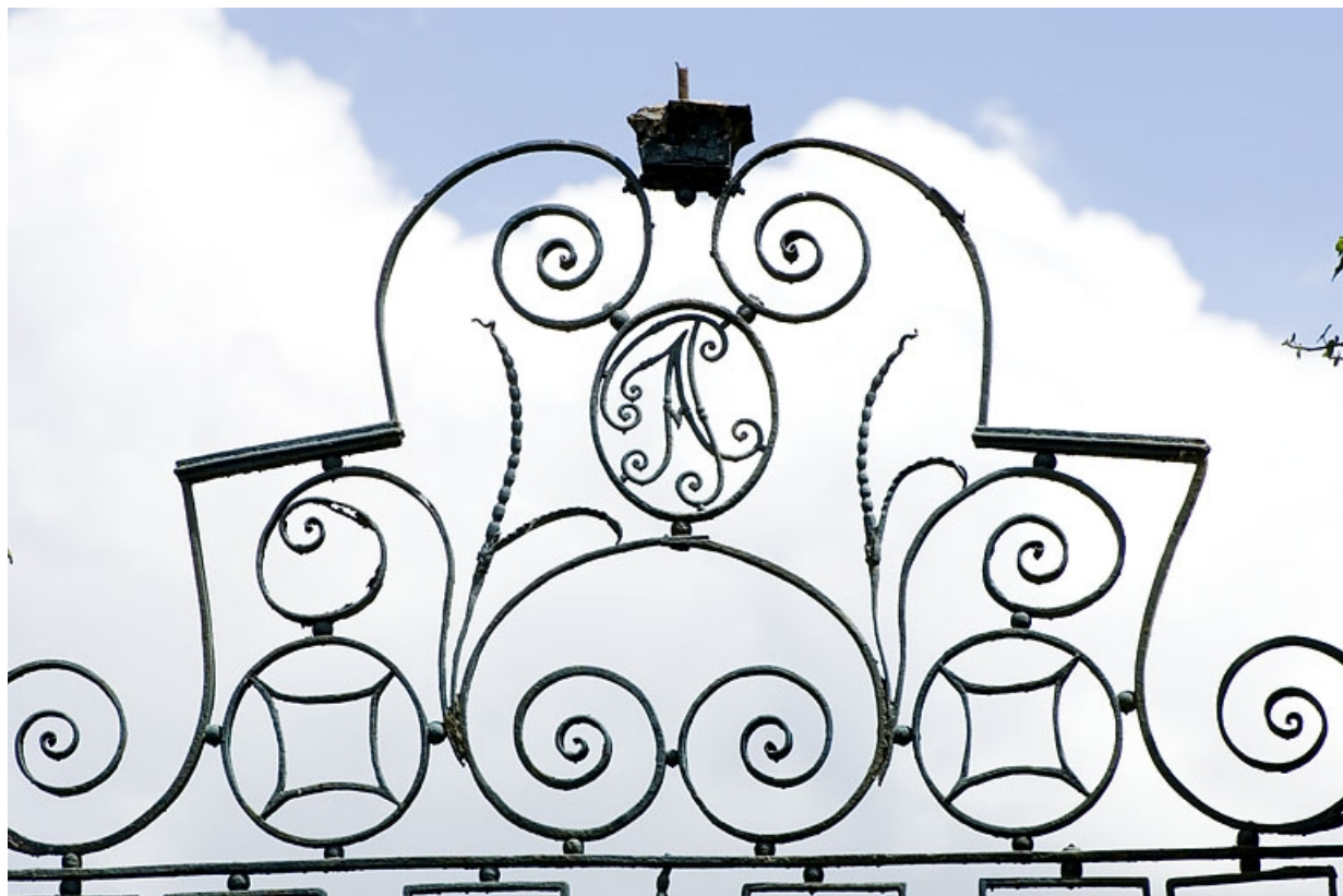
Grille en ferronnerie du portail du parc. Partie supérieure. 70, Magny-Vernois, 17 rue de la Forge, lieudit : la Forge
