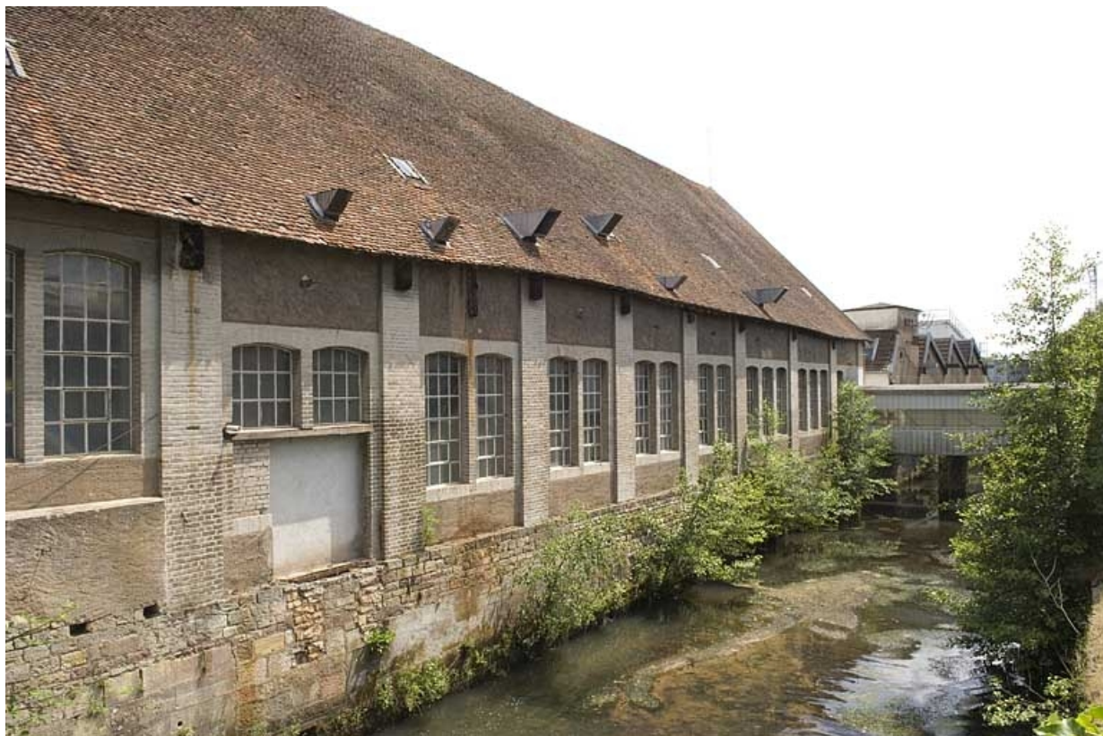
Façade ouest de l'atelier de fabrication dit forge neuve.
