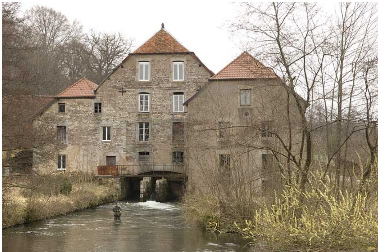
Vue rapprochée depuis l'aval du bief.
