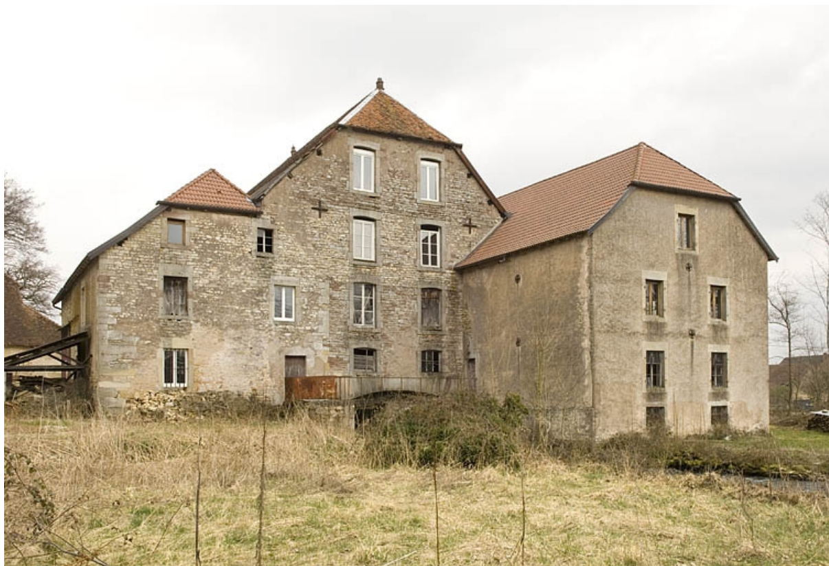
Vue de trois quarts, depuis l'ouest.
