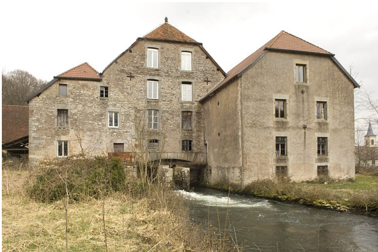
Vue rapprochée depuis la rive droite.
