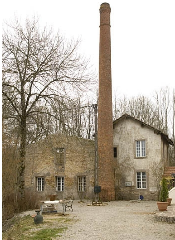
Cheminée, chaufferie et salle des machines depuis le nord.
