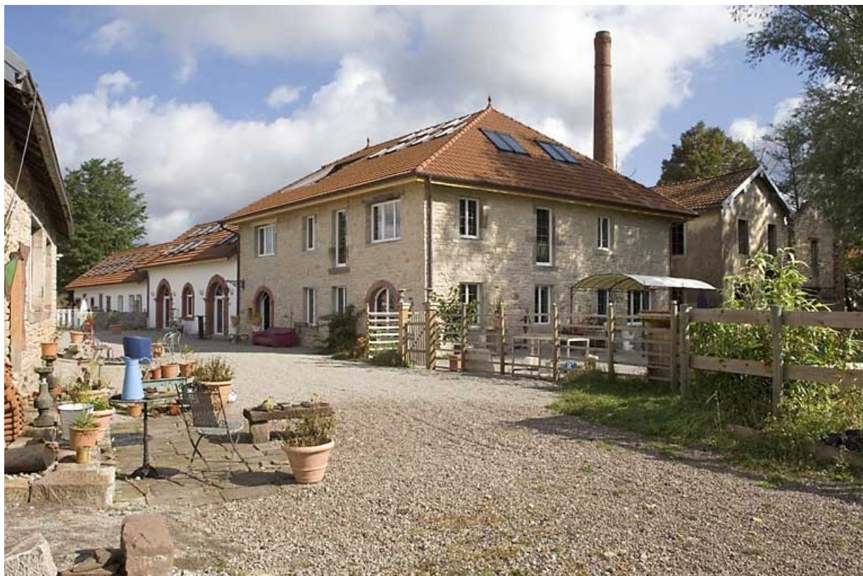
Atelier de fabrication, logement et salle de machines depuis le sud. 70, Vouhenans route de Magny-Vernois
