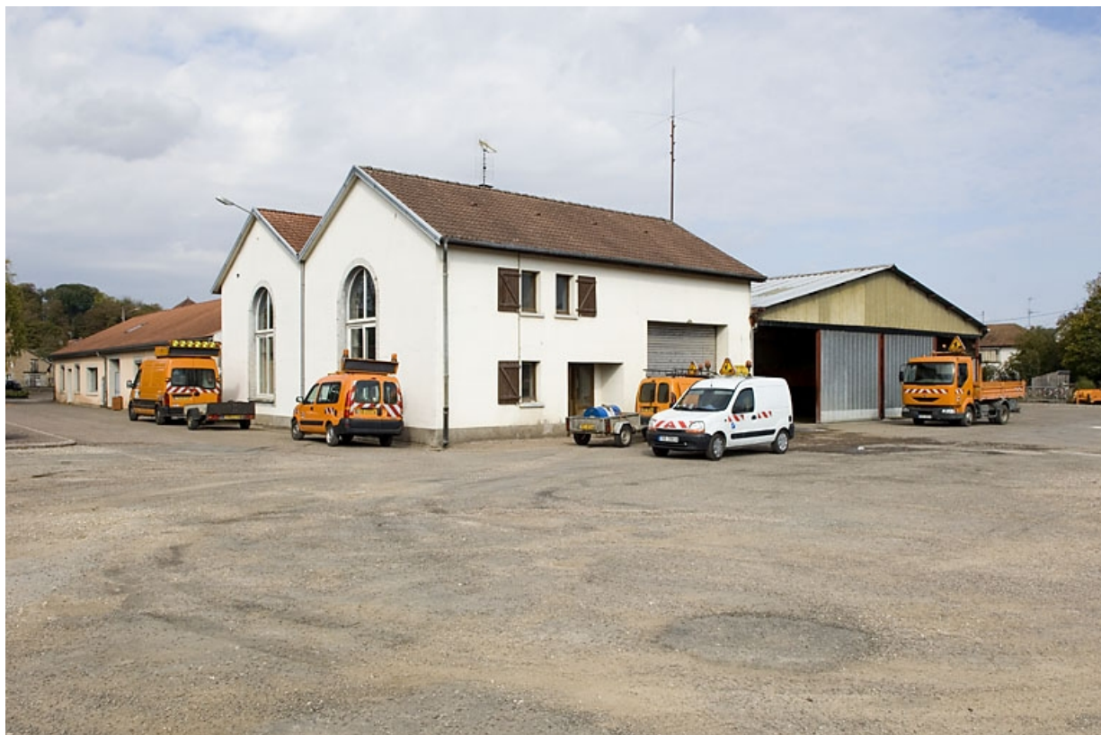
Vue d'ensemble depuis le sud.
