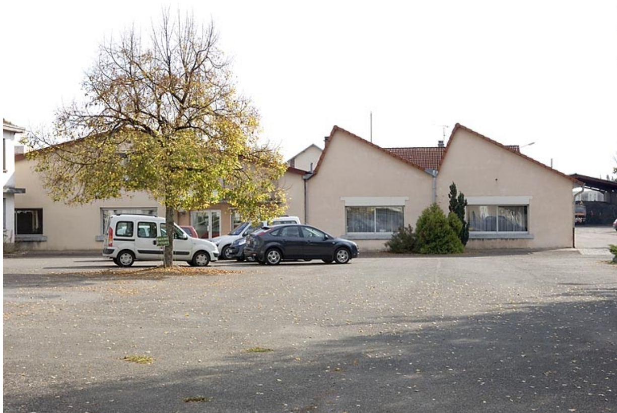
Murs pignons de l'atelier de fabrication depuis le nord-ouest.
