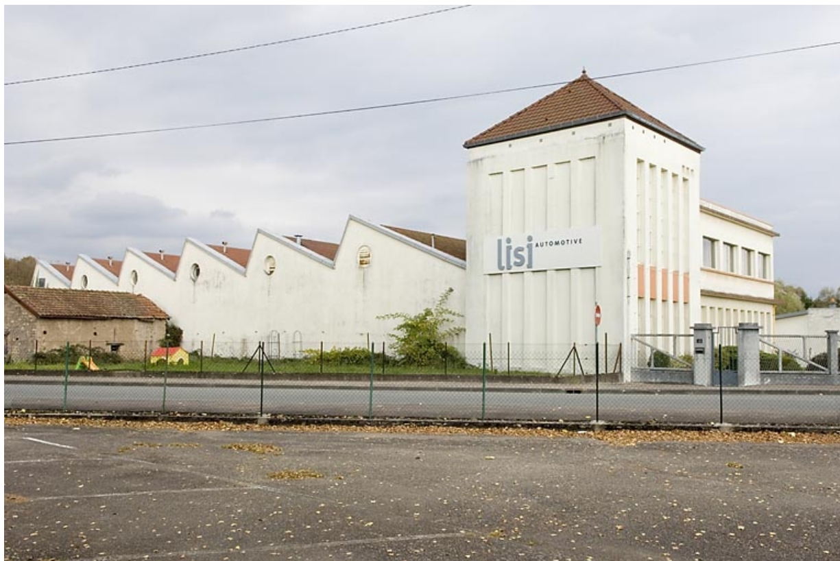
Vue d'ensemble depuis le sud.
