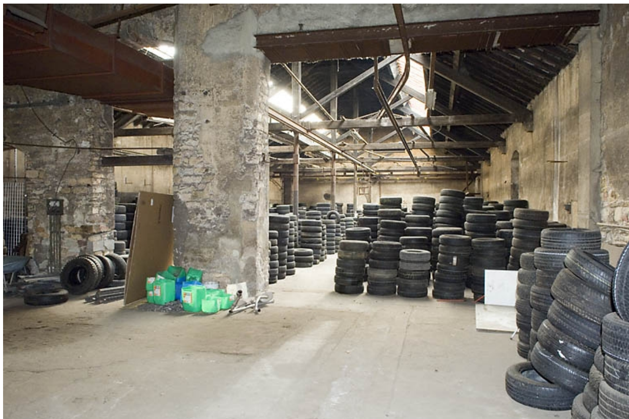
Vue intérieure de l'atelier de fabrication.
