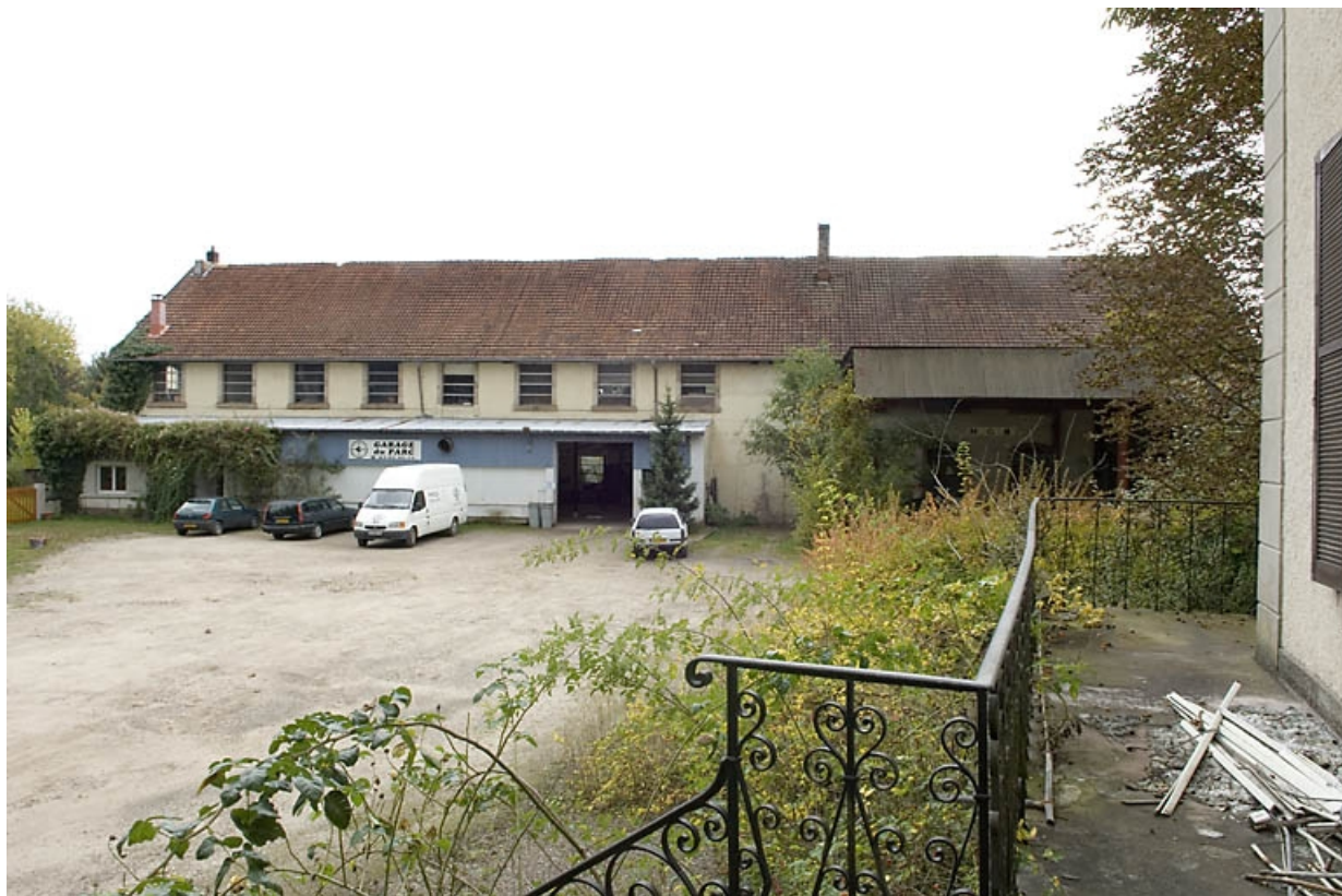
Atelier de fabrication. Vue depuis le nord-ouest. 70, Lure, 7 rue Antoine Boisson
