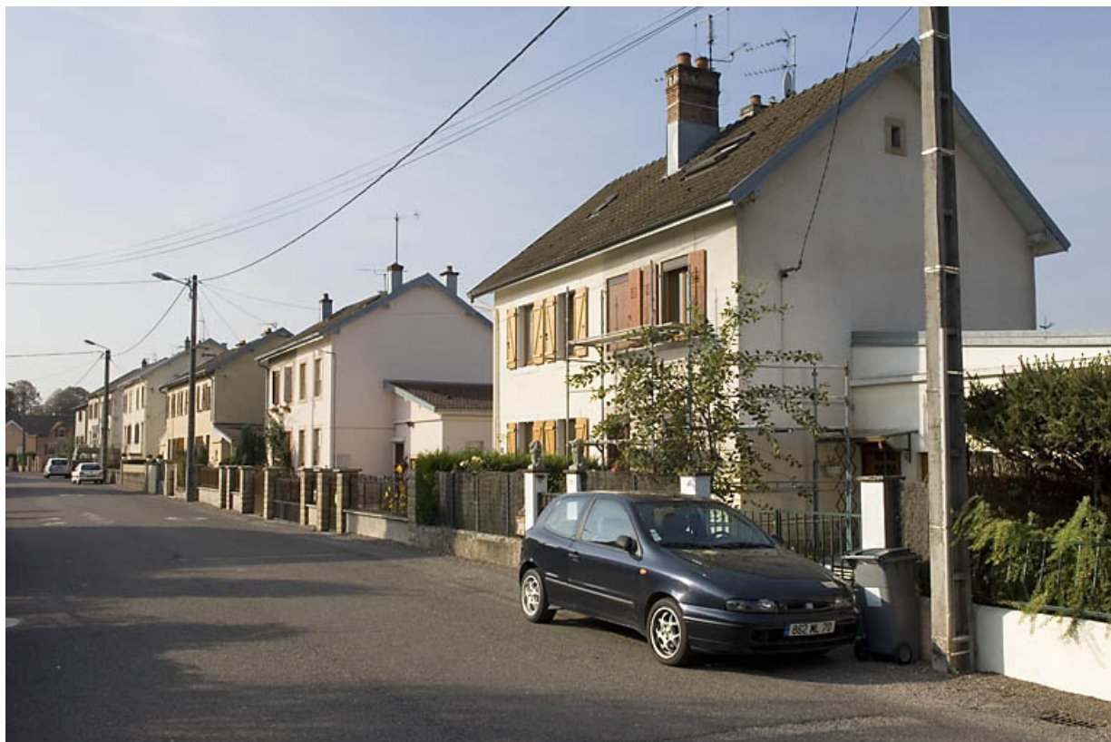
Logements ouvriers (rue Saint-Quentin). Vue depuis le nord. 70, Lure rue de la Métairie
