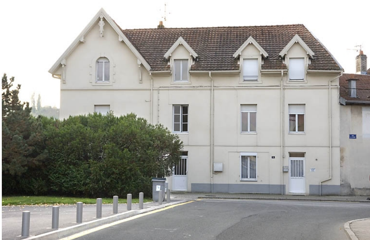
Logement ouvrier (?). Vue de face.
