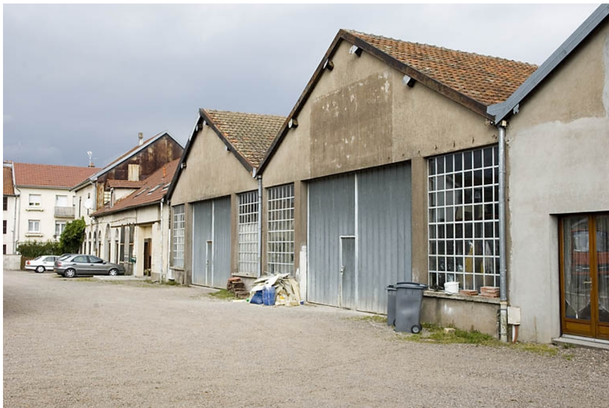
Façades et murs-pignons des ateliers de fabrication. Vue depuis le sud. 70, Lure, 14, 16 rue des Gleux
