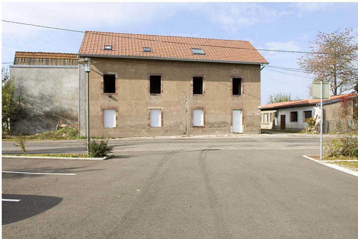
Ancien atelier de fabrication (?). Façade sur rue.
