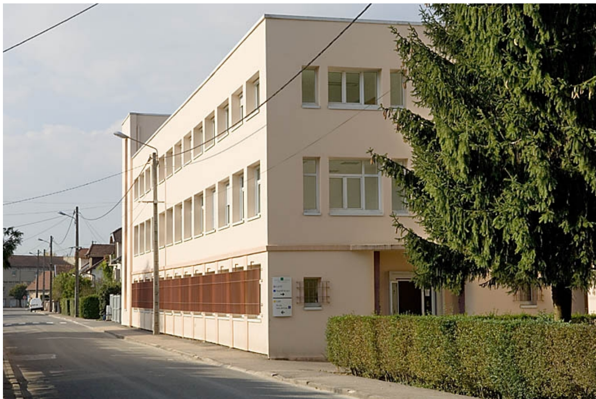
Façade antérieure vue de trois quarts.
