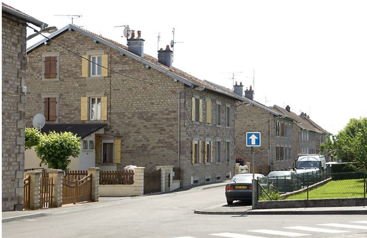
Logements d'ouvriers (rue du Tissage). 70, Luxeuil-les-Bains rue Louis Pergaud
