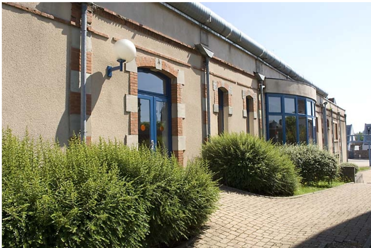
Façade sud de l'atelier de fabrication.
