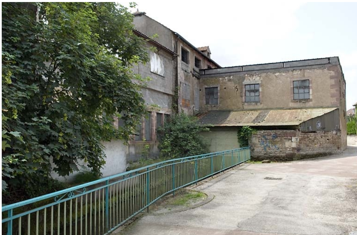
Façades postérieures donnant sur le bief. 70, Luxeuil-les-Bains, 21 rue des Cannes
