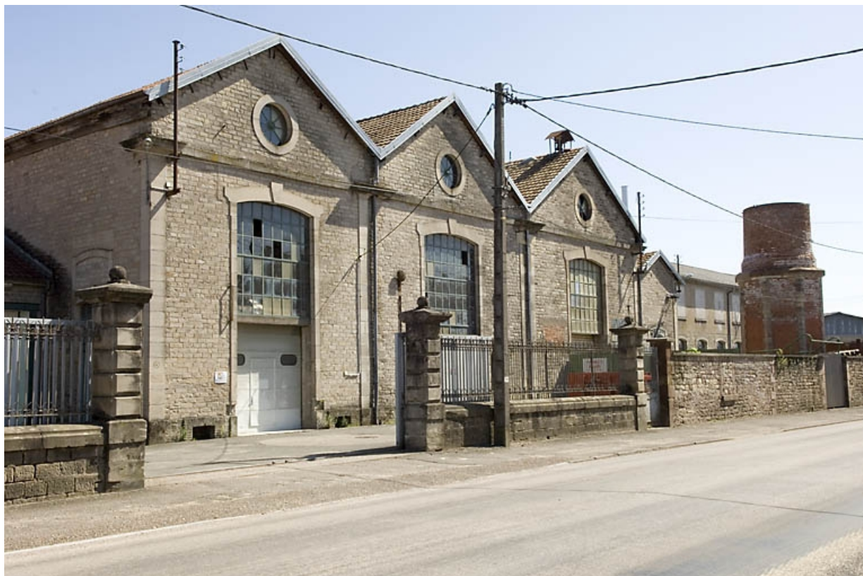
Murs-pignons de la salle des machines. Vue de trois quarts.
