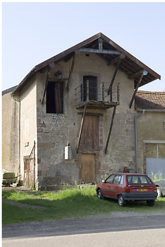
Façade de l'entrepôt industriel. 70, Baudoncourt rue de la Chapelle
