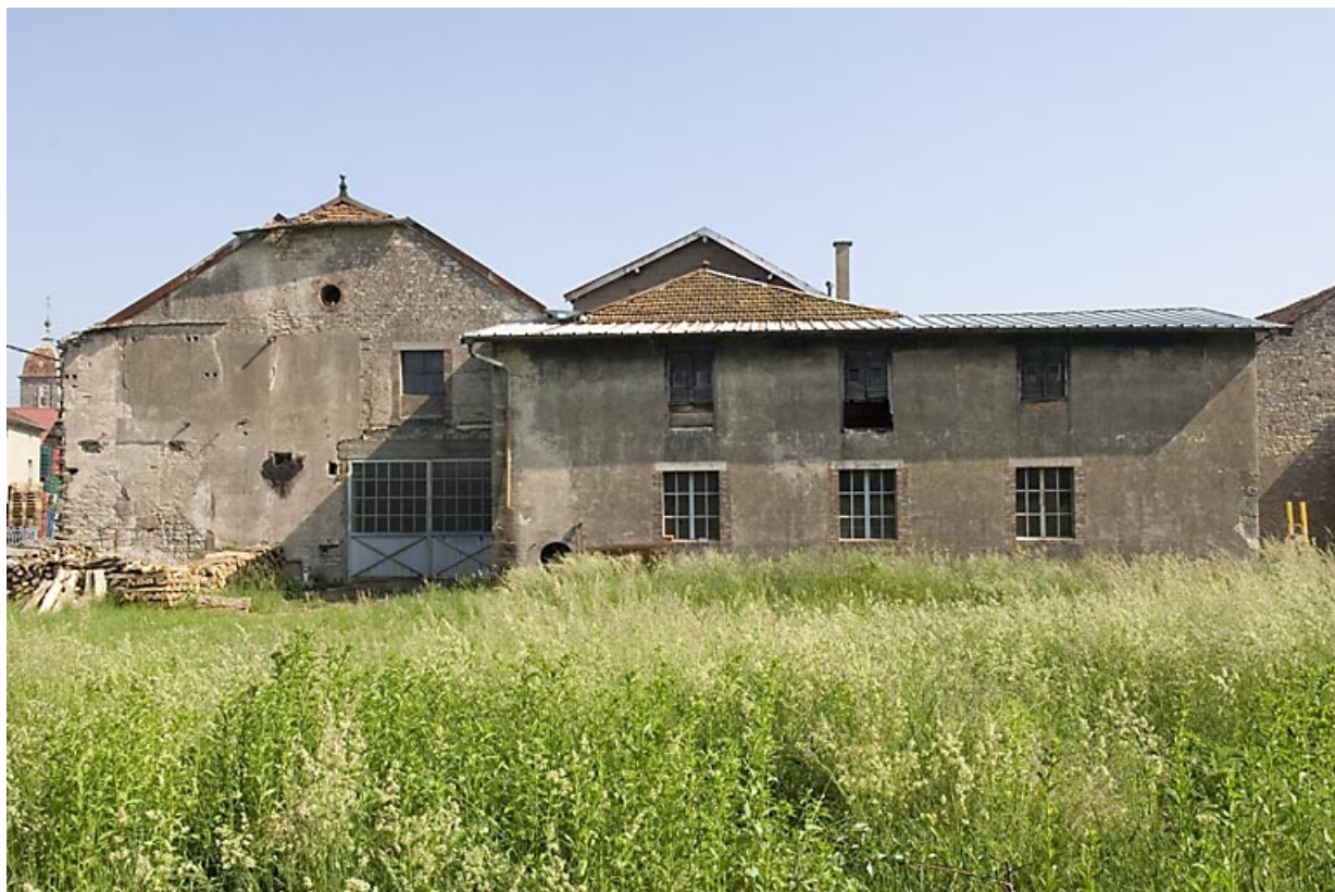
Façades postérieures de la féculerie.
