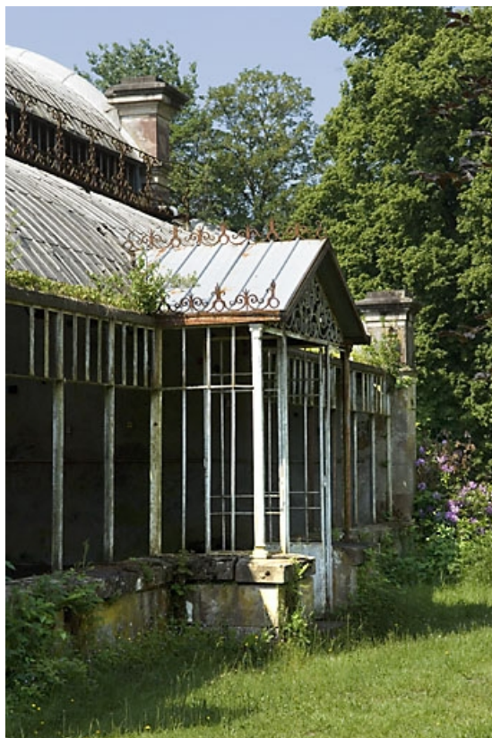
Serre. Détail de la façade nord.
