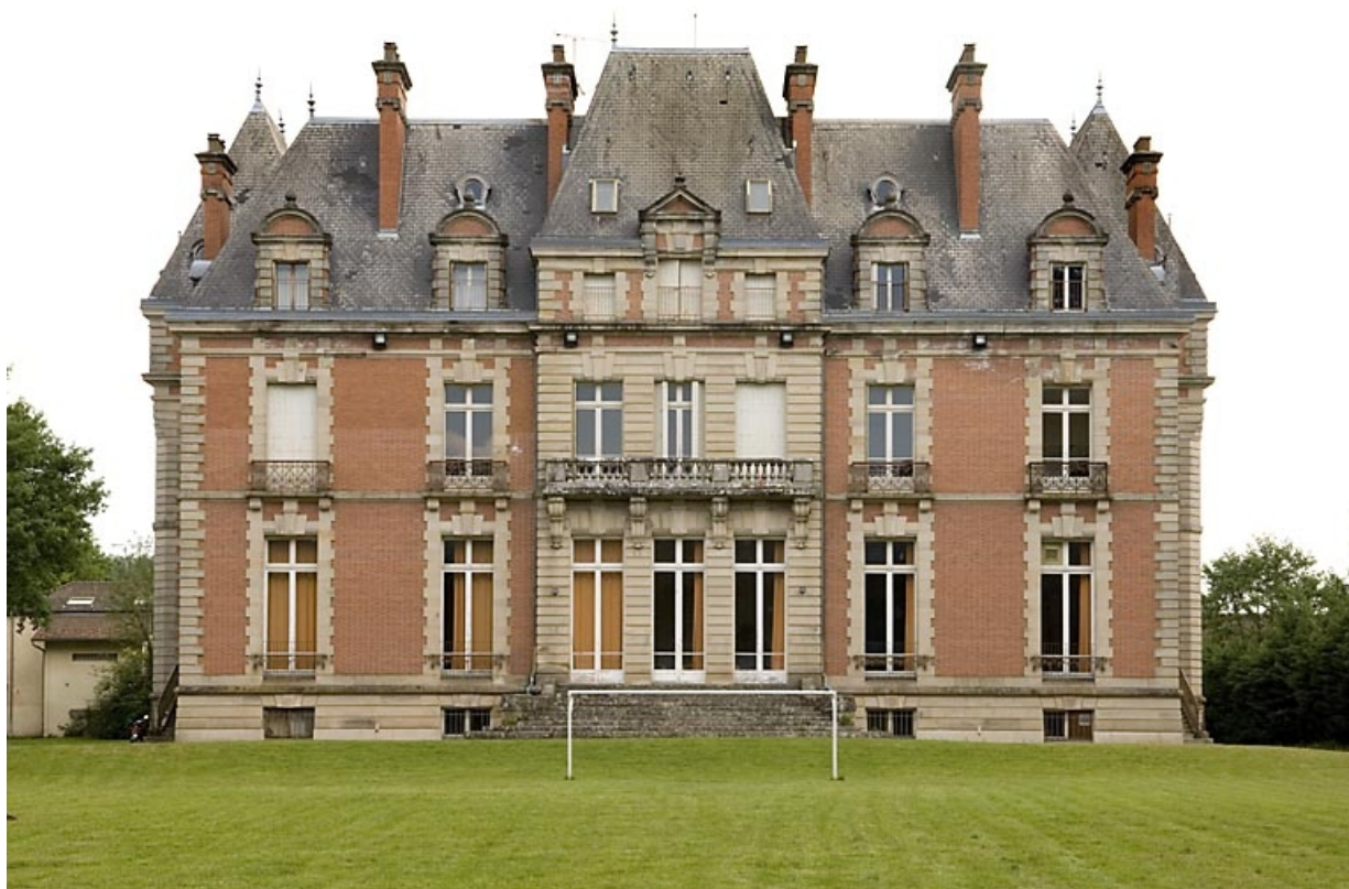
Logement patronal. Façade postérieure.
