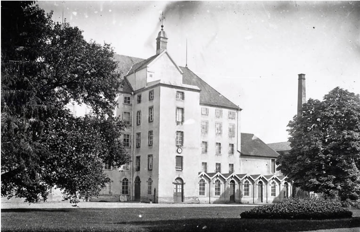
Élévation ouest de l'ancienne filature.
