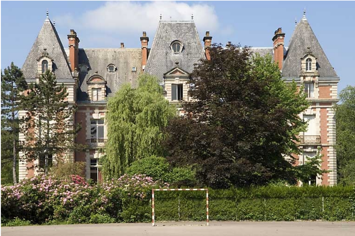
Logement patronal. Façade antérieure.
