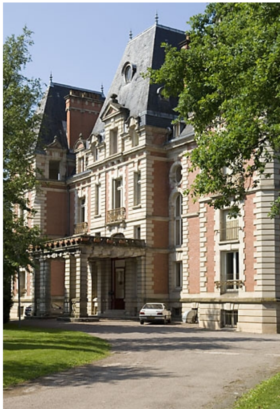
Logement patronal. Façade antérieure vue de trois quarts. 70, Breuches R.D. 6
