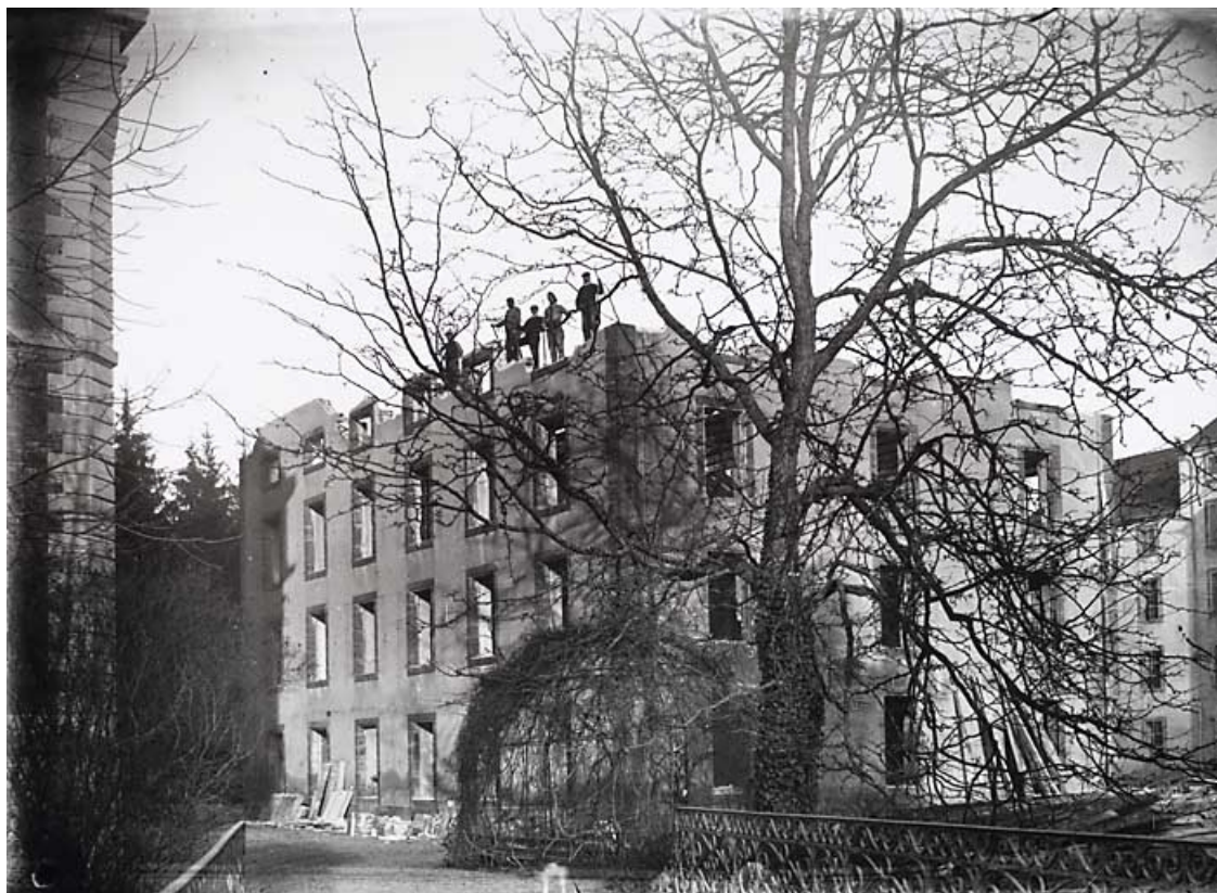
Démolition de l'ancienne filature.
