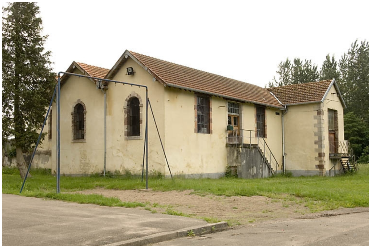
Centrale hydroélectrique. Vue de trois quarts.
