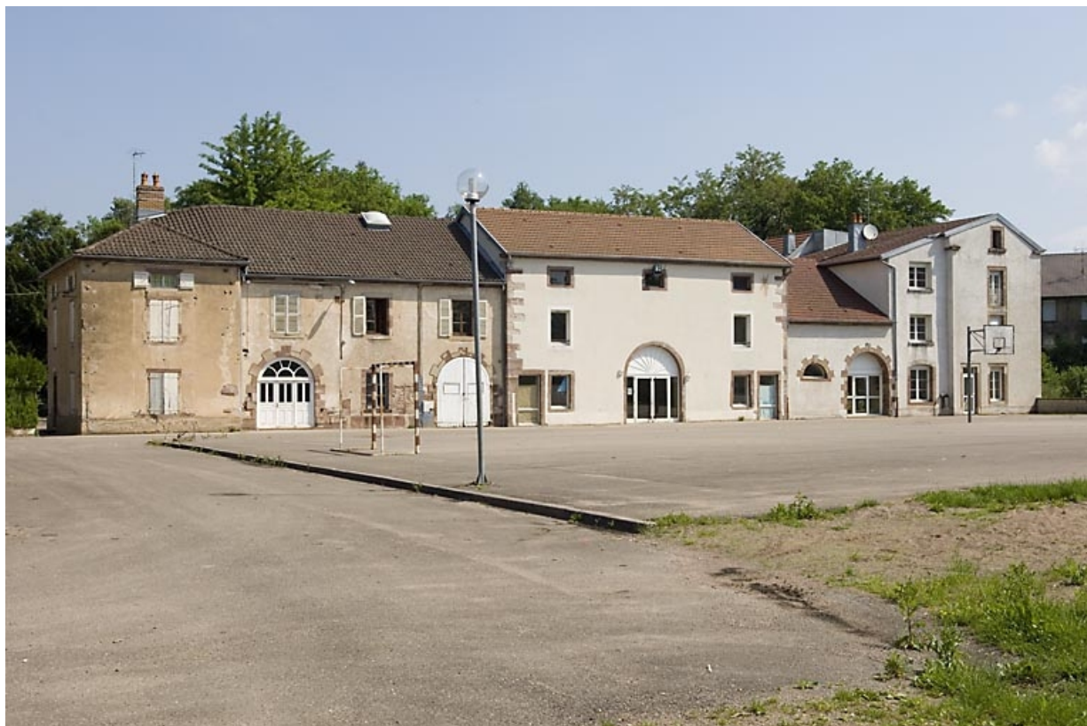
Bureaux, logements et remises. Vue depuis le sud.
