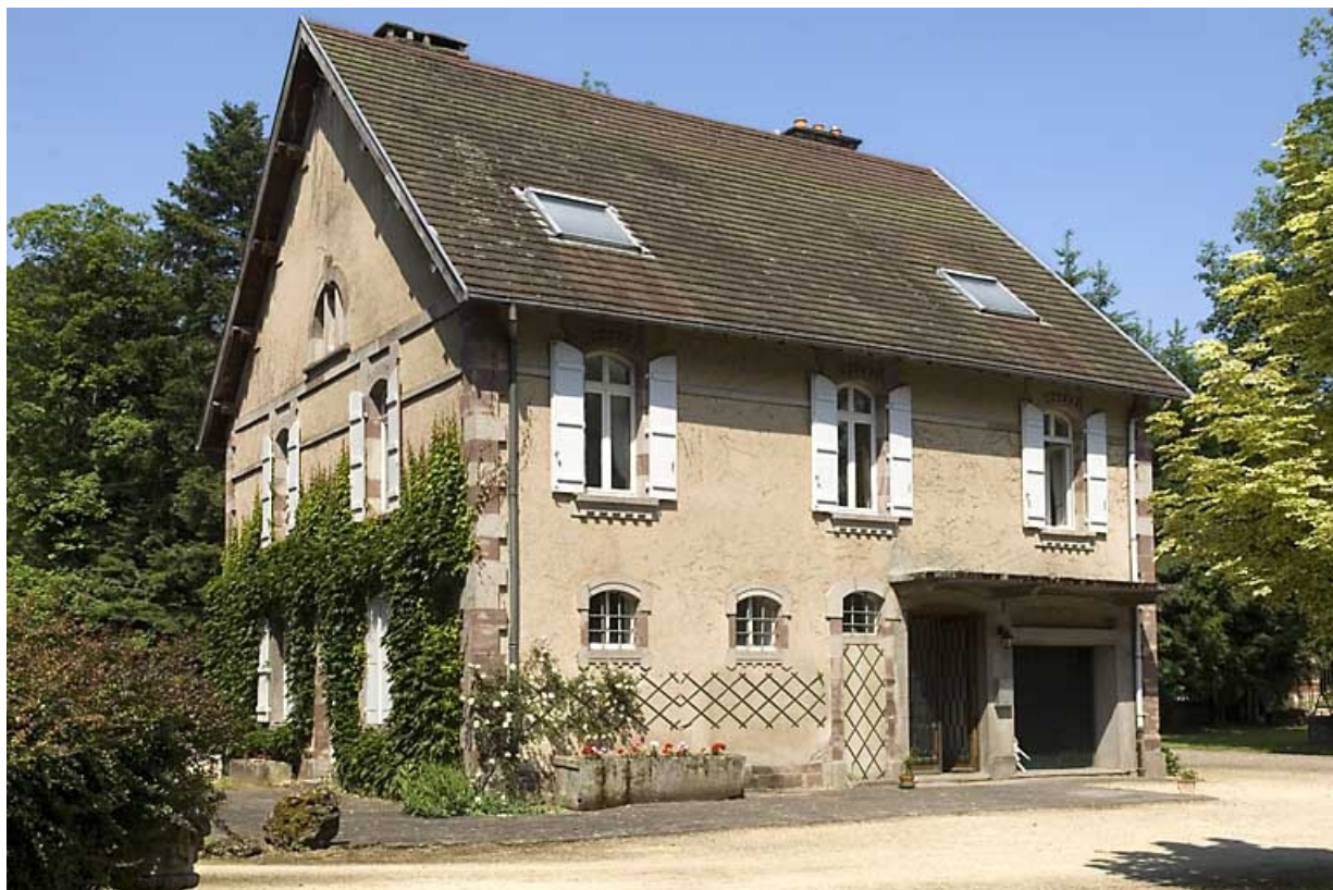
Logement (ancien chenil). Vue de trois quarts. 70, Breuches R.D. 6
