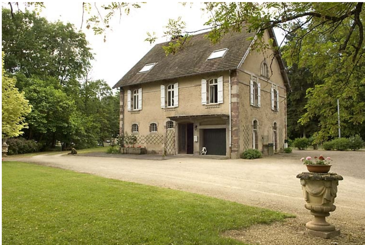
Logement (ancien chenil). Vue de trois quarts arrière.
