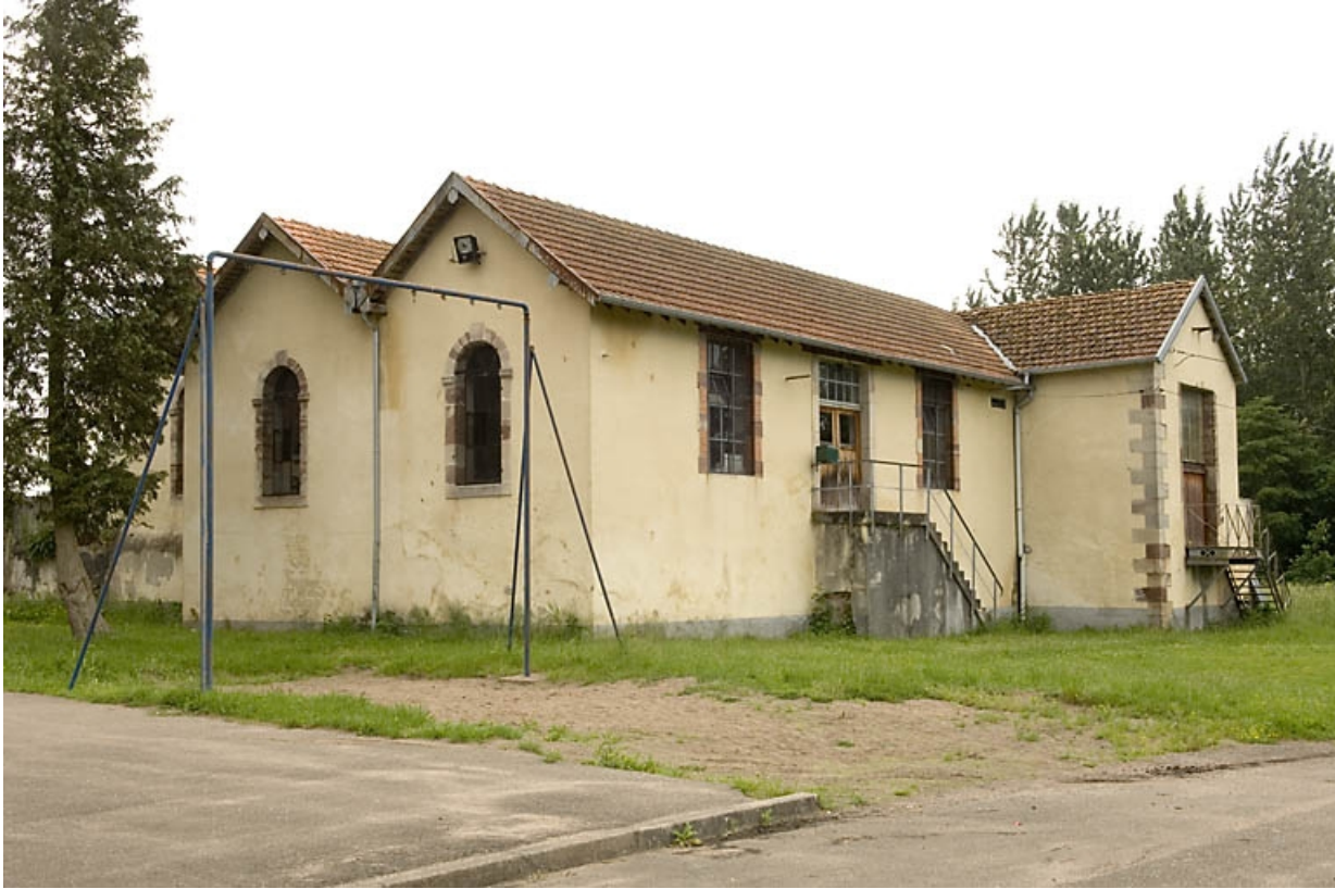
Centrale hydroélectrique. Vue de trois quarts. 70, Breuches R.D. 6
