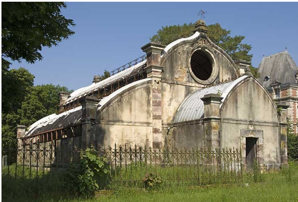
Serre. Vue depuis le sud-est.
