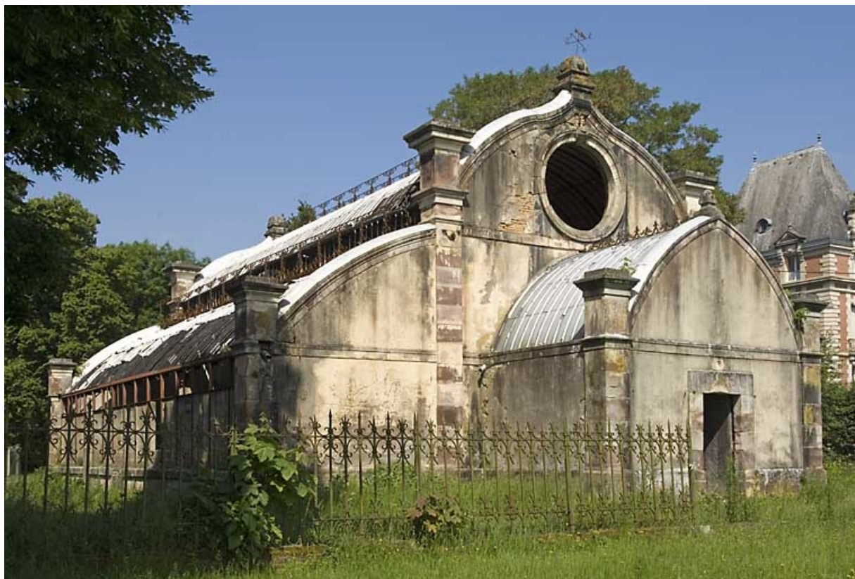
Serre. Vue depuis le sud-est.
