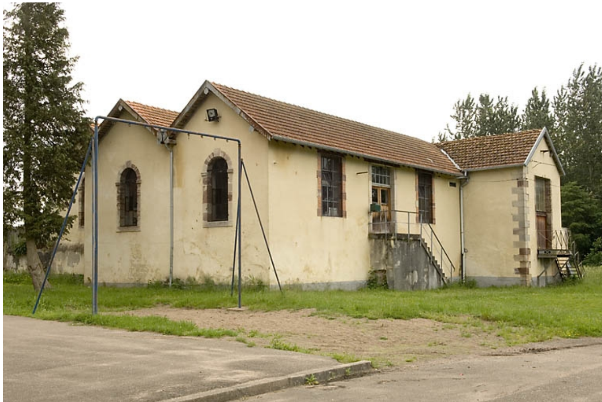
Centrale hydroélectrique. Vue de trois quarts.
