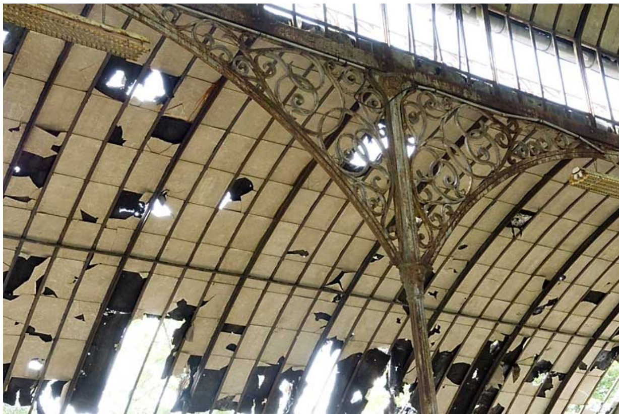
Intérieur de la serre. Console de la charpente métallique. 70, Breuches R.D. 6
