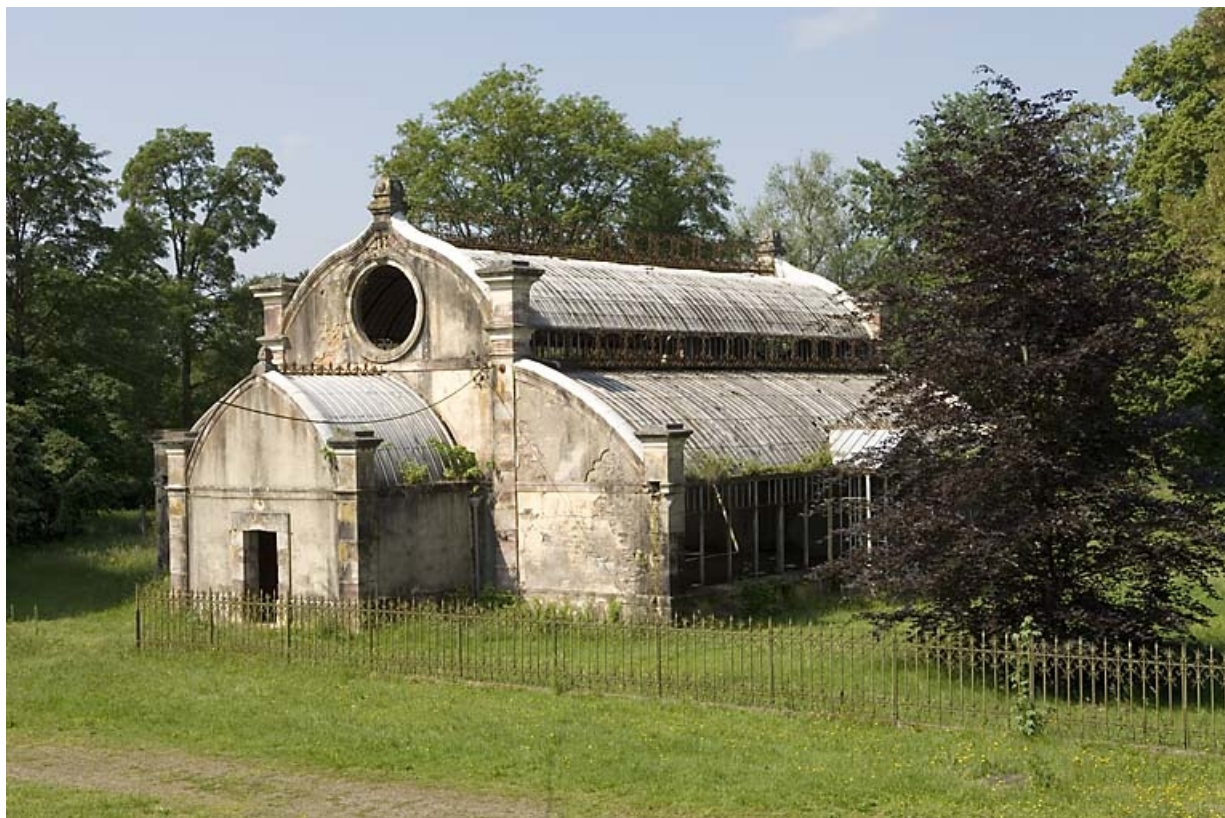
Vue d'ensemble de la serre.
