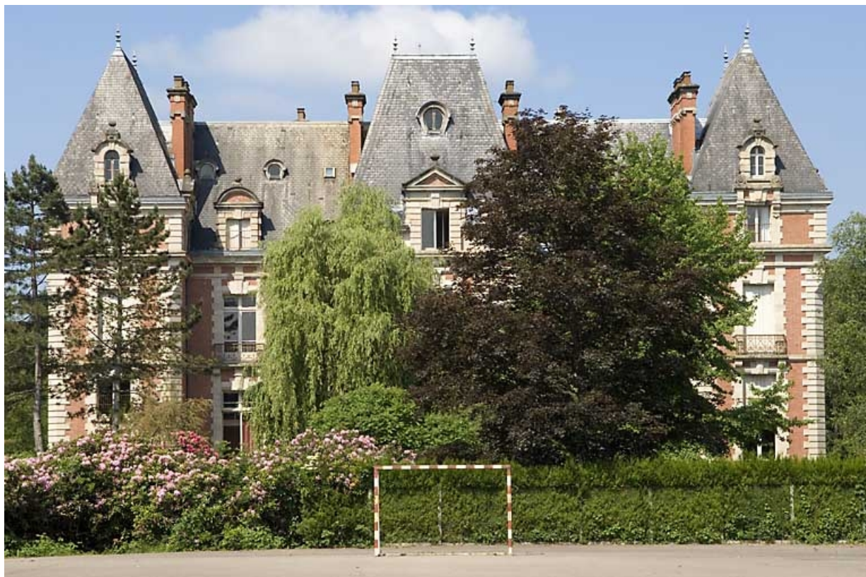
Logement patronal. Façade antérieure.
