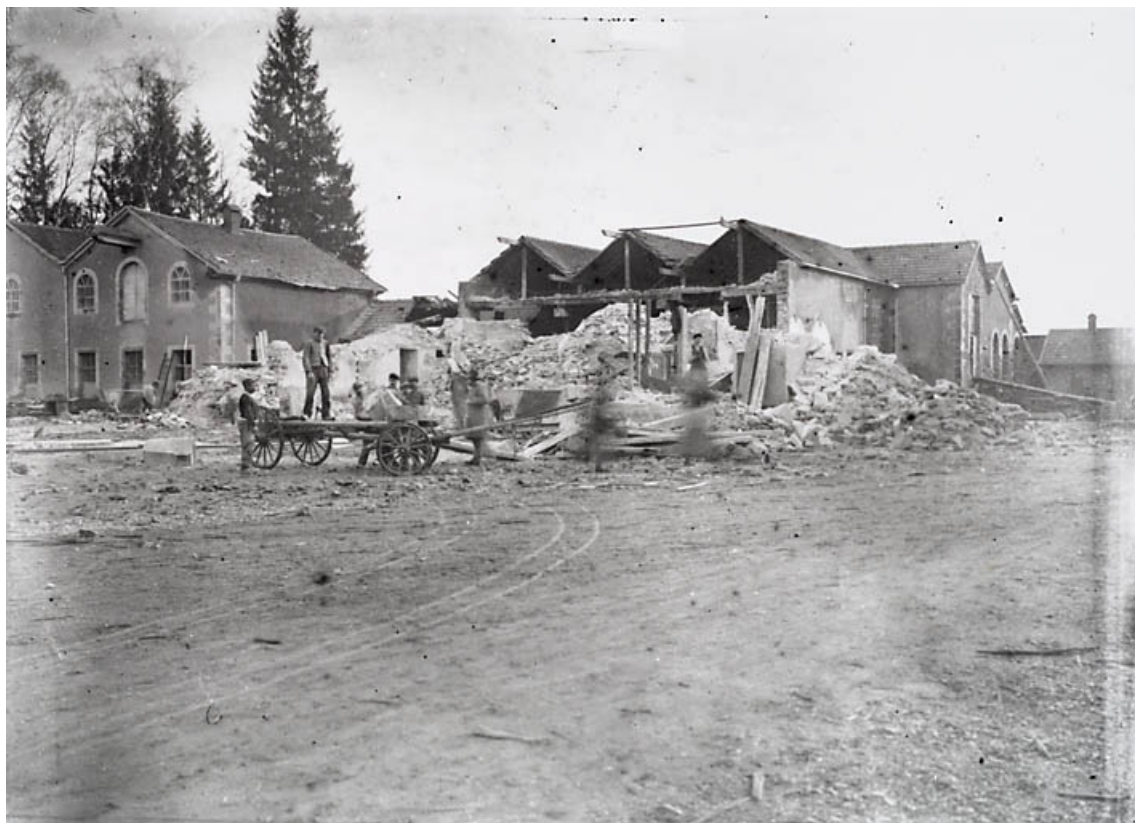
Démolition de l'ancienne filature (magasins de stockage ?).
