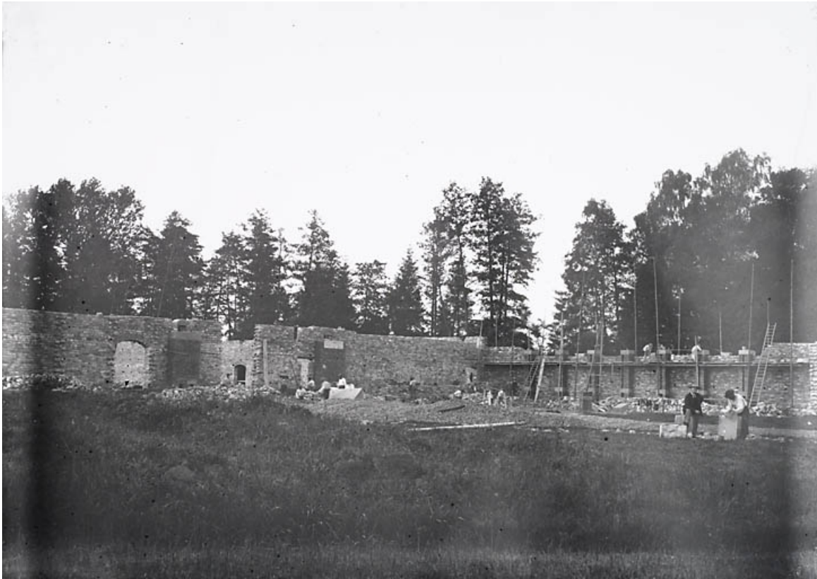
Construction de la nouvelle filature.
