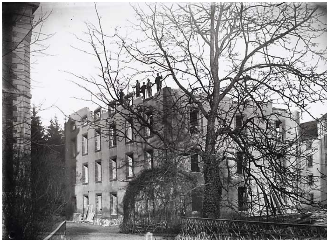
Démolition de l'ancienne filature.
