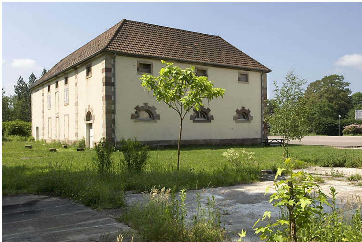
Ecuries et remises. Vue de trois quarts arrière.
