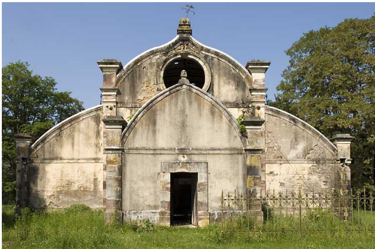
Serre. Mur-pignon est.
