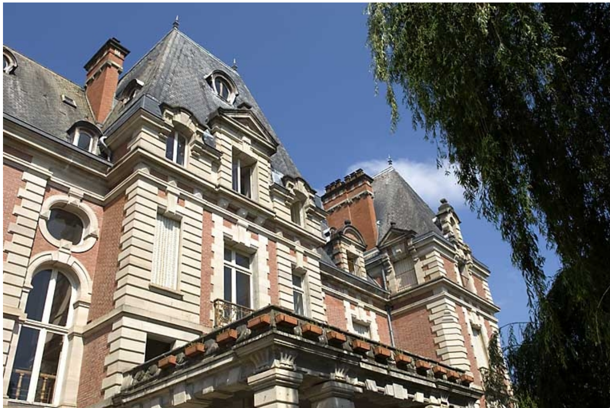
Logement patronal. Détail de la façade antérieure. 70, Breuches R.D. 6
