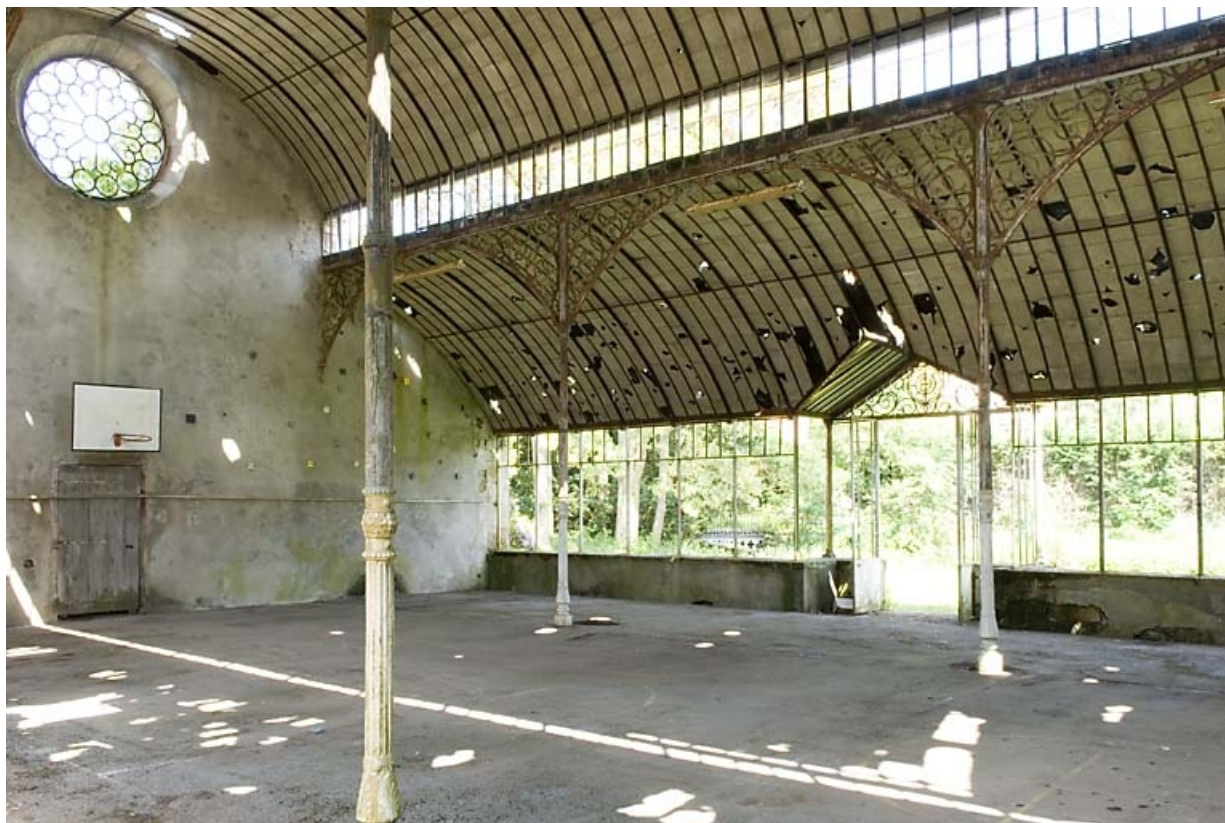
Intérieur de la serre. Vue de côté.
