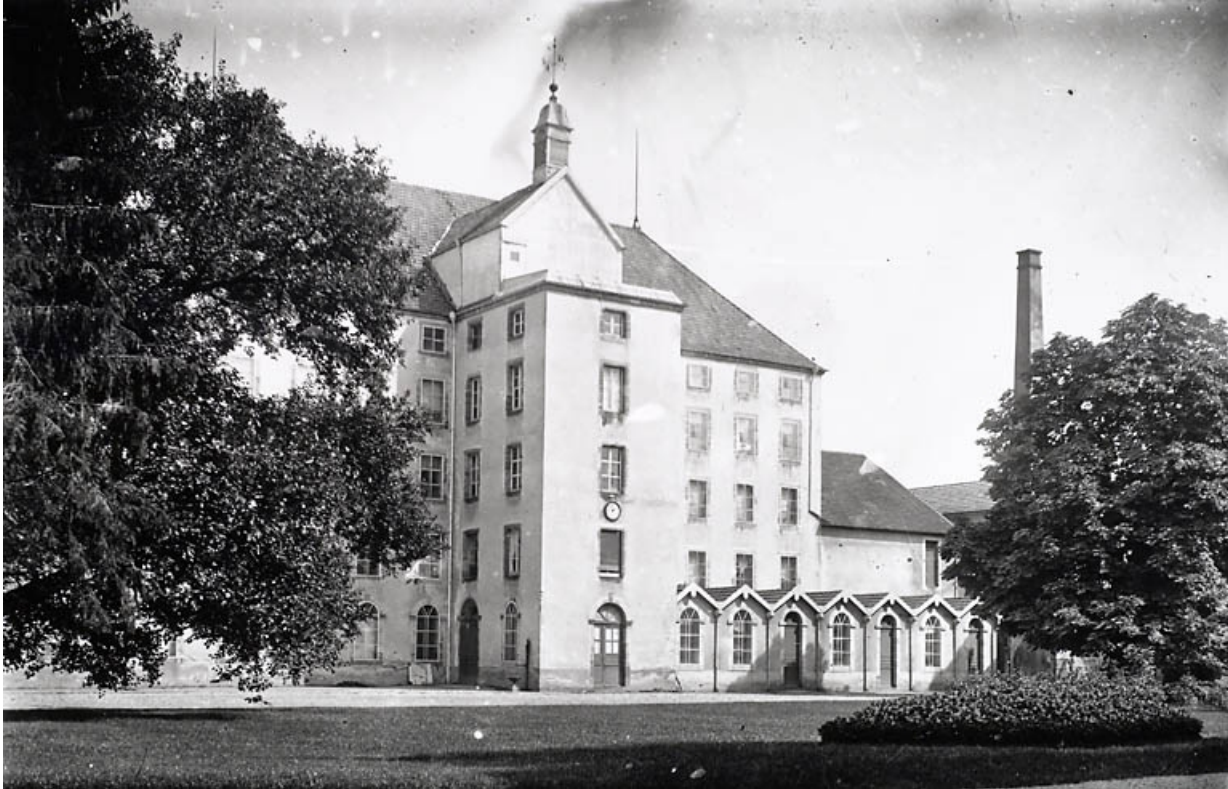
Élévation ouest de l'ancienne filature.
