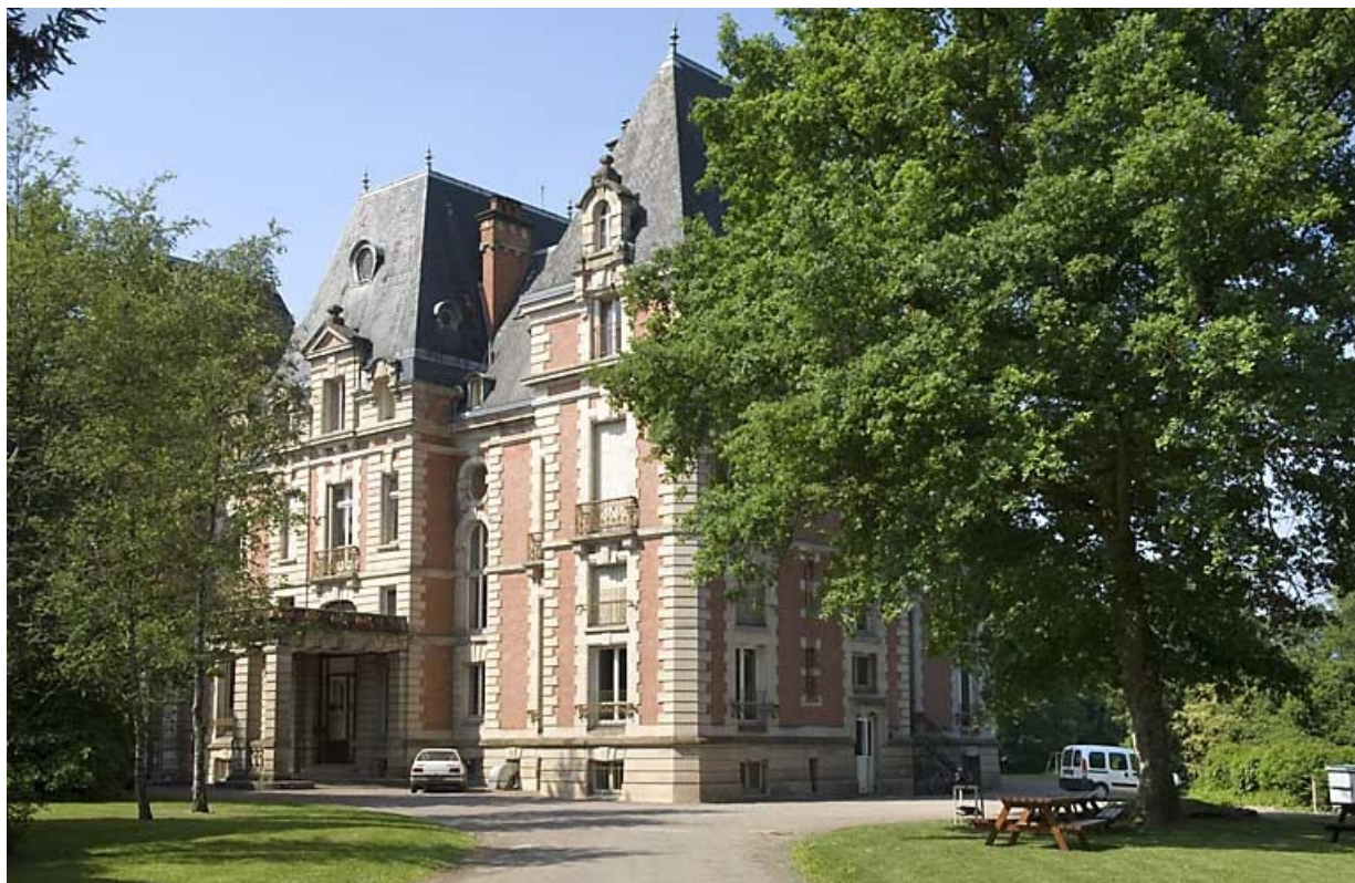
Logement patronal. Vue de trois quarts.
