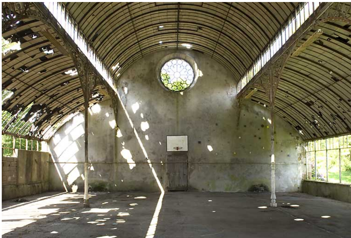
Intérieur de la serre. Vue depuis l'est.
