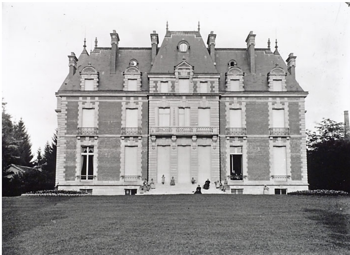
Façade occidentale de la nouvelle demeure patronale.
