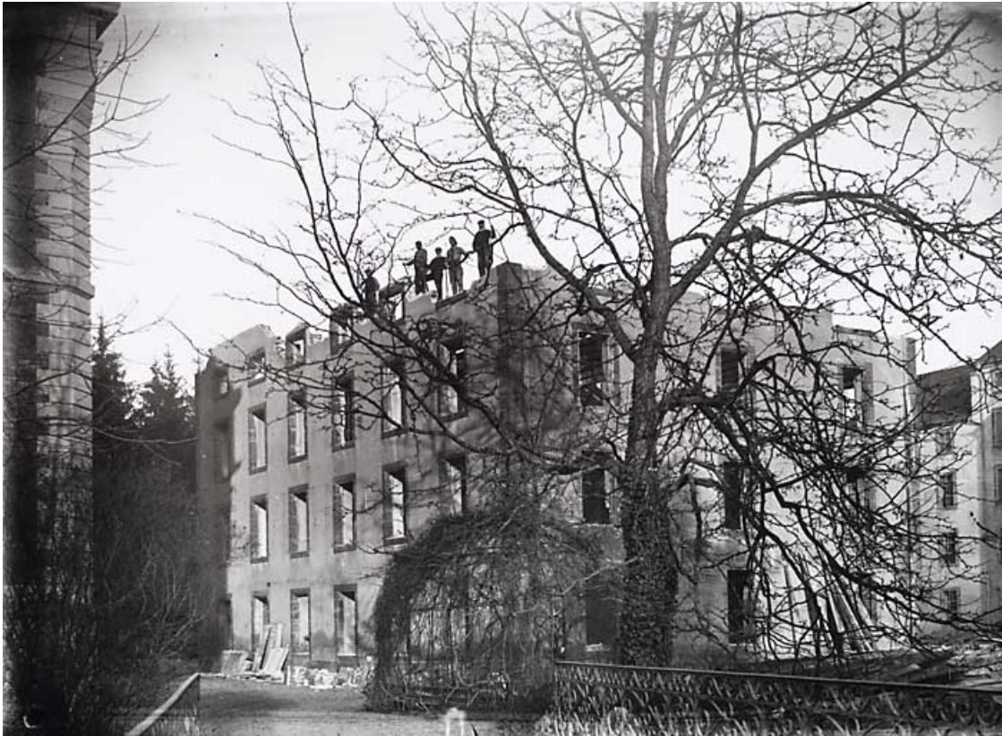
Démolition de l'ancienne filature.
