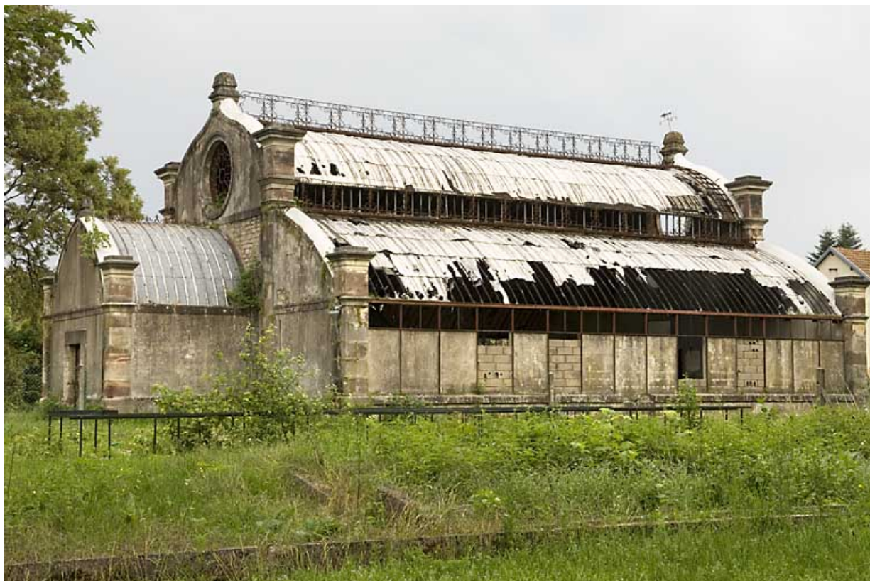
Serre. Façade sud.
