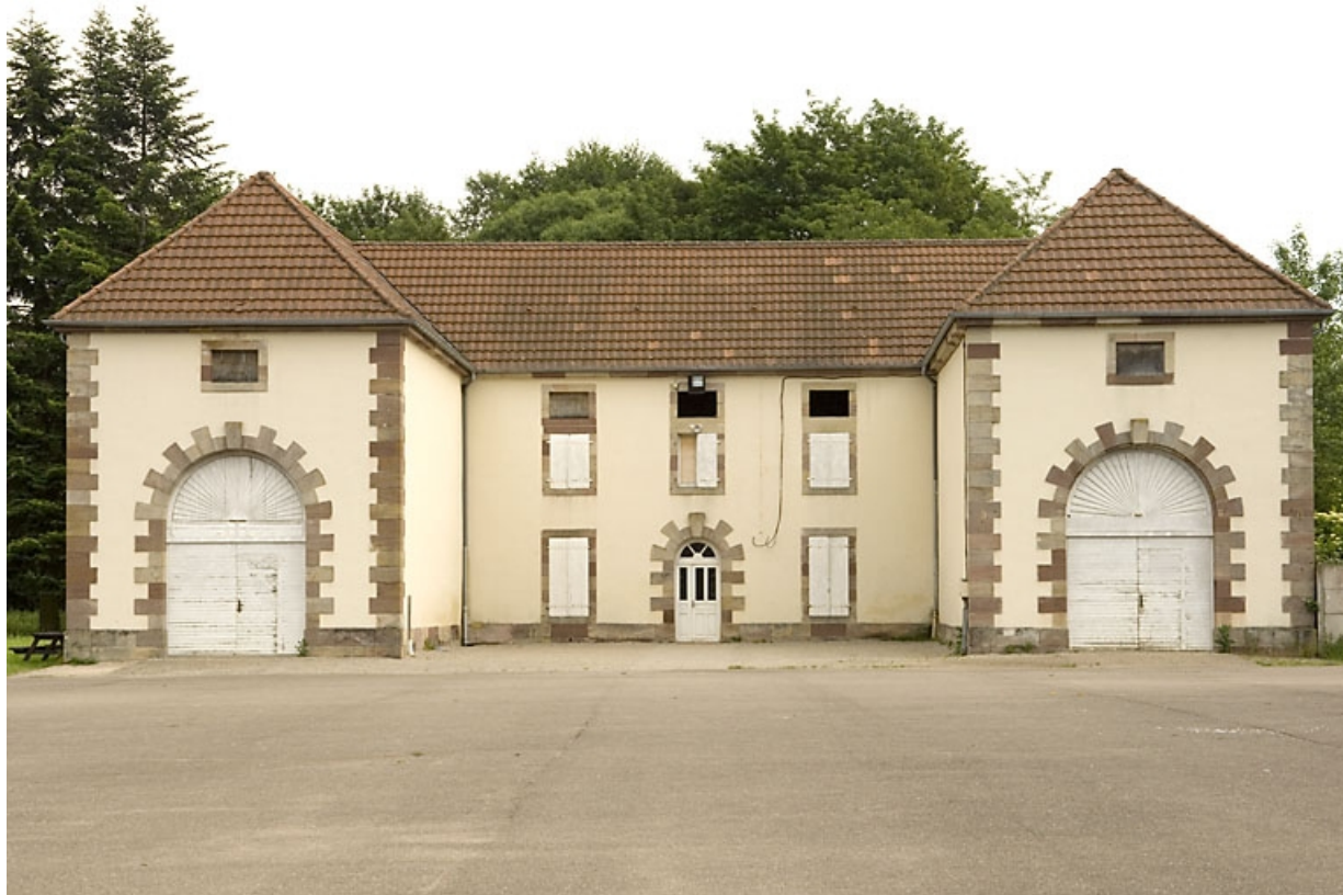
Ecuries et remises. Vue de face.
