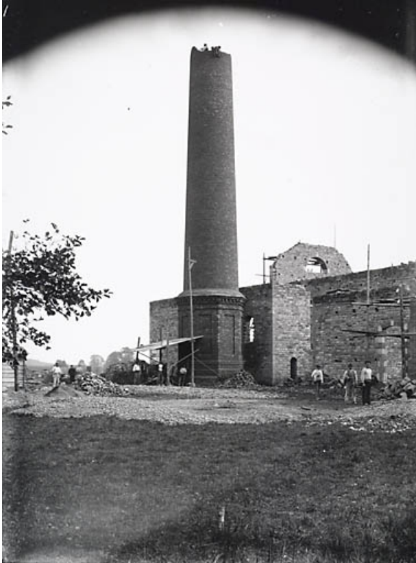
Construction de la cheminée de la nouvelle filature.
