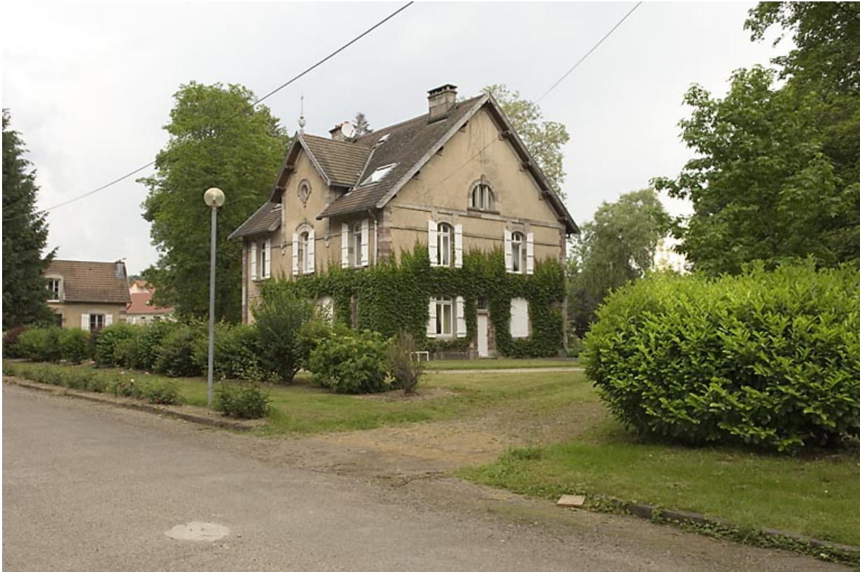
Logement (ancien chenil). Vue depuis le sud. 70, Breuches R.D. 6
