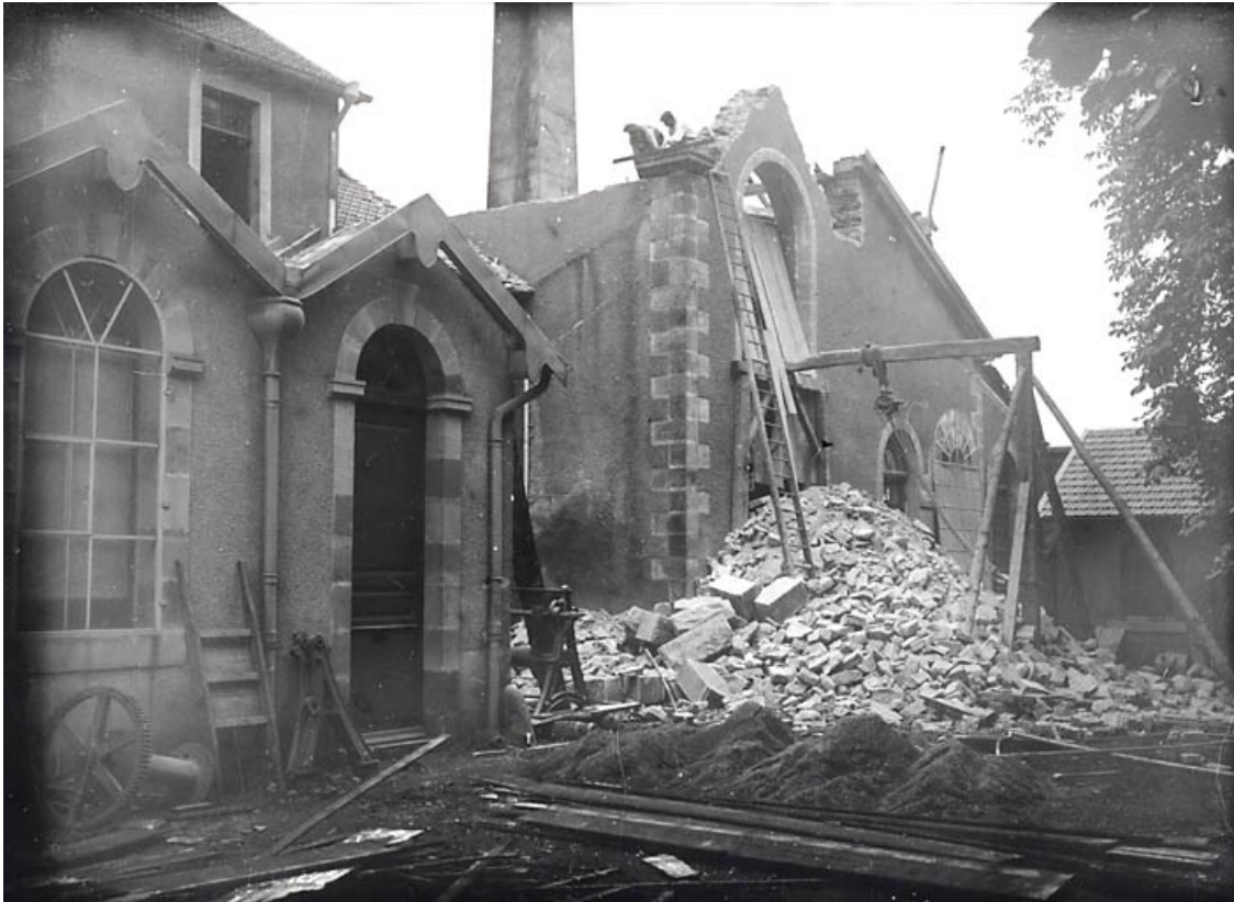
Démolition de l'ancienne filature (salle des machines ?).
