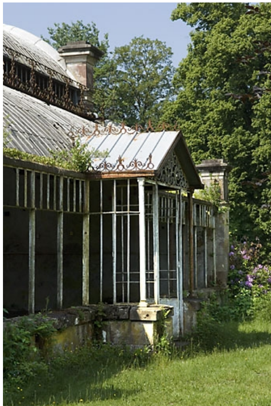
Serre. Détail de la façade nord.
