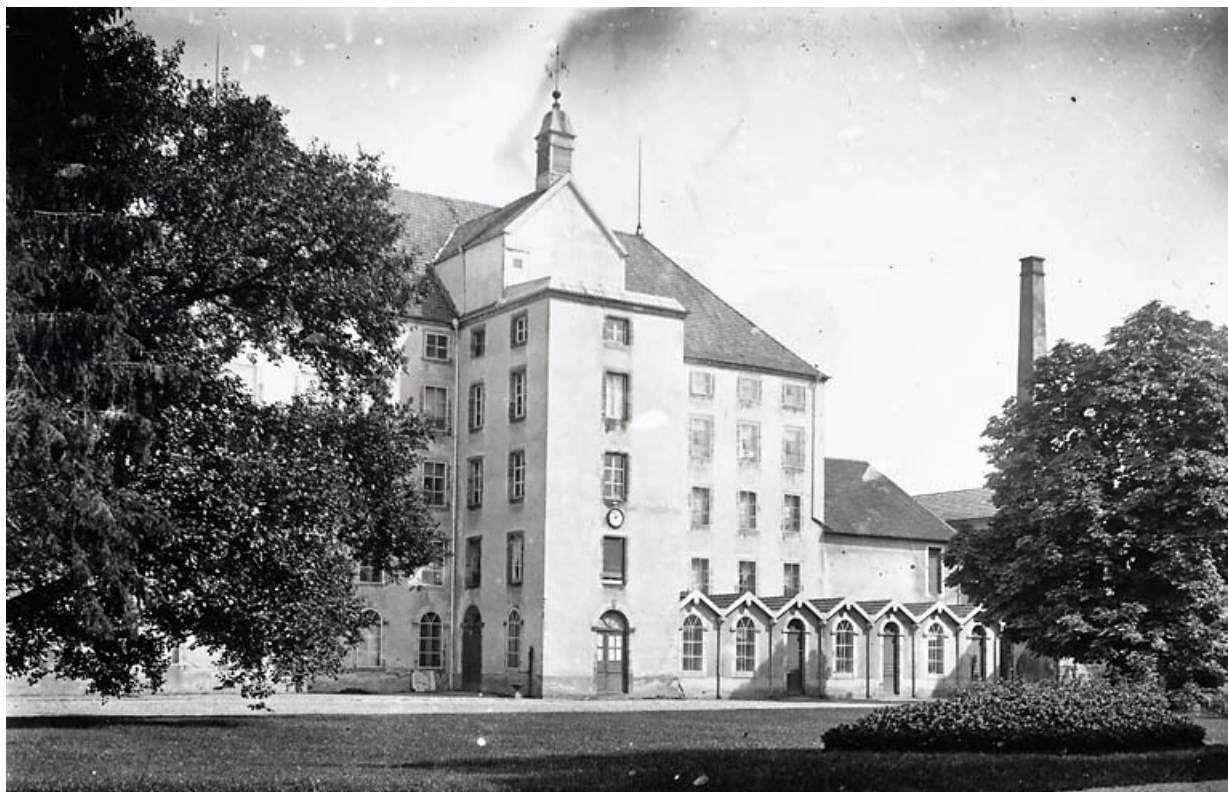
Élévation ouest de l'ancienne filature.
