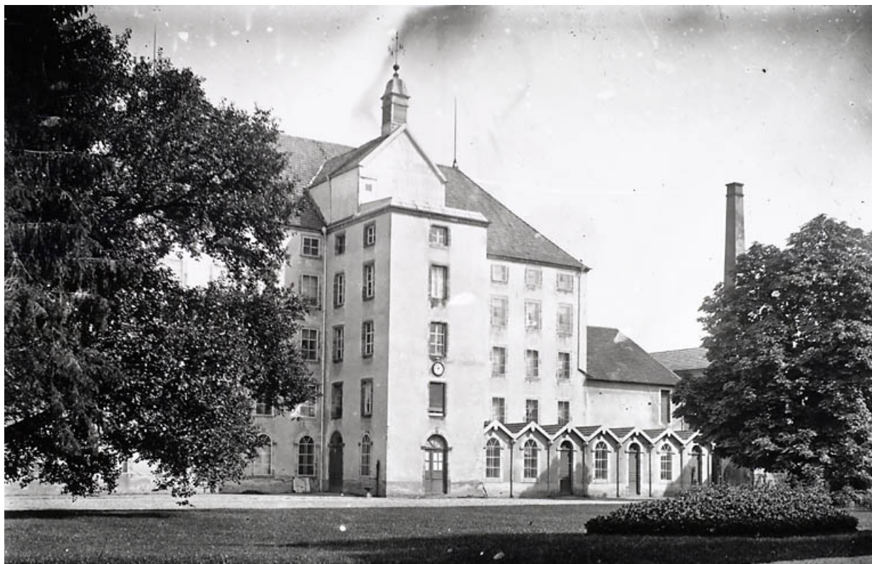
Élévation ouest de l'ancienne filature.
