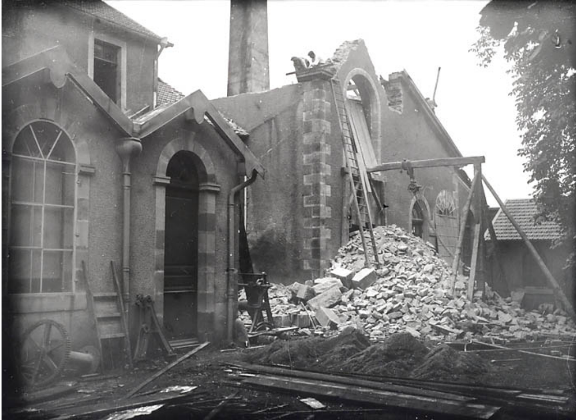
Démolition de l'ancienne filature (salle des machines ?).
