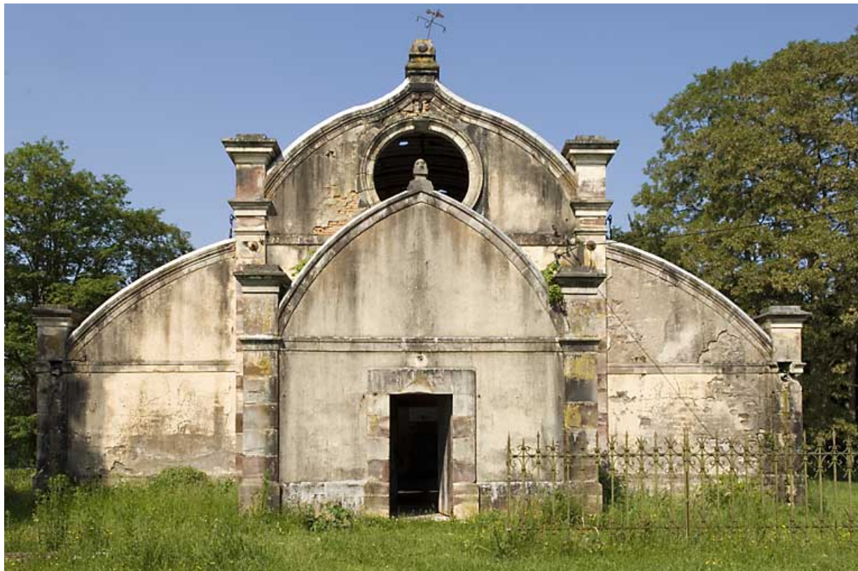
Serre. Mur-pignon est.
