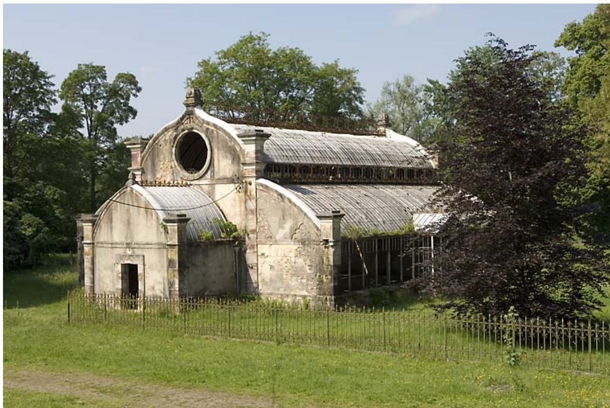
Vue d'ensemble de la serre.
