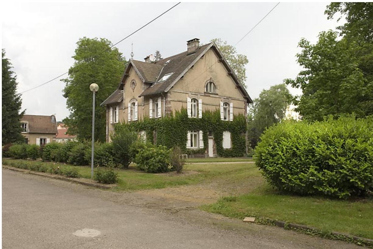
Logement (ancien chenil). Vue depuis le sud.
