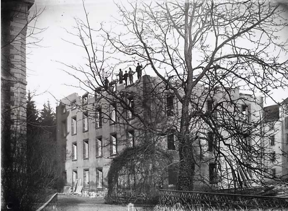
Démolition de l'ancienne filature.
