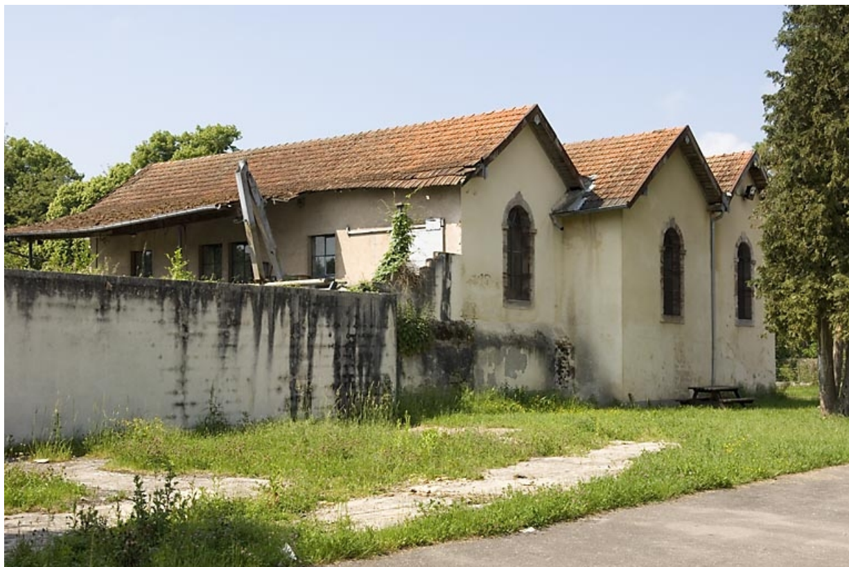
Centrale hydroélectrique. Vue de trois quarts arrière. 70, Breuches R.D. 6
