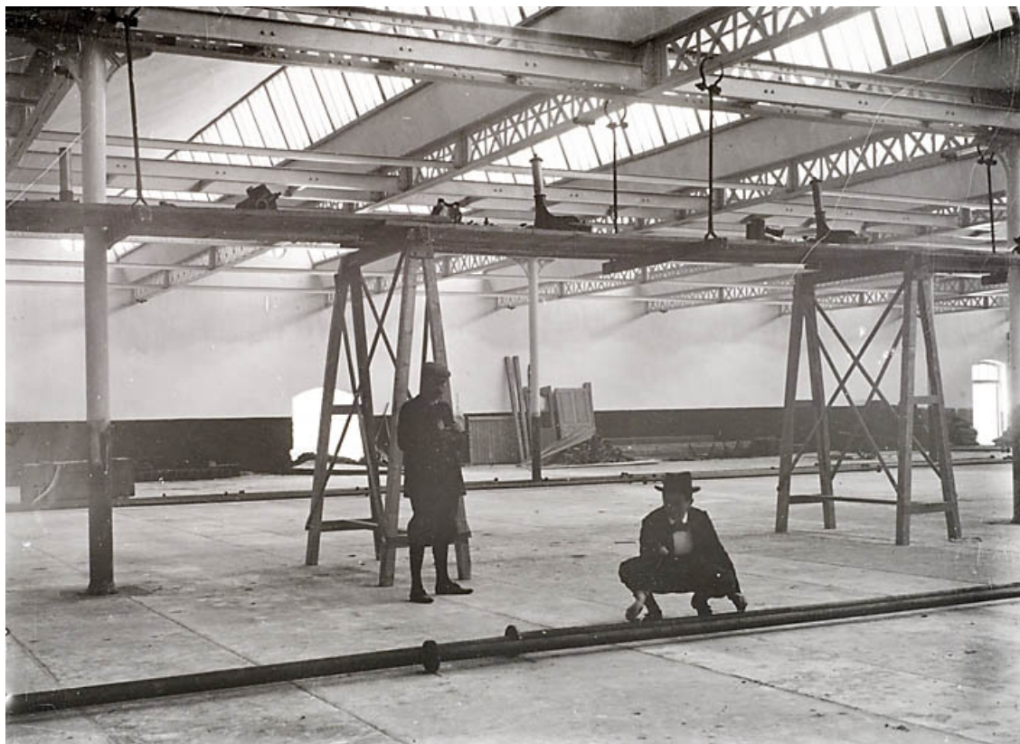
Installation du système de chauffage dans la nouvelle filature.
