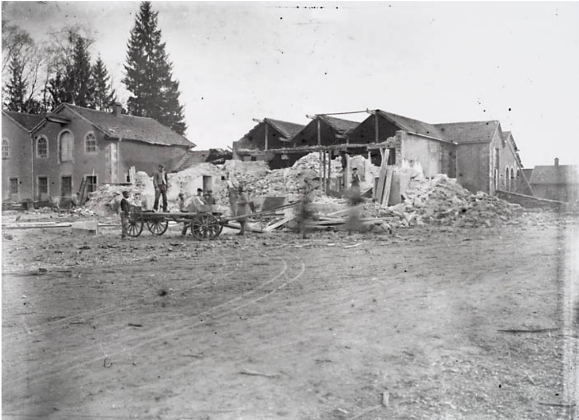
Démolition de l'ancienne filature (magasins de stockage ?).
