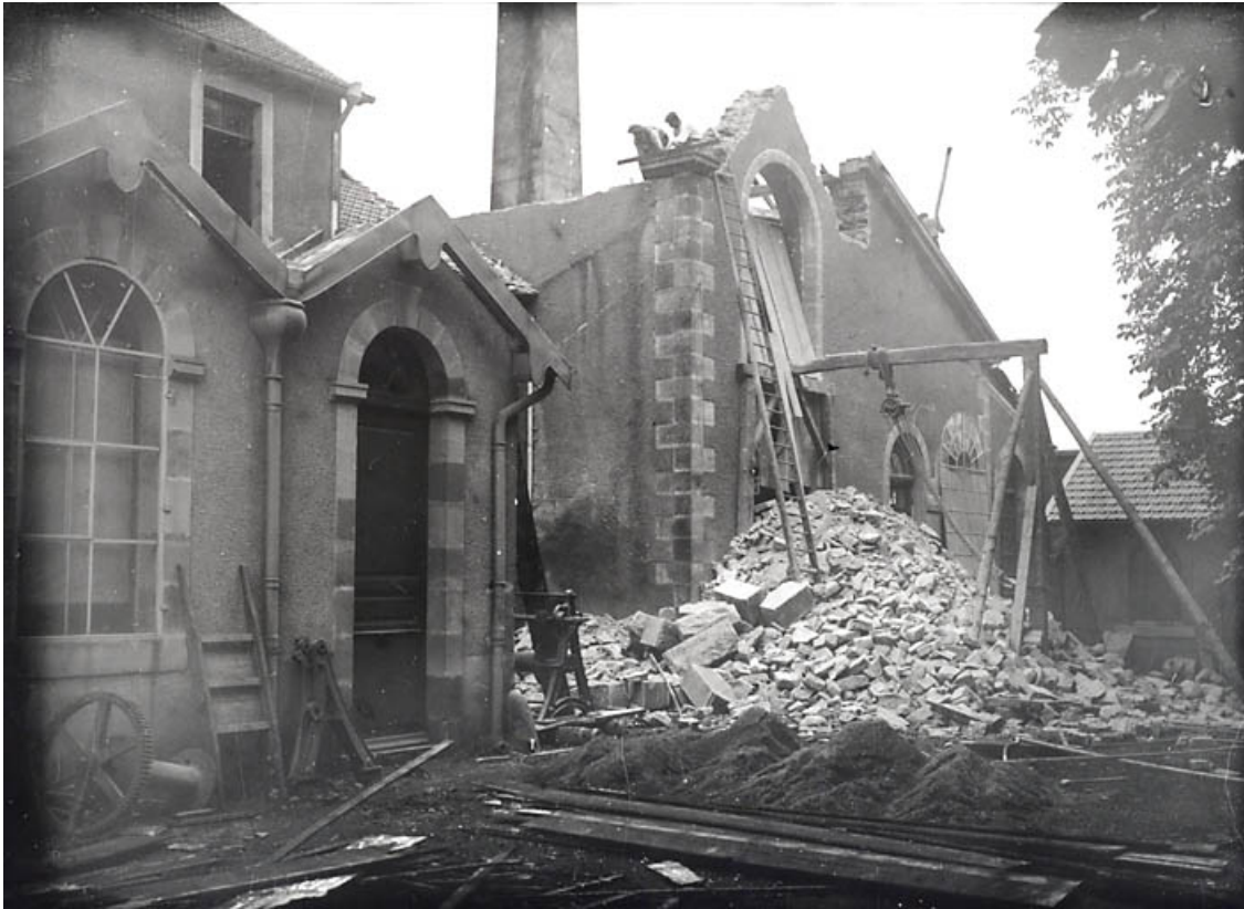
Démolition de l'ancienne filature (salle des machines ?).
