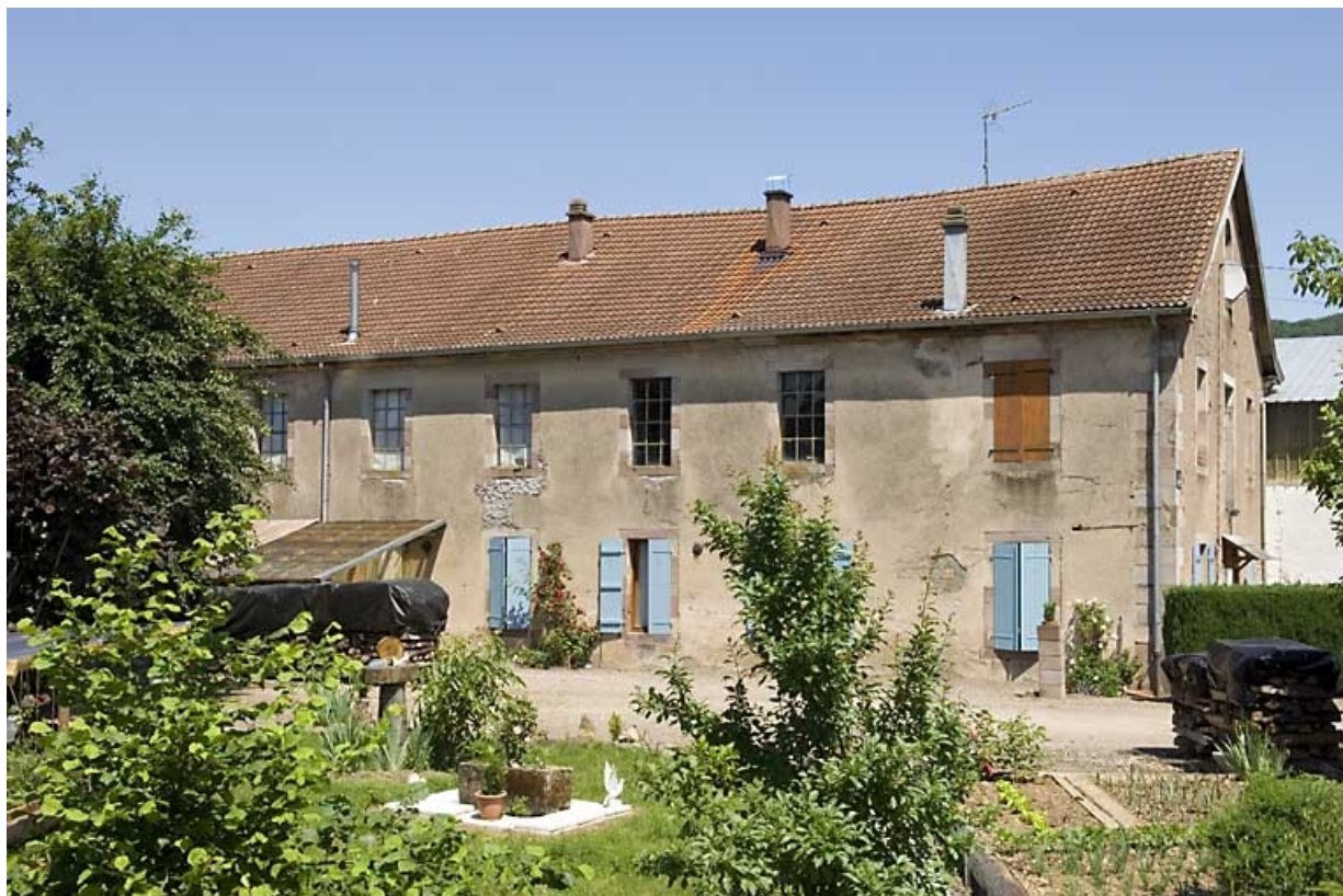
Extrémité de la façade sud de l'atelier de fabrication.
