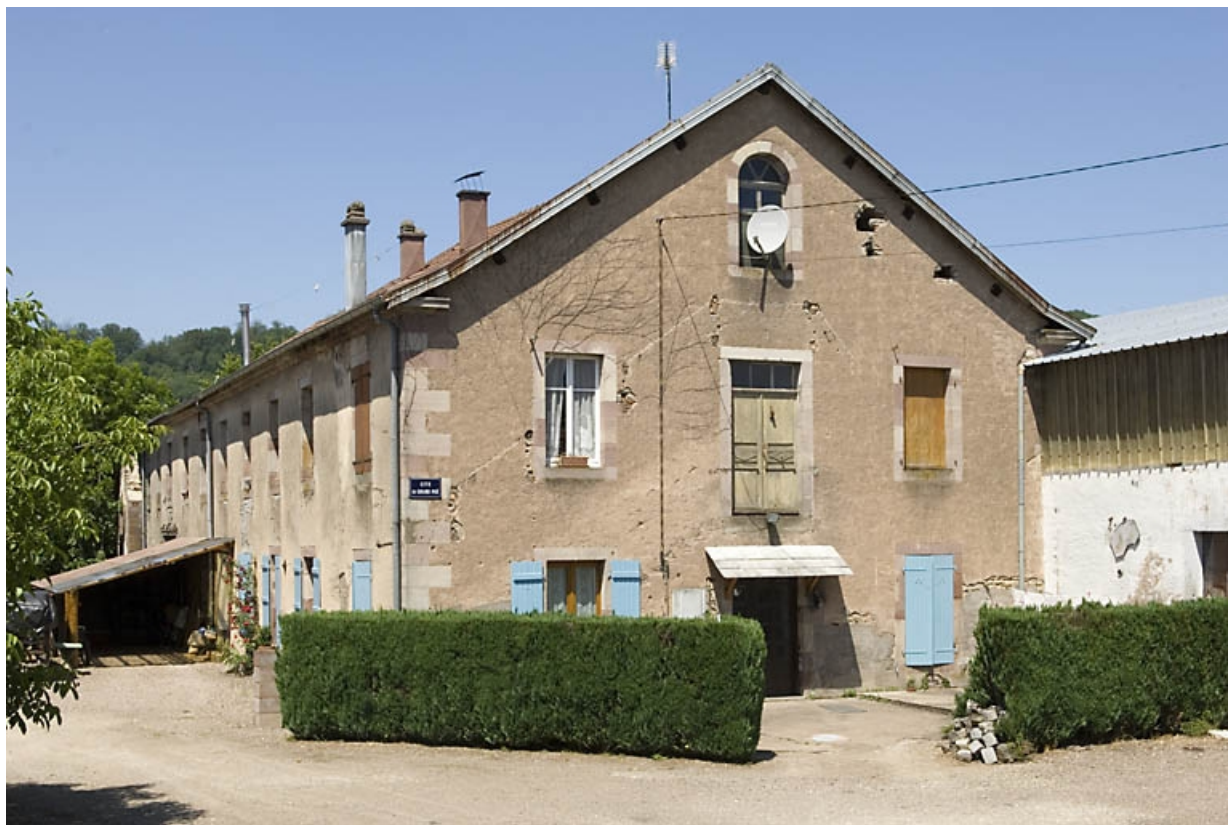
Atelier de fabrication. Vue depuis le sud-est. 70, Breuchotte rue du Grand Pré
