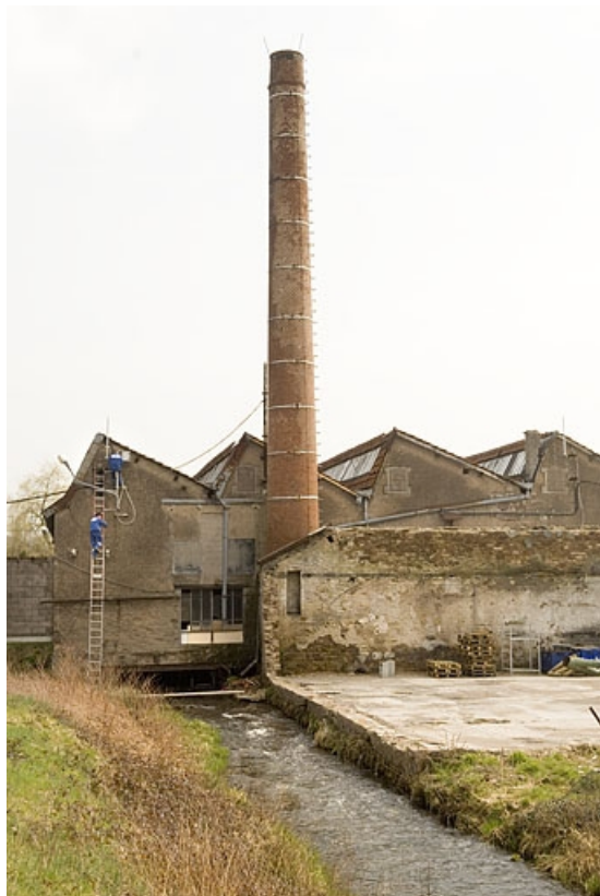
Façade nord-ouest de l'atelier de fabrication et cheminée.
