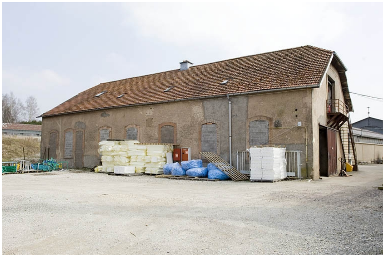
Moulin d'aval. Vue de trois quarts arrière.
