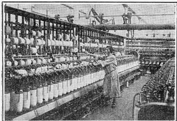
MÈTIÈRES A RETORDRE EN ACTION A L'USINE DU VAL-D'AJOL
