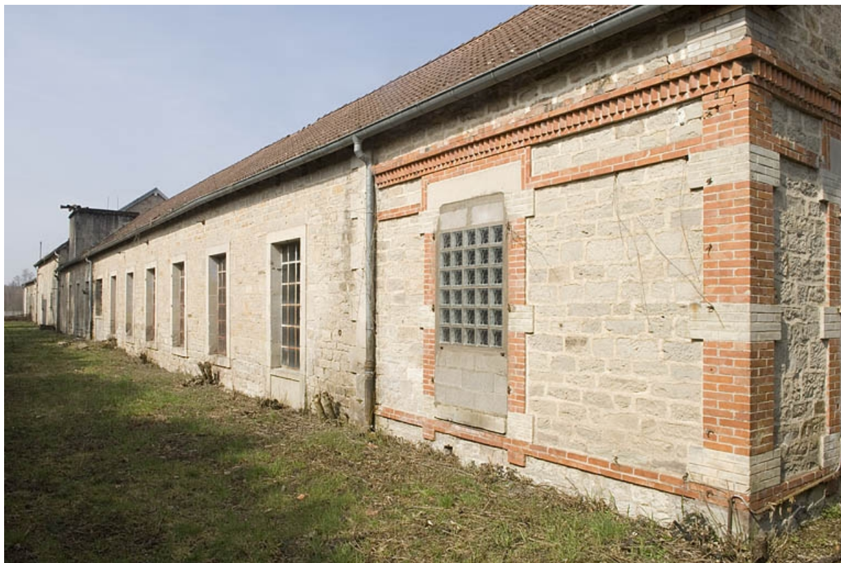
Façade sud vue de trois quarts droite.
