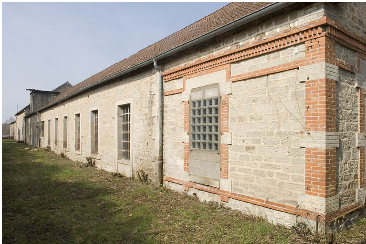
Façade sud vue de trois quarts droite.
