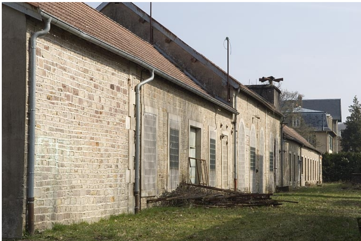
Façade sud vue de trois quarts gauche. Au centre : élévation de la salle des machines. 70, Froideconche, 20 à 28 rue de la Vierge, lieudit : la Corveraine
