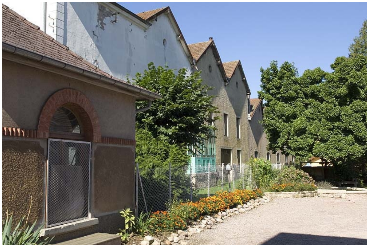
Façade postérieure de l'atelier de fabrication nord. 70, Fougerolles rue des Canes
