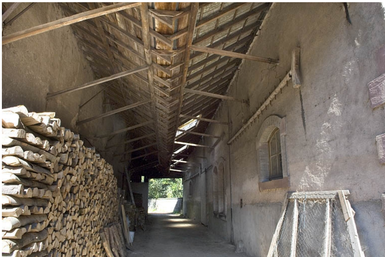
Passage couvert entre les ateliers de fabrication nord.
