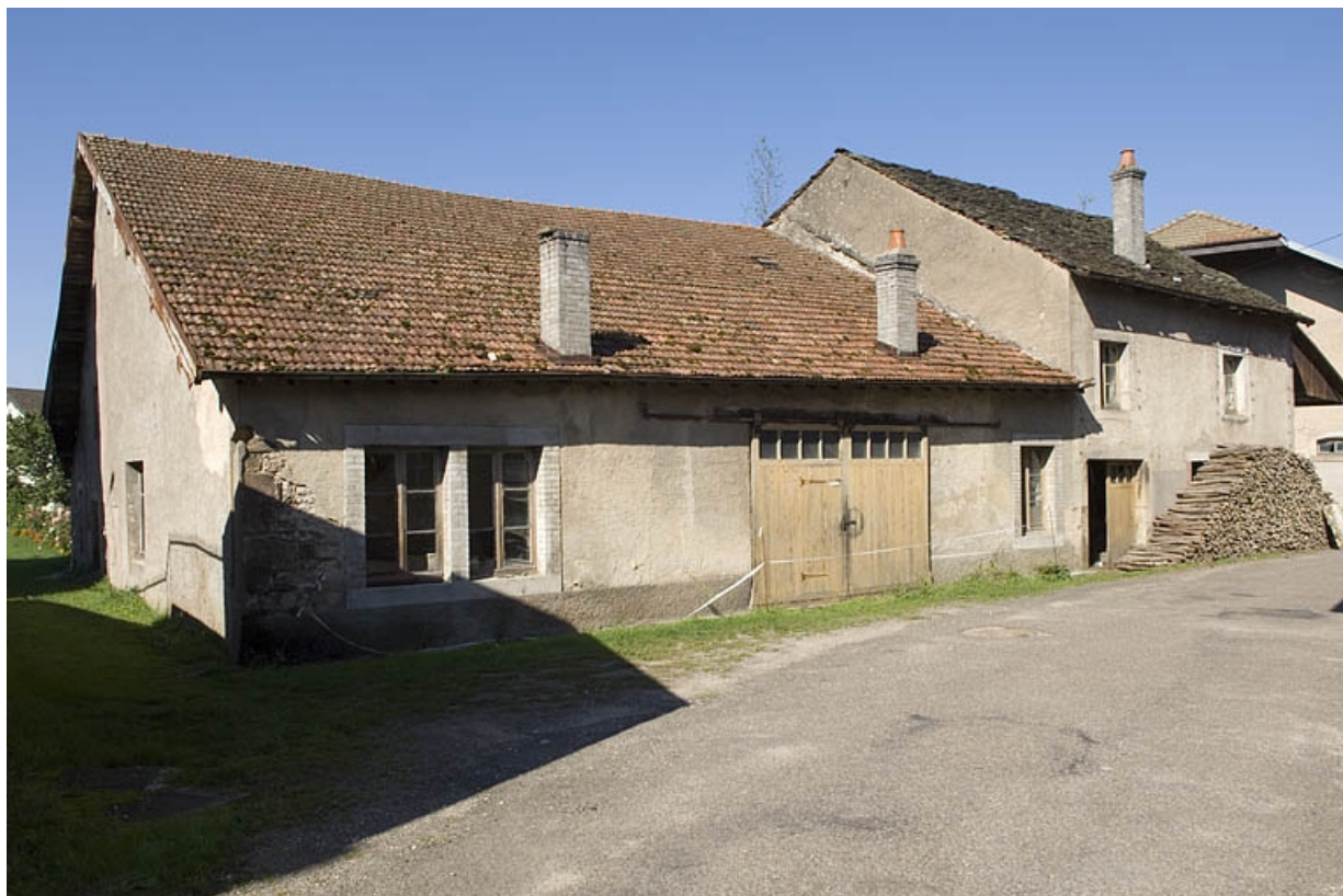
Atelier de fabrication sud. Vue depuis l'entrée. 70, Fougerolles rue des Canes
