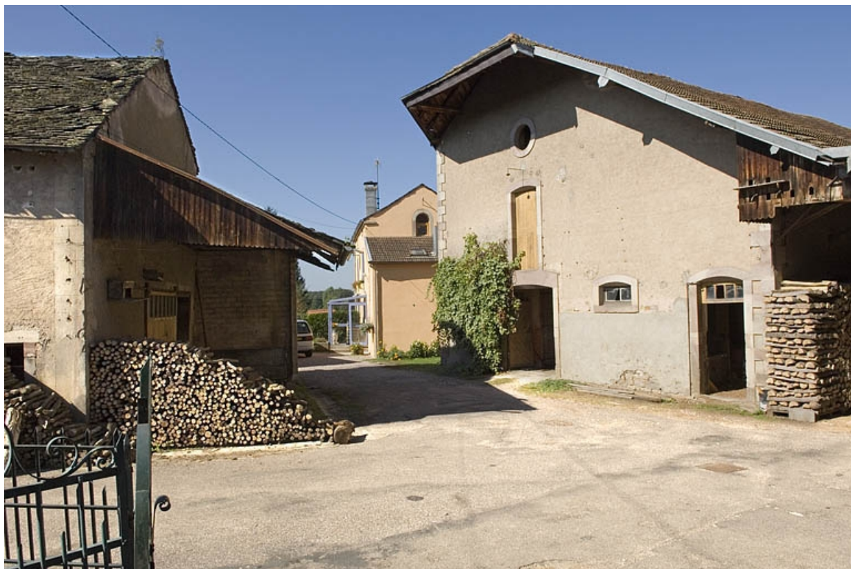
Bâtiments industriels. Vue depuis le logement patronal.
