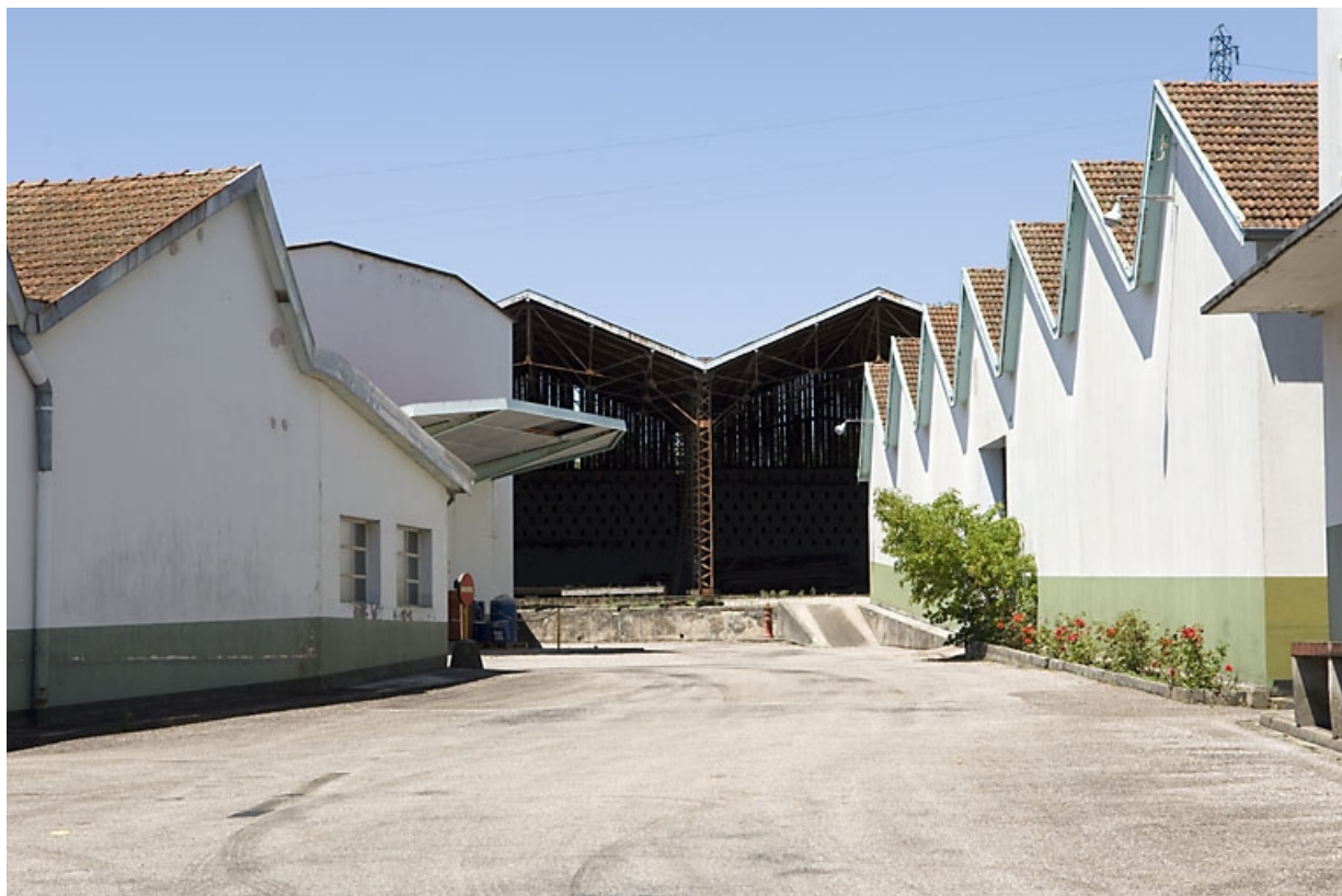
Extension nord de l'usine. Garages, entrepôt industriel (au fond) et magasin et menuiserie (à droite). 70, Fougerolles, 2 rue des Calouettes
