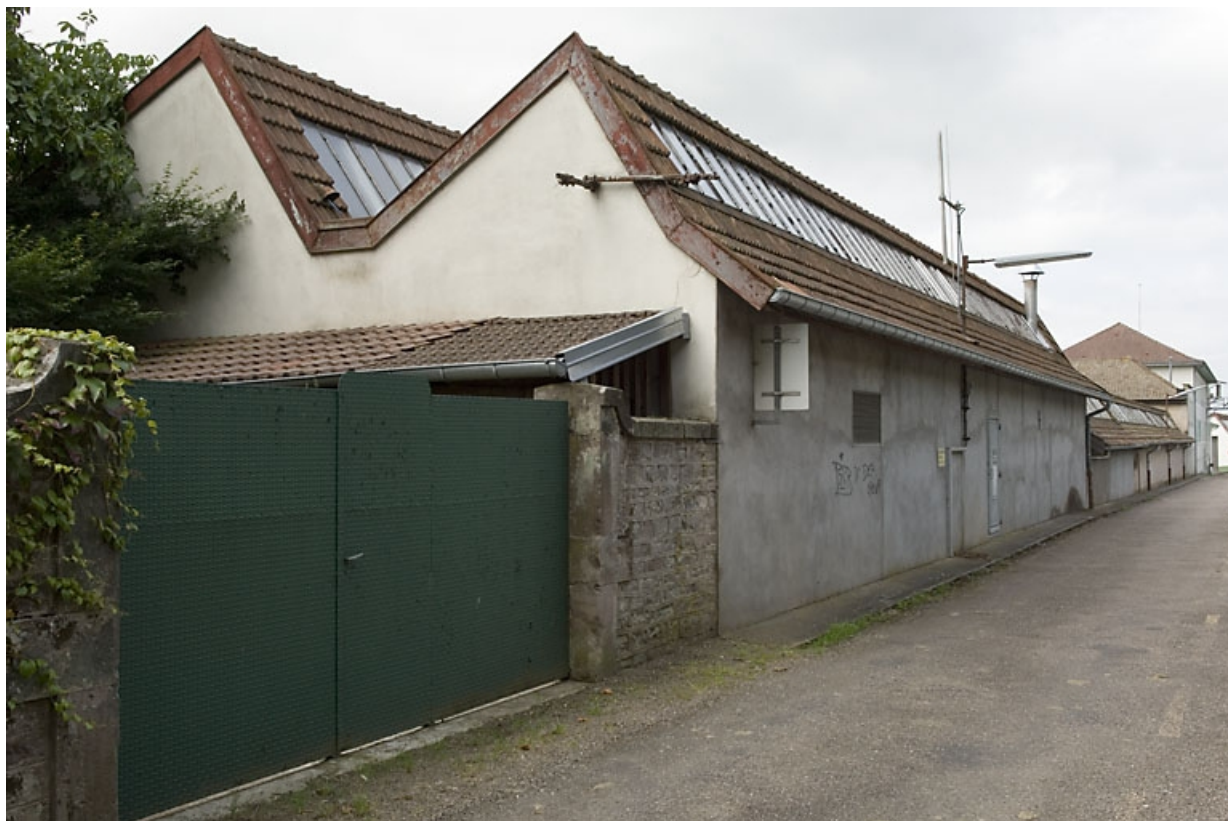
Façade nord de l'atelier de fabrication.
