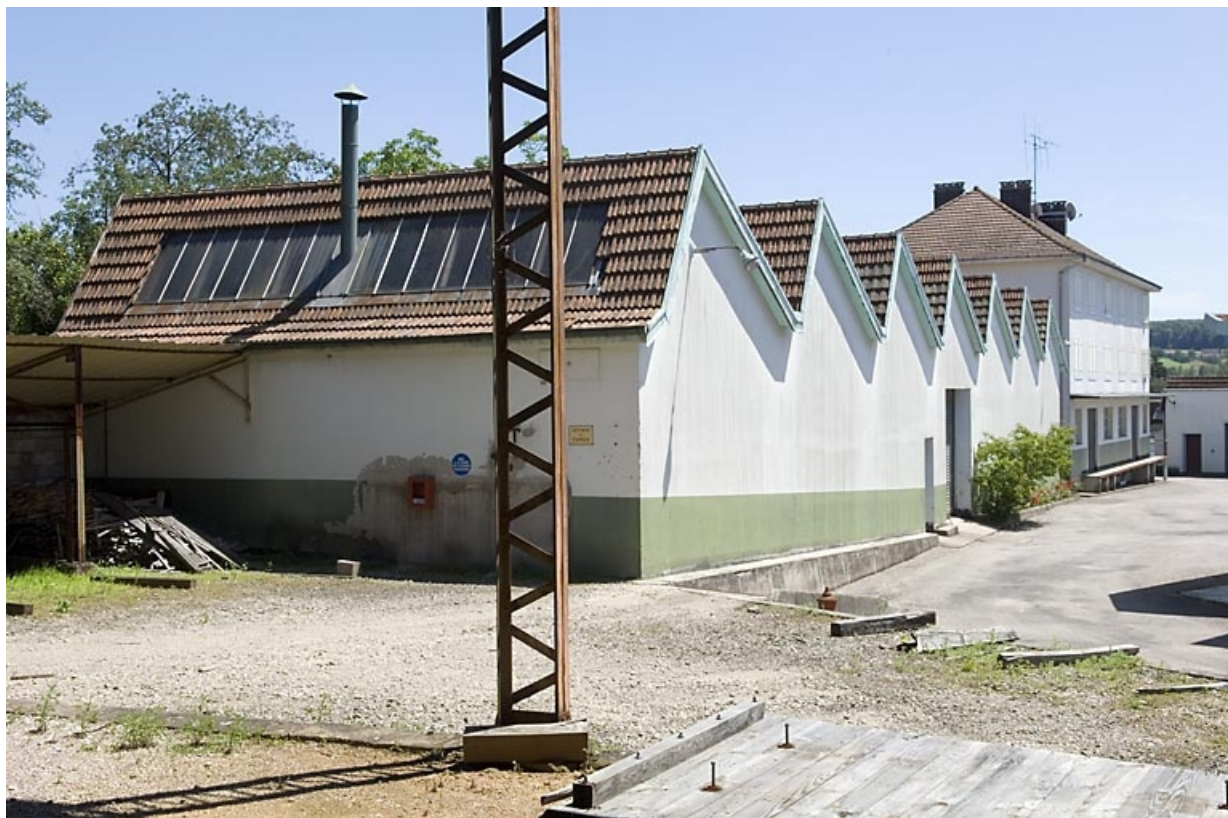
Extension nord de l'usine. Magasin industriel et menuiserie.
