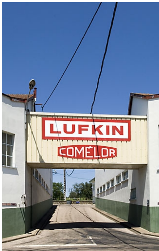
Passerelle de communication entre les ateliers ouest et est.
