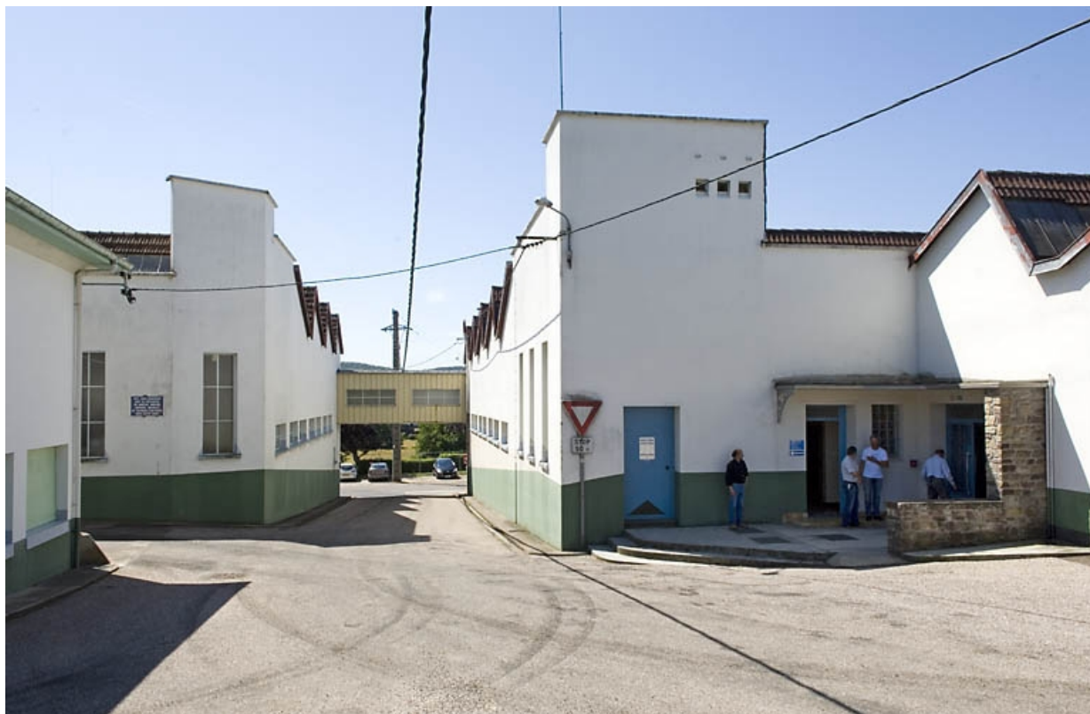
La rue des Calouettes, entre les ateliers est et ouest.
