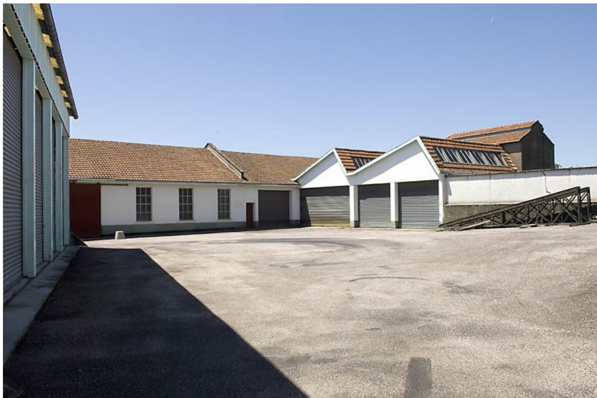
Extension nord de l'usine. Garages. 70, Fougerolles, 2 rue des Calouettes
