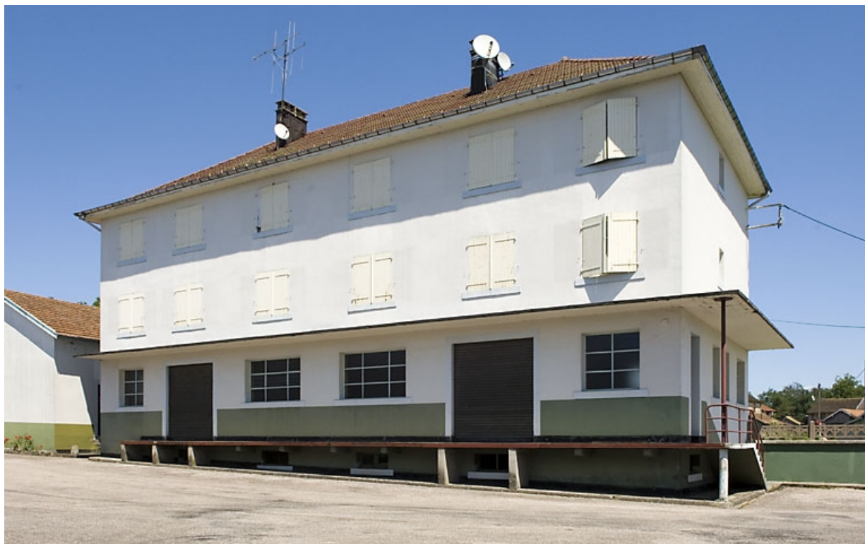
Extension nord de l'usine. Réception des matériaux et logements.
