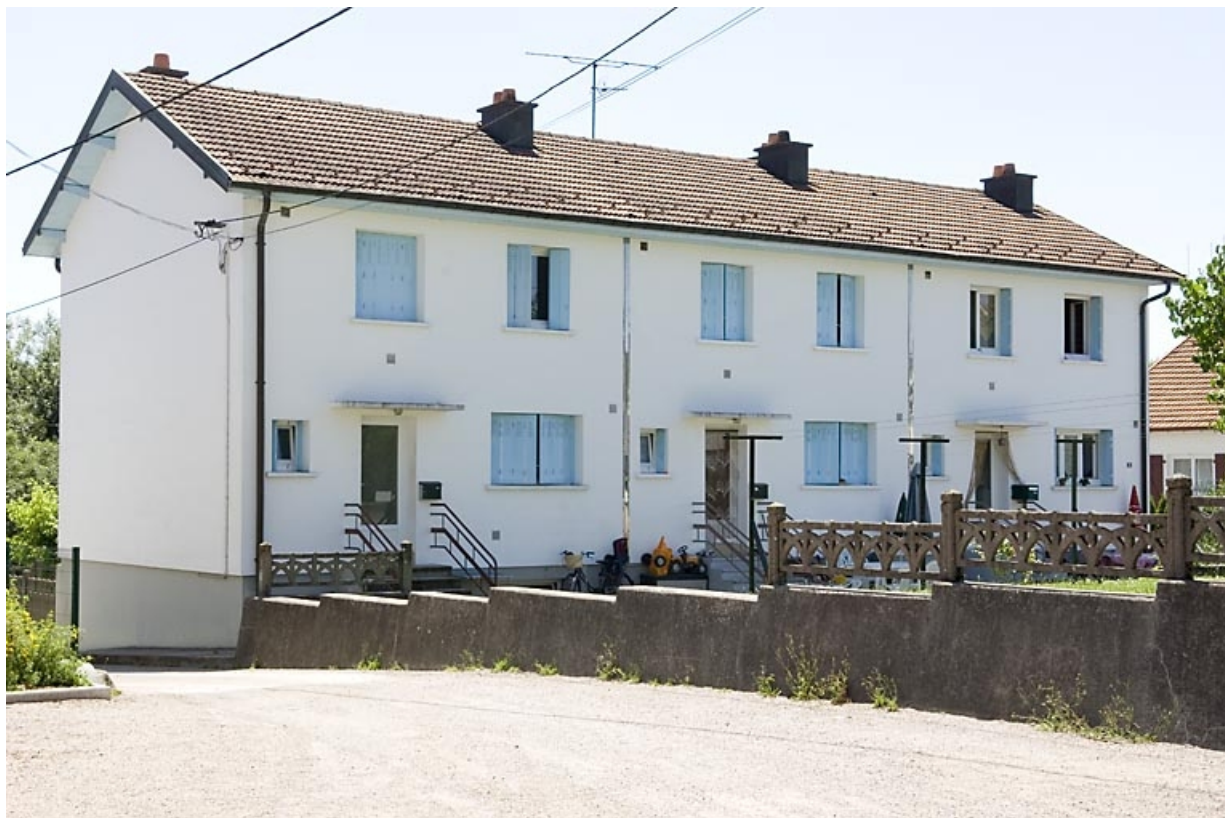
Logement ouvrier collectif (n° 36-38). Vue de trois quarts arrière.
