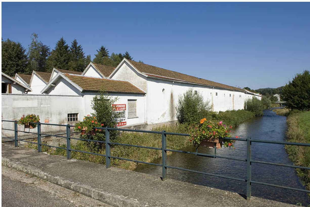
Façade de l'atelier de filature (préparation) le long de la Combeauté. 70, Fougerolles R.D. 83, lieudit : Fougerolles-le-Château
