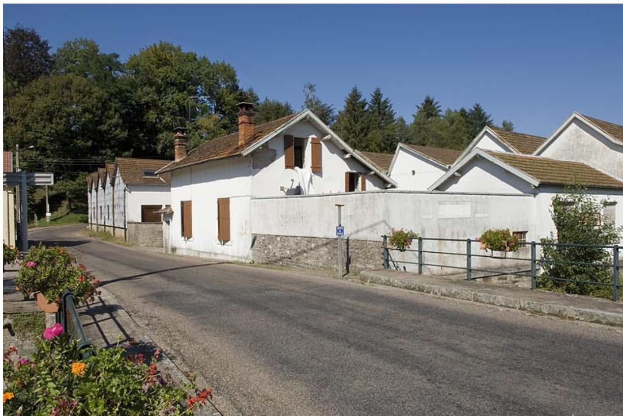
Bâtiments d'entrée et conciergerie, depuis le pont. 70, Fougerolles R.D. 83, lieudit : Fougerolles-le-Château
