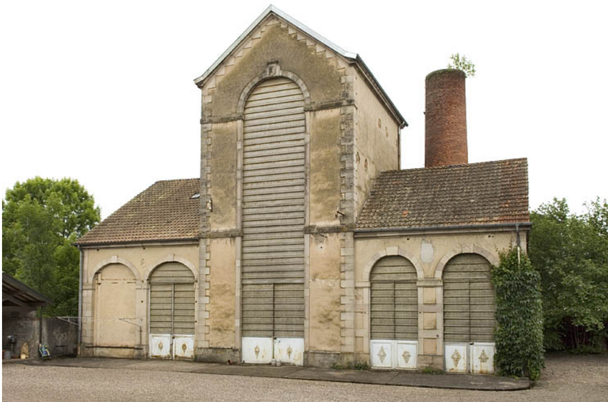
Bâtiment de rectification vu de face.
