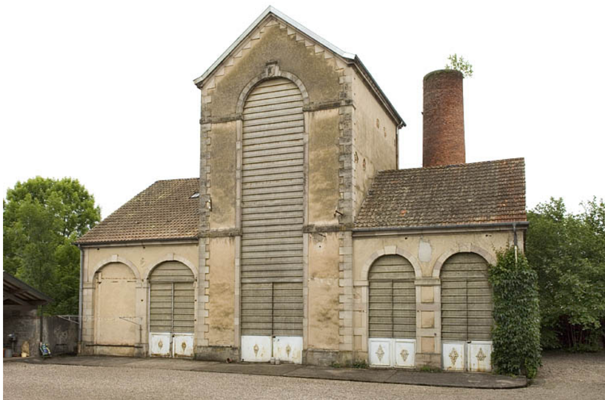
Bâtiment de rectification vu de face.
