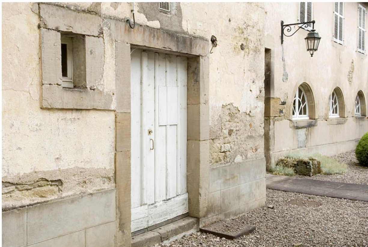
Détail de la façade de l'aile nord.
