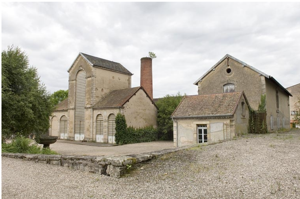
Bâtiment de rectification, bureau et entrepôt industriel.
