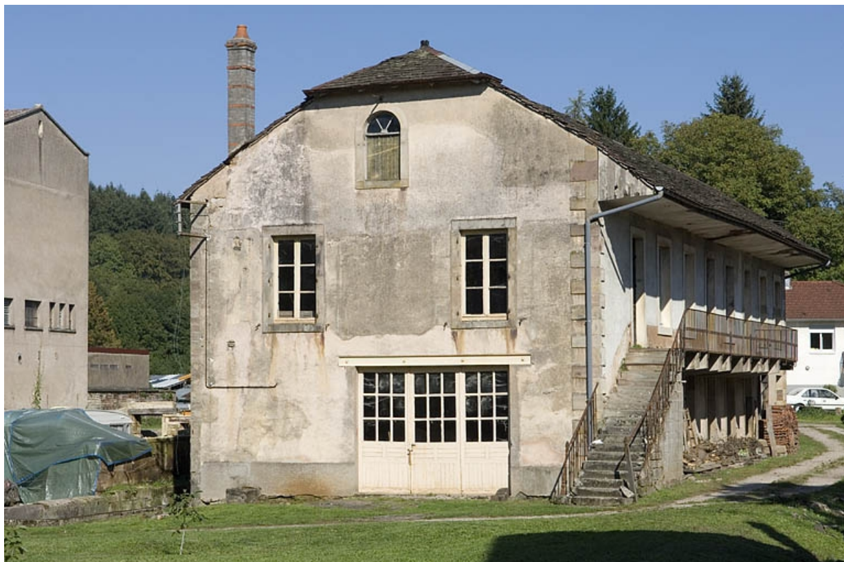
Atelier de tonnellerie. Vue de trois quarts. 70, Fougerolles Grande-Rue
