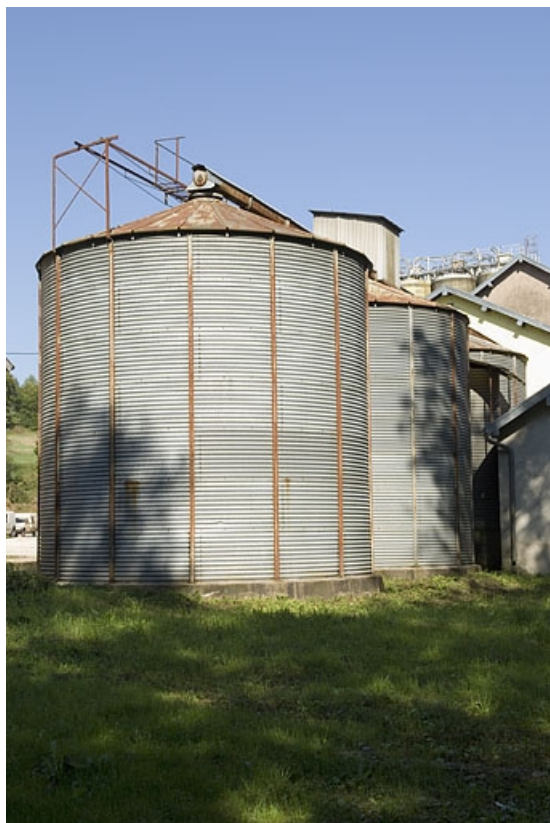
Silos métalliques. Vue depuis l'ouest.
