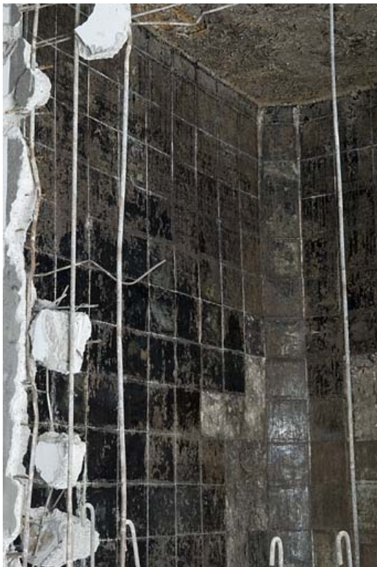
Détail d'une cuve en cours de démolition.
