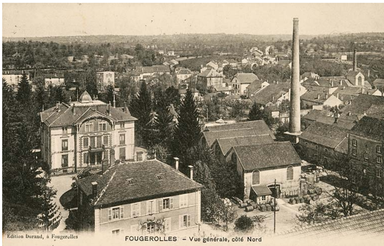
Fougerolles. Vue générale côté nord.
