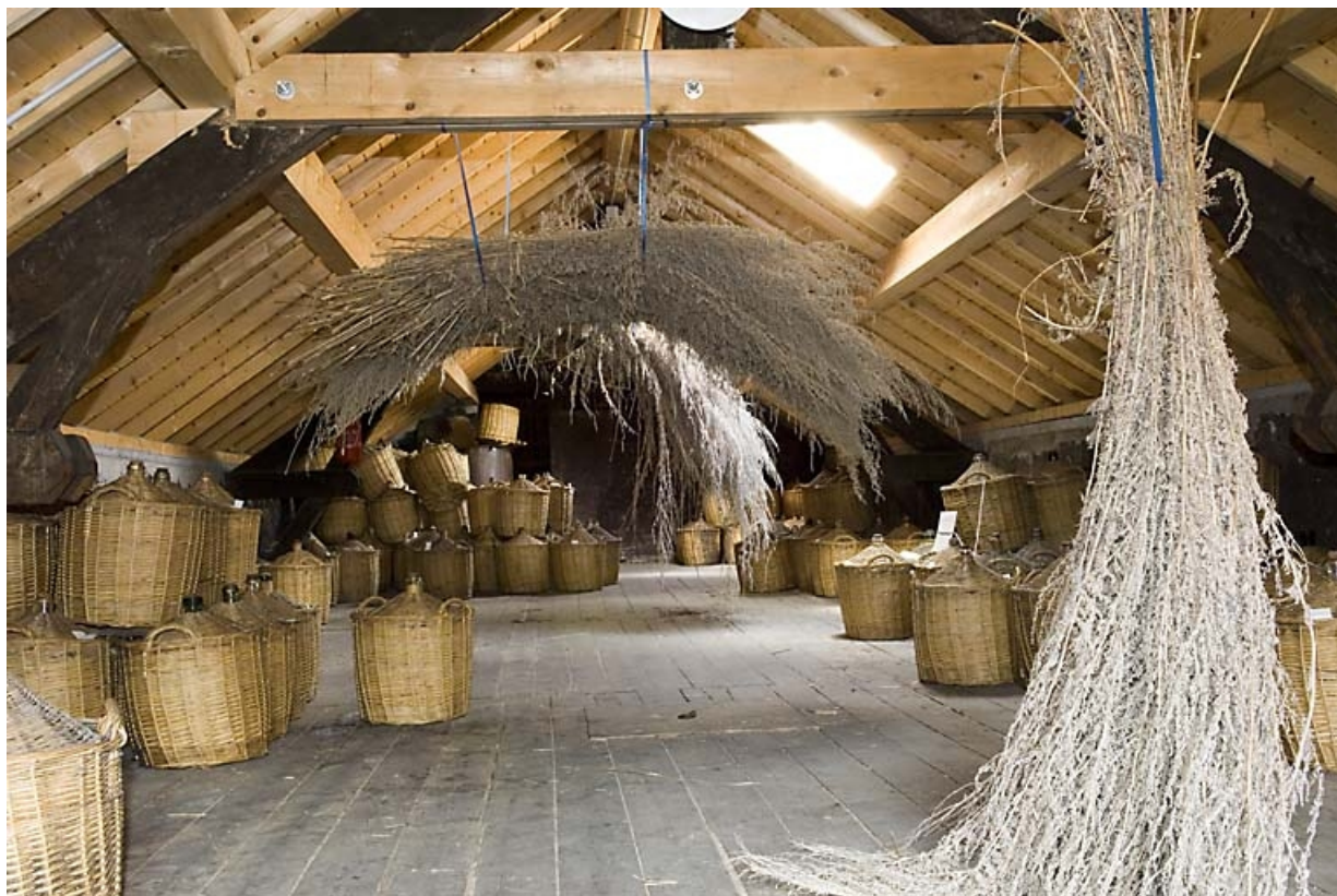
Chai à l'étage de la cuverie (vieillissement des eaux-de-vie en bonbonnes). 70, Fougerolles, 7, 9 rue des Moines Hauts
