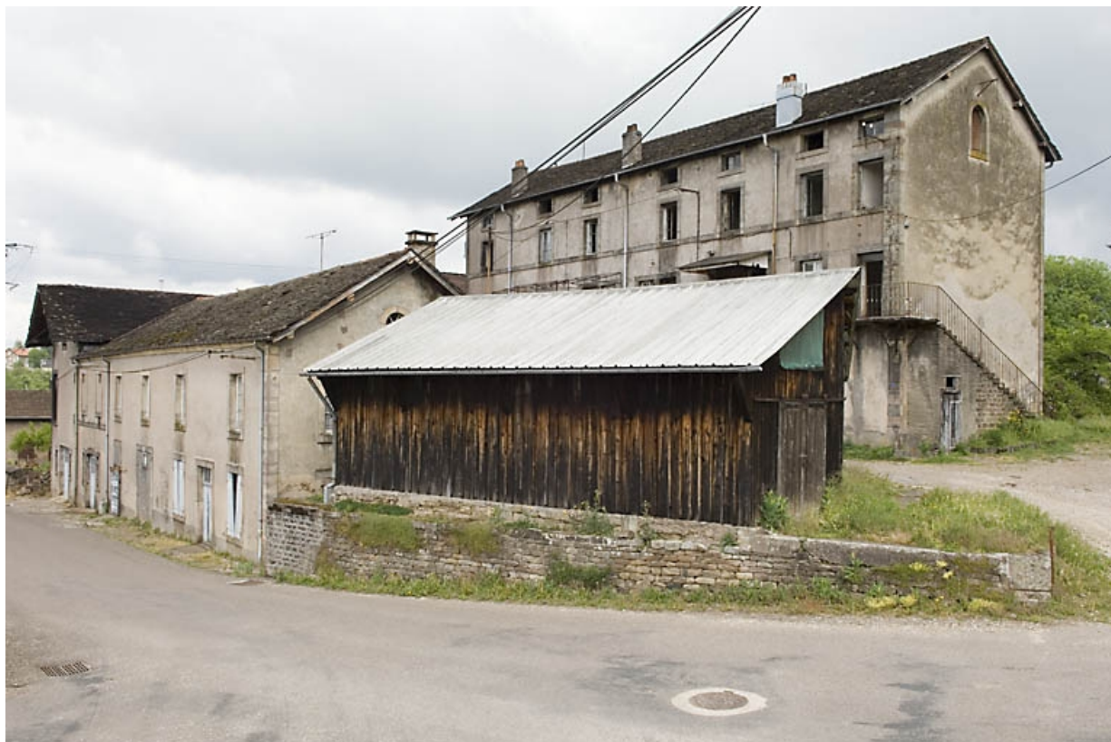
Vinaigrerie, menuiserie et logement ouvrier vus de trois quarts.
