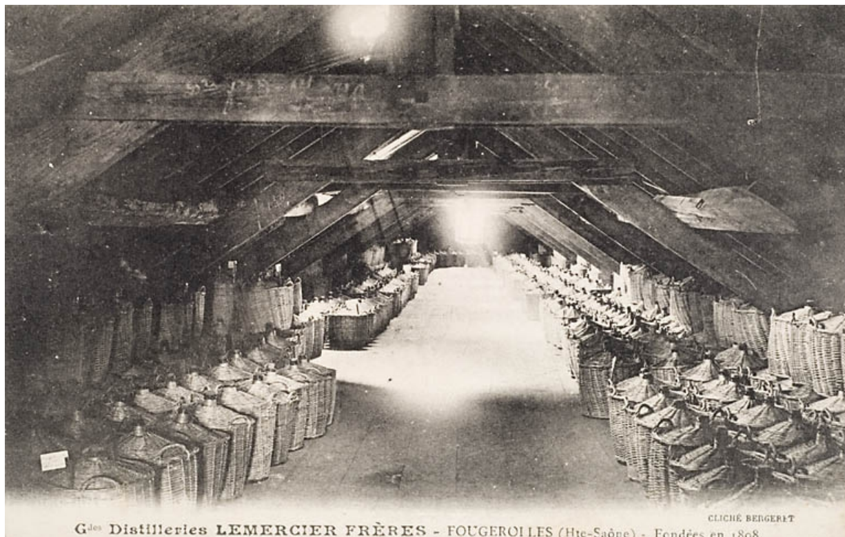
Grandes distilleries Lemerrier Frères. Fougerolles (Haute-Saône) [...] [Grenier de vieillissement des bonbonnes]. 70, Fougerolles, 32 rue de la Gare
