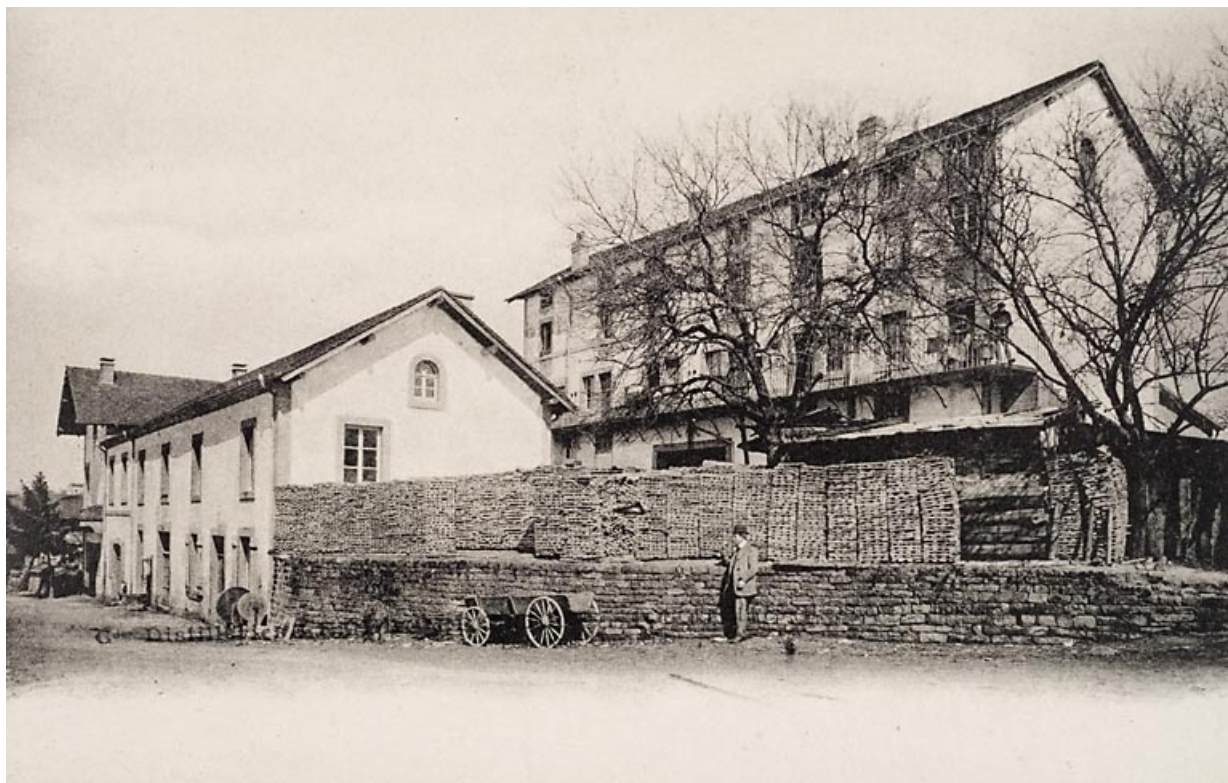
Grandes distilleries Lemerrier Frères. Fougerolles (Haute-Saône) [...] Les cités ouvrières. 70, Fougerolles, 32 rue de la Gare
