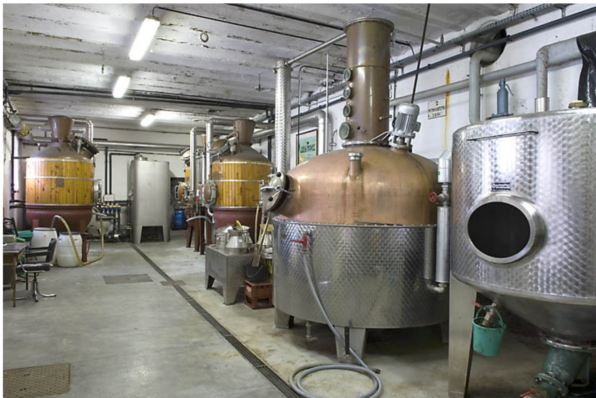
Atelier de distillation. Vue d'ensemble depuis l'entrée.
