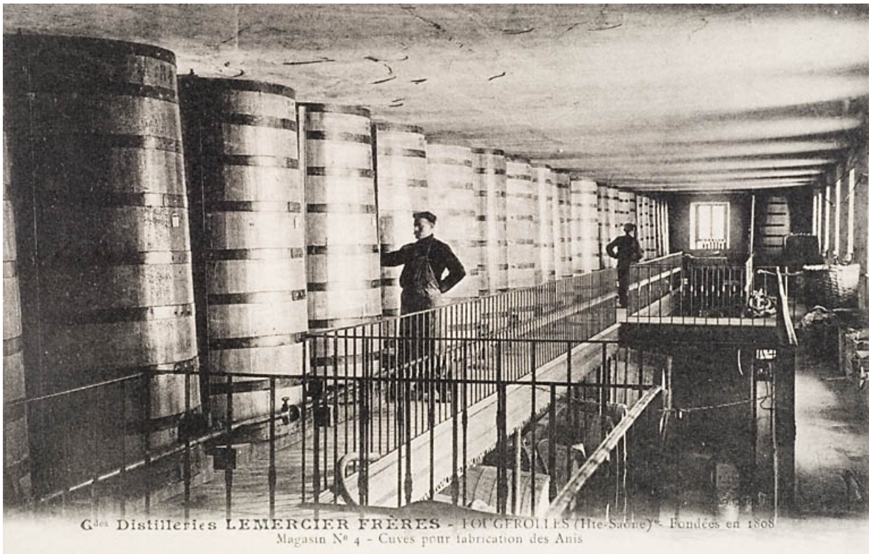
Grandes distilleries Lemerrier Frères. Fougerolles [...] Magasin n° 4. Cuves pour fabrication des anis. 70, Fougerolles, 32 rue de la Gare
