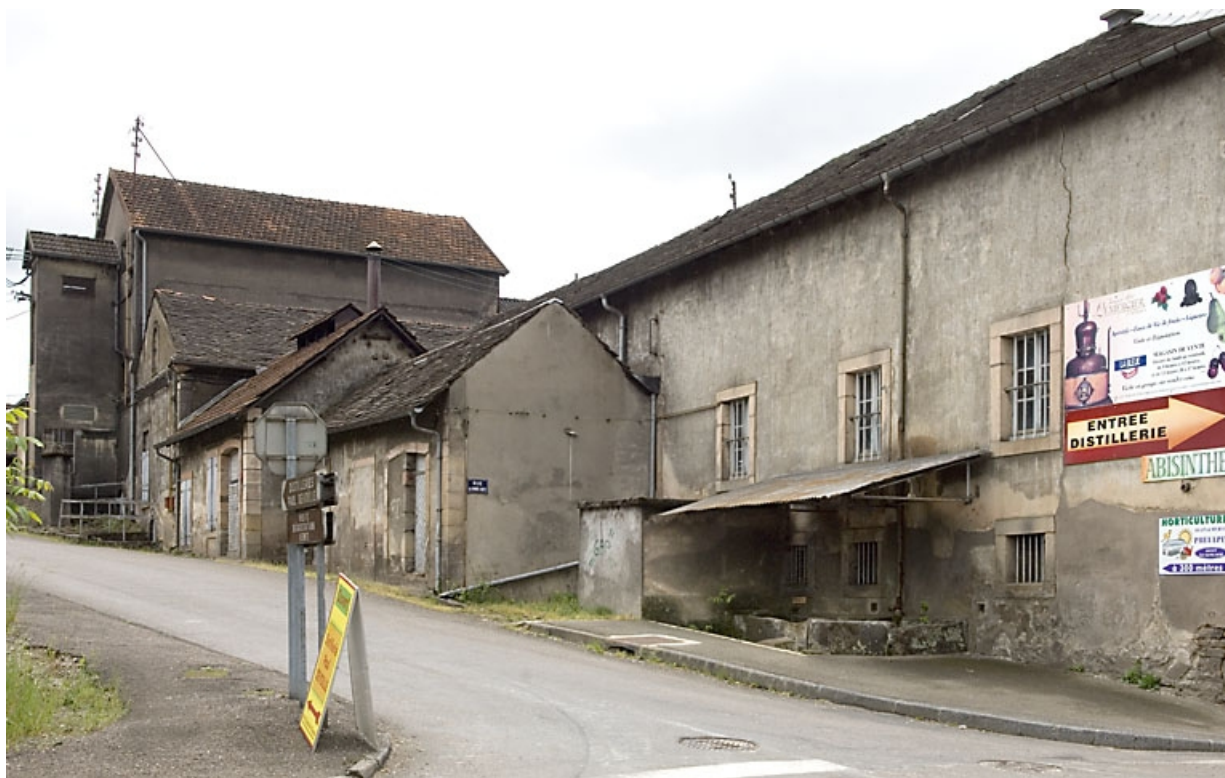
Façades sur la rue des Moines Hauts. Vue depuis le nord.
