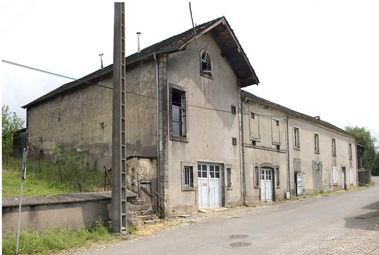
La vinaigrerie et la menuiserie. Vue depuis le nord-est.
