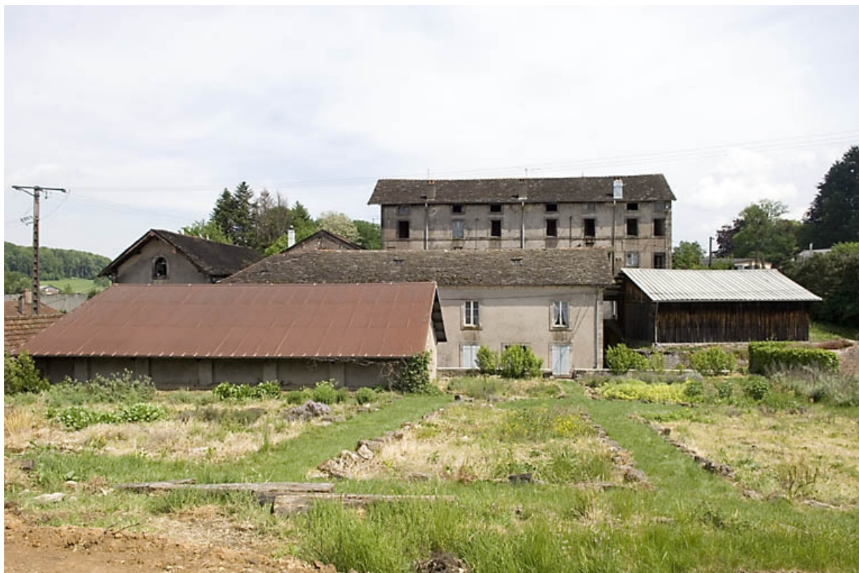
Vinaigrerie, menuiserie et logement ouvrier depuis le sud-ouest.
