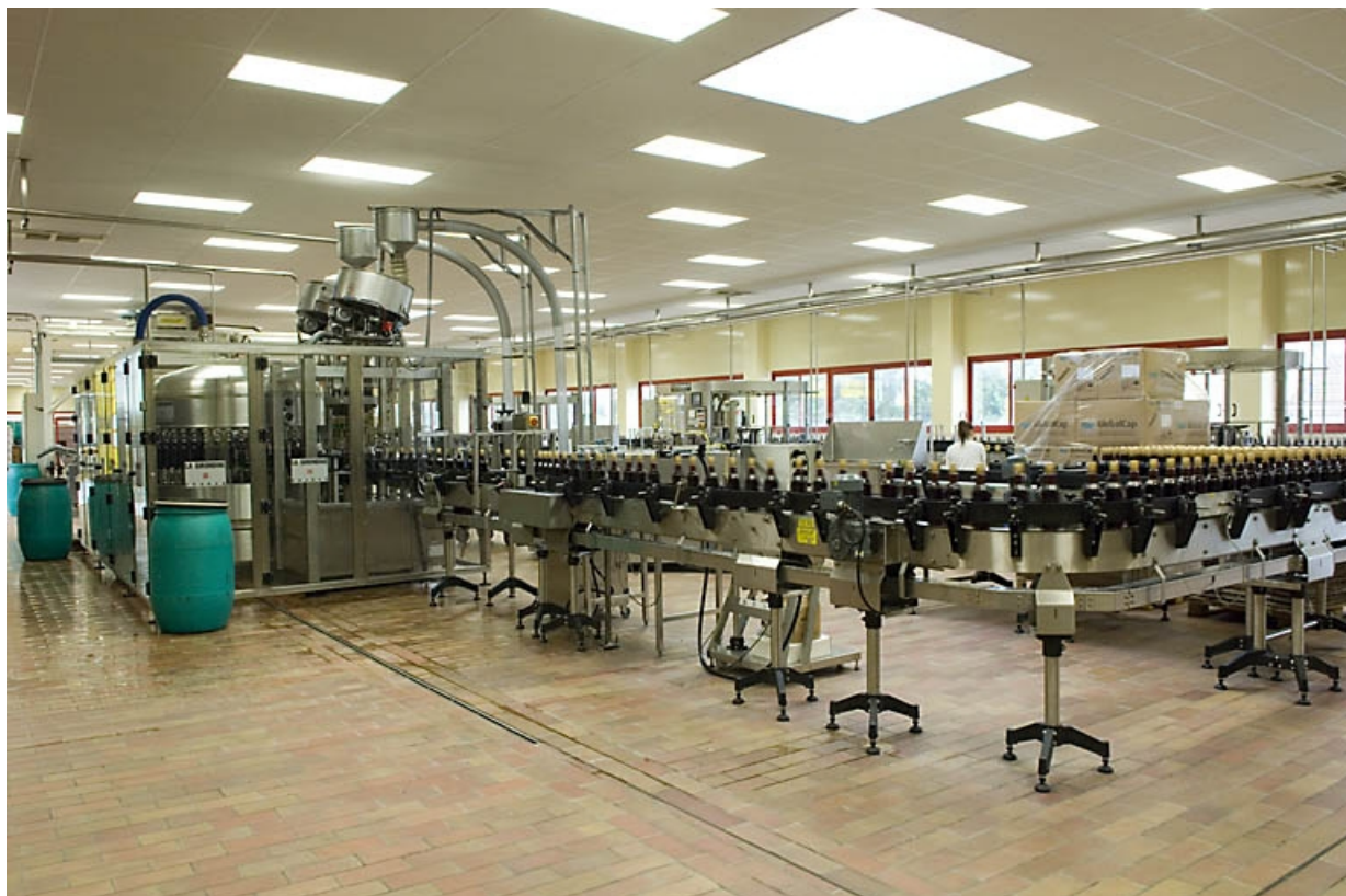
Atelier de conditionnement. Salle d'embouteillage. Vue d'ensemble.
