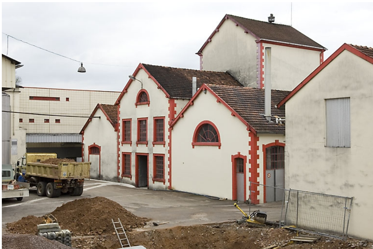
Atelier de fabrication et cuverie. Vue de trois quarts arrière.
