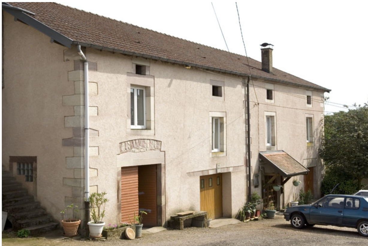
Atelier de fabrication (converti en logements). 70, Fougerolles, lieudit : Enguettin
