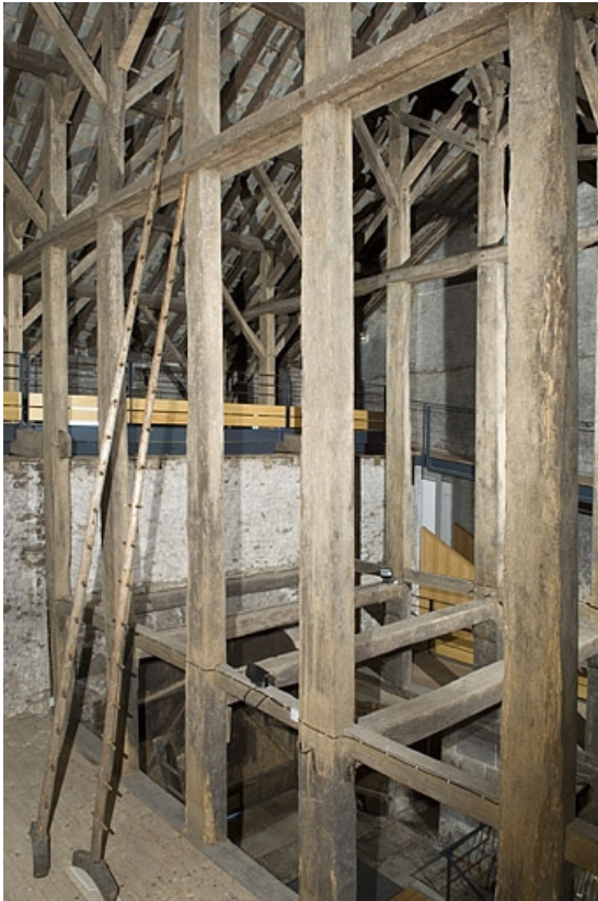
Charpente du fenil. Vue plongeante.
