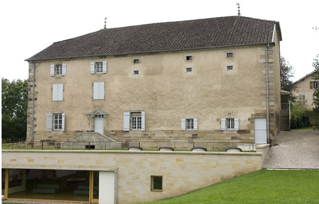
Façade postérieure de la maison abritant le logement patronal et diverses parties agricoles. 70, Fougerolles, lieudit : le Petit Fahys
