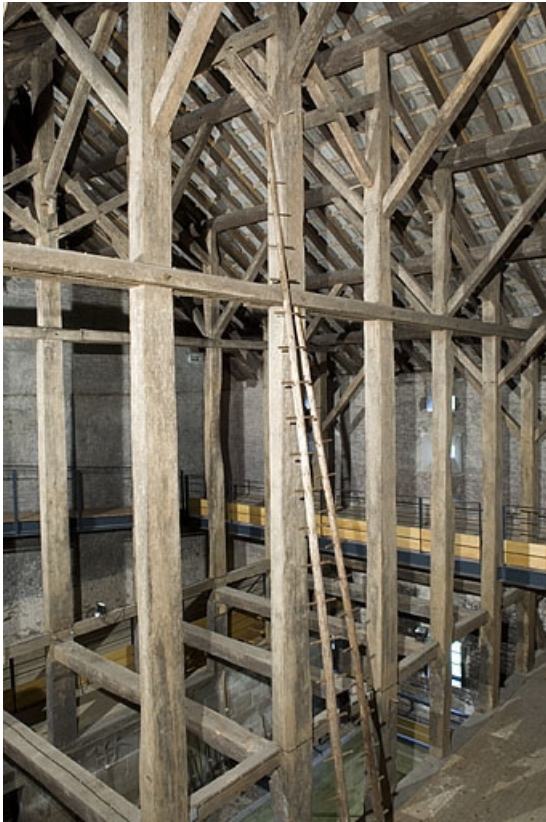
Charpente du fenil (cadrage vertical).
