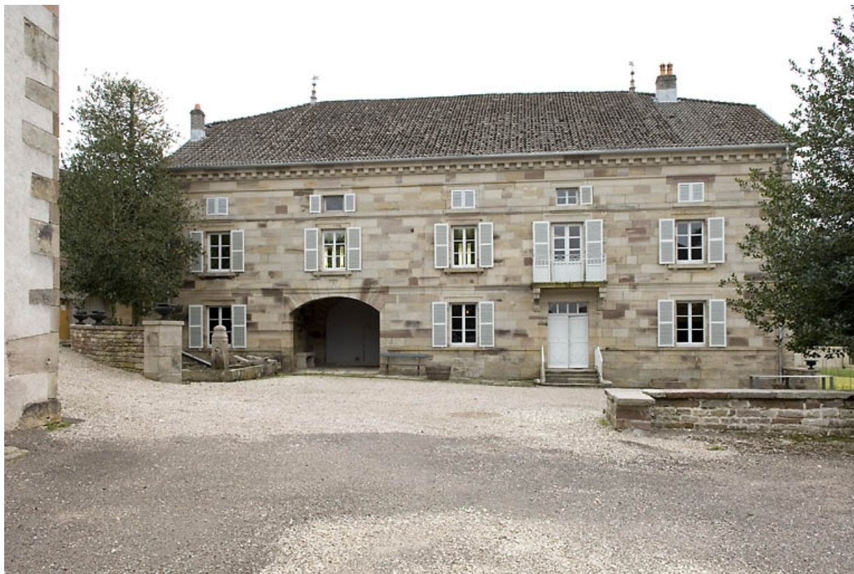
Maison abritant les parties agricoles et le logement patronal. Vue de face.
