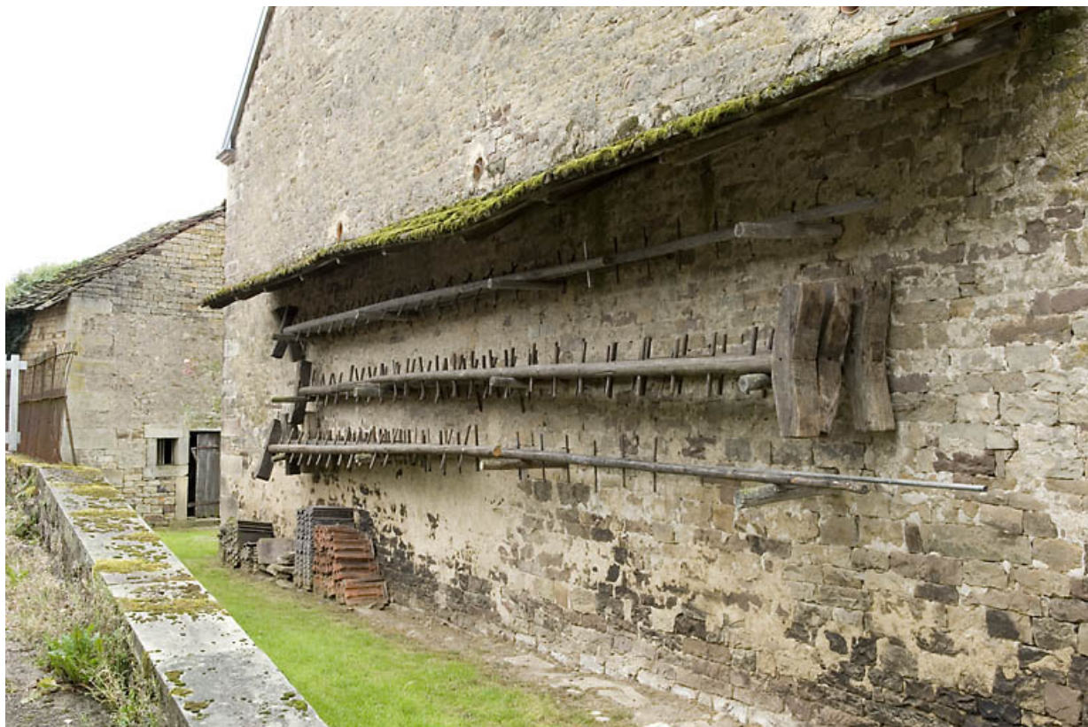
Pieds de chèvre entreposés sur le pignon d'une maison mitoyenne. 70, Fougerolles, lieudit : le Petit Fahys
