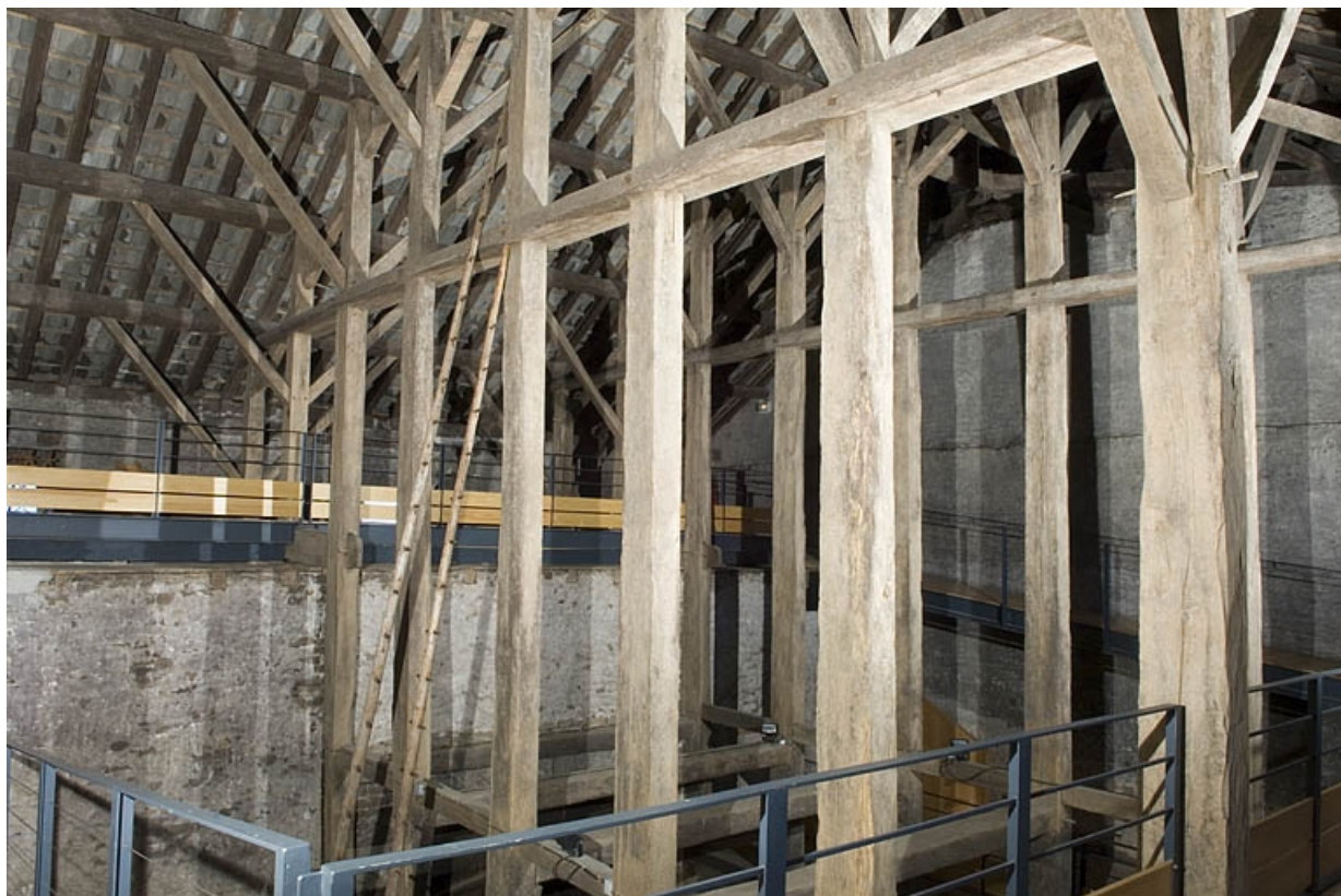
Charpente du fenil (cadrage vertical). 70, Fougerolles, lieudit : le Petit Fahys
