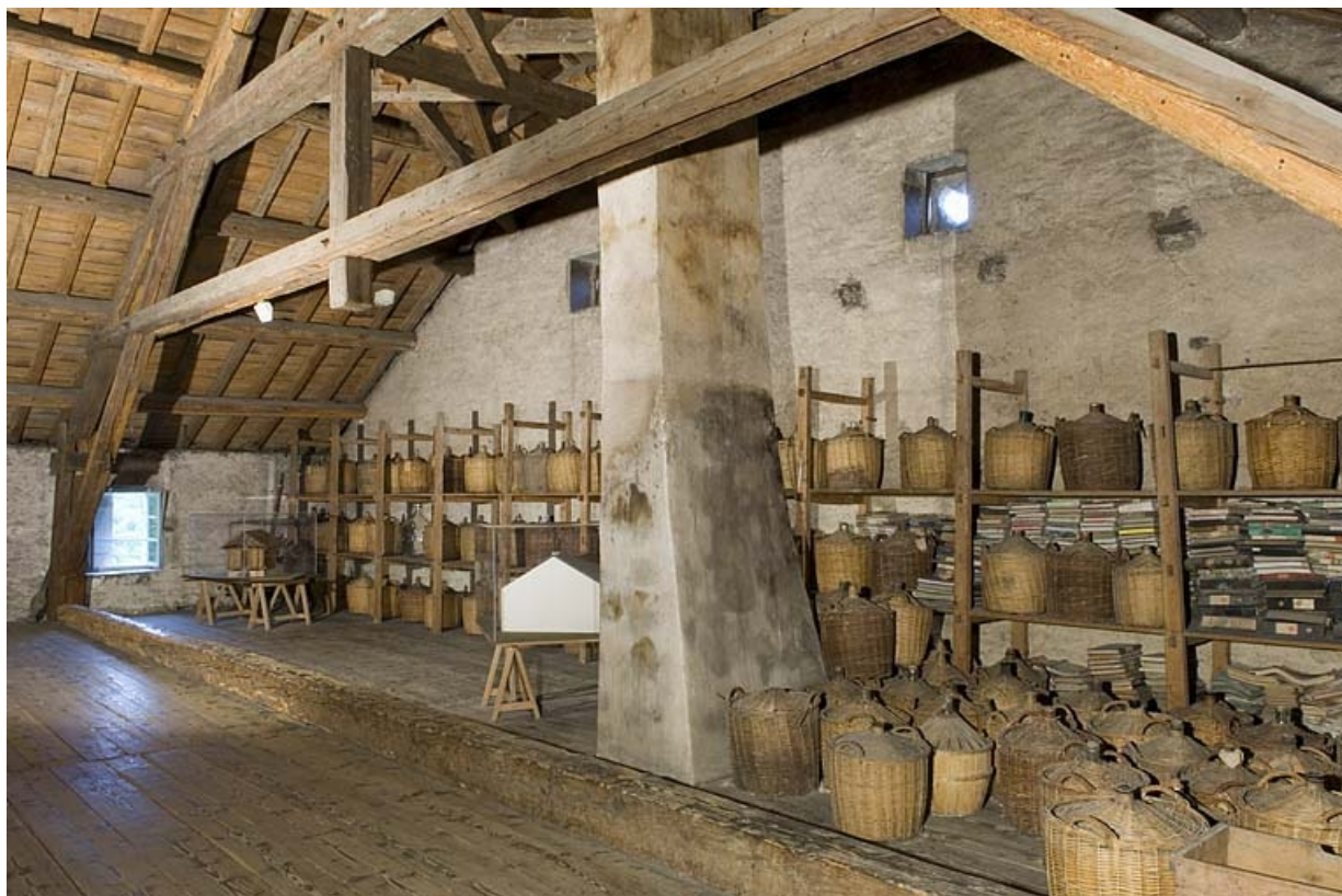
Comble du logement patronal. Pièce de vieillissement des eaux-de-vie. 70, Fougerolles, lieudit : le Petit Fahys
