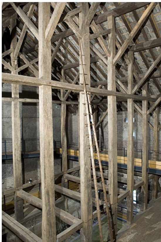
Charpente du fenil (cadrage vertical). 70, Fougerolles, lieudit : le Petit Fahys
