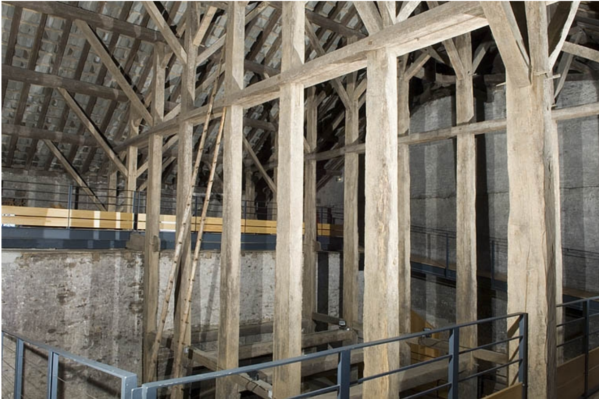
Charpente du fenil (cadrage vertical).
