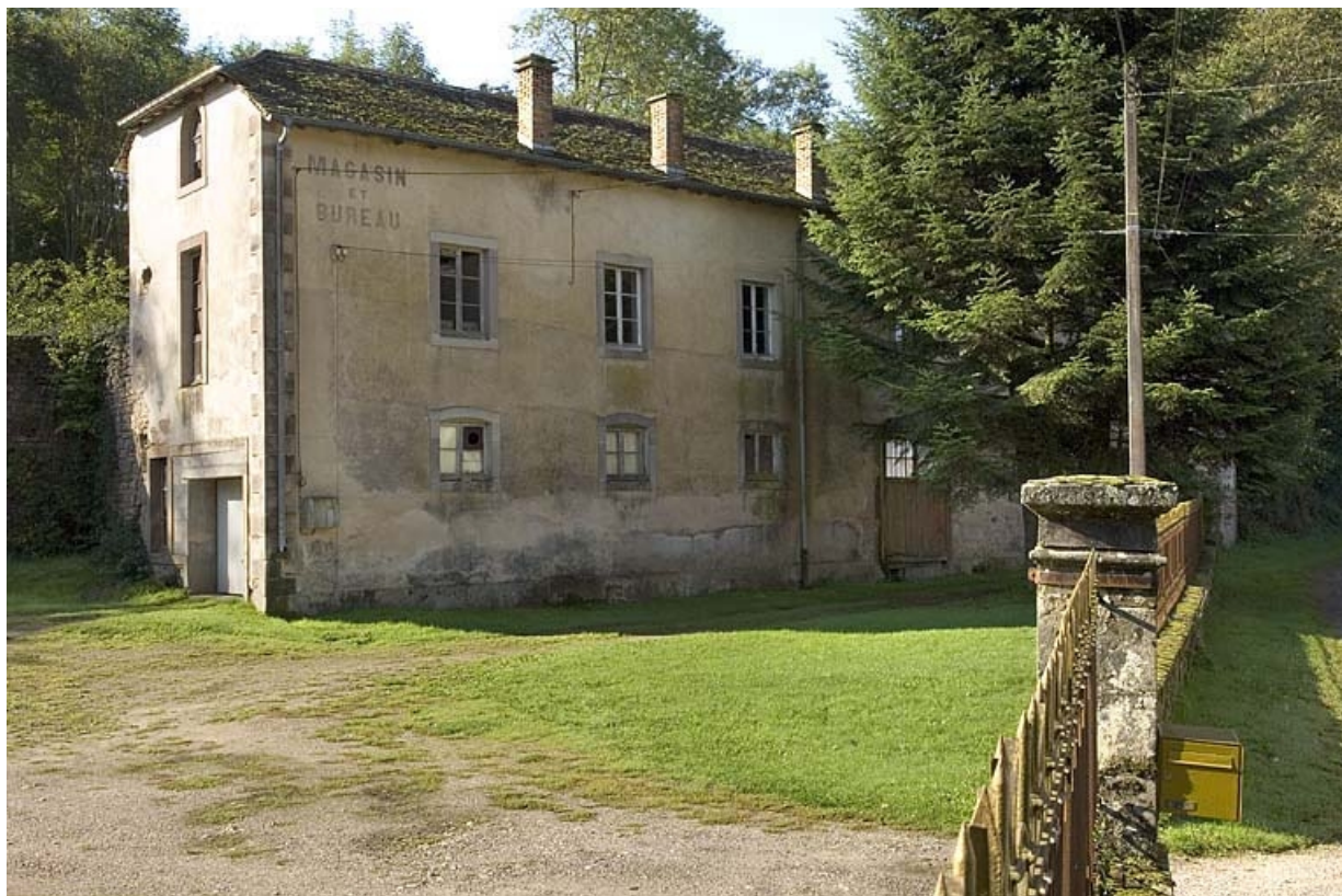
Vue depuis l'entrée du bâtiment des chais et des magasins.
