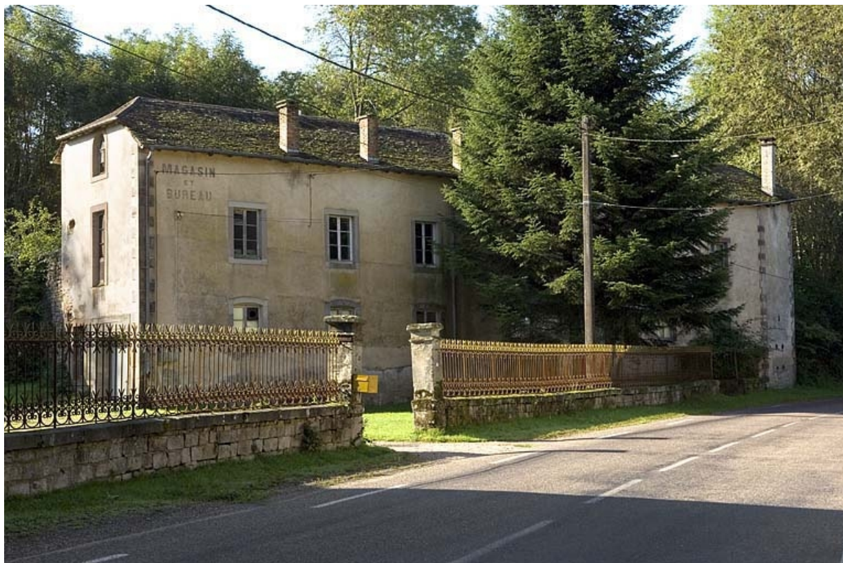
Bâtiment abritant les chais, les magasins et les bureaux.
