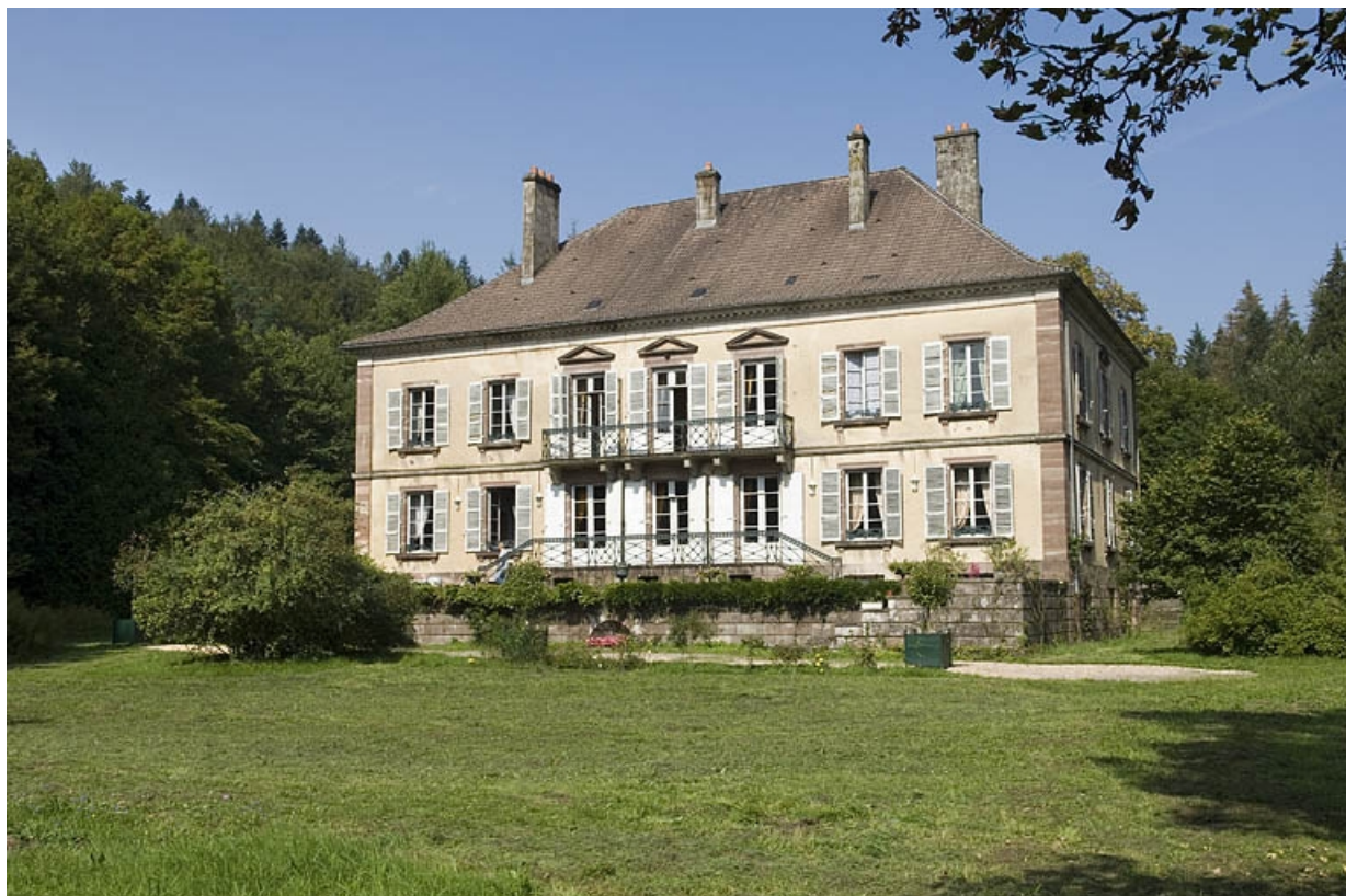
Façade sud vue de trois quarts droite.
