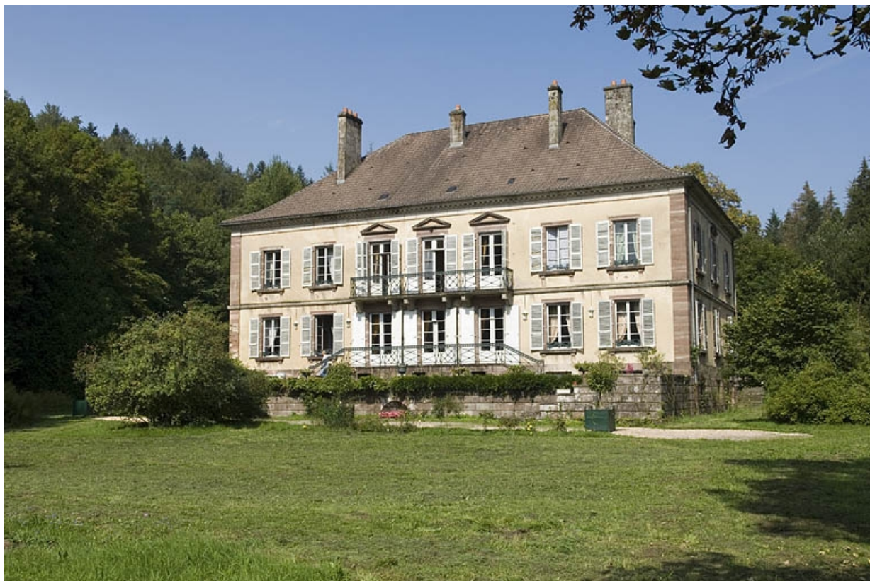
Façade sud vue de trois quarts droite.
