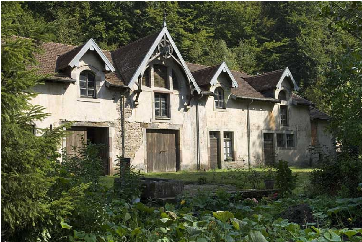
Façade antérieure du bâtiment des écuries et du chenil.
