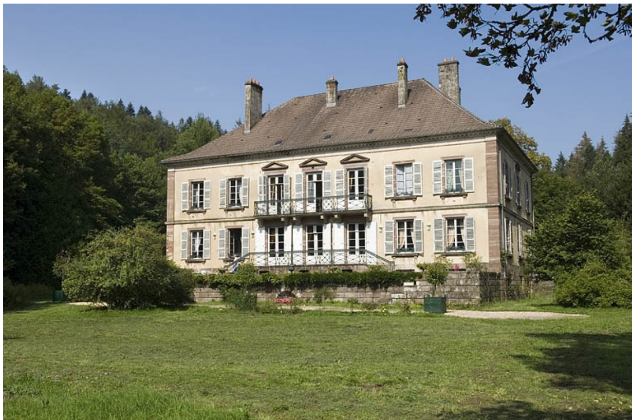
Façade sud vue de trois quarts droite.
