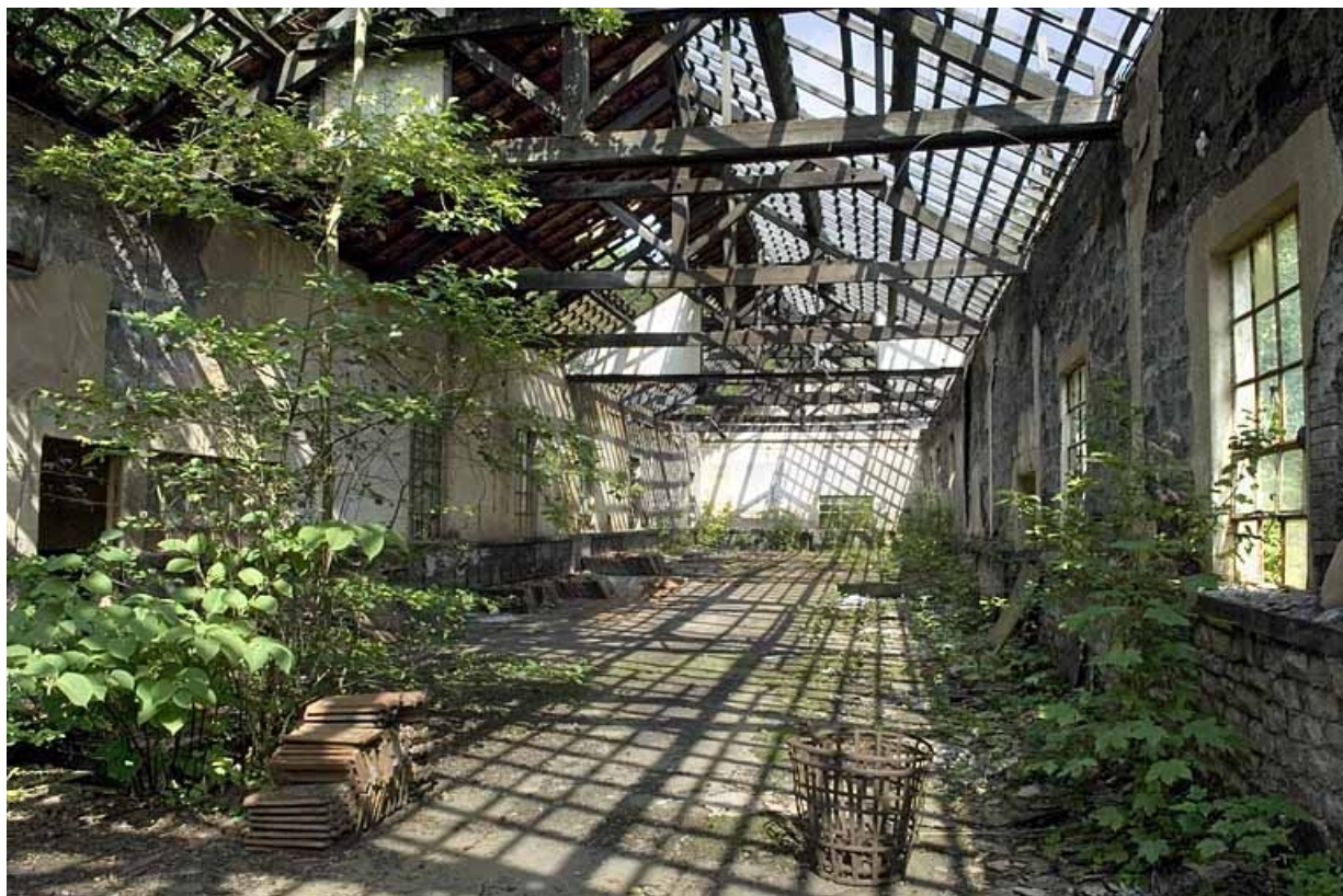
Intérieur de l'ancien atelier de galvanisation et de trempe. Vue d'ensemble. 70, Aillevillers-et-Lyaumont, 21 à 31 route de Plombières, lieudit : la Chaudéau
