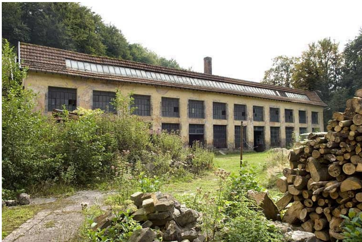
Façade occidentale de l'atelier de fabrication.
