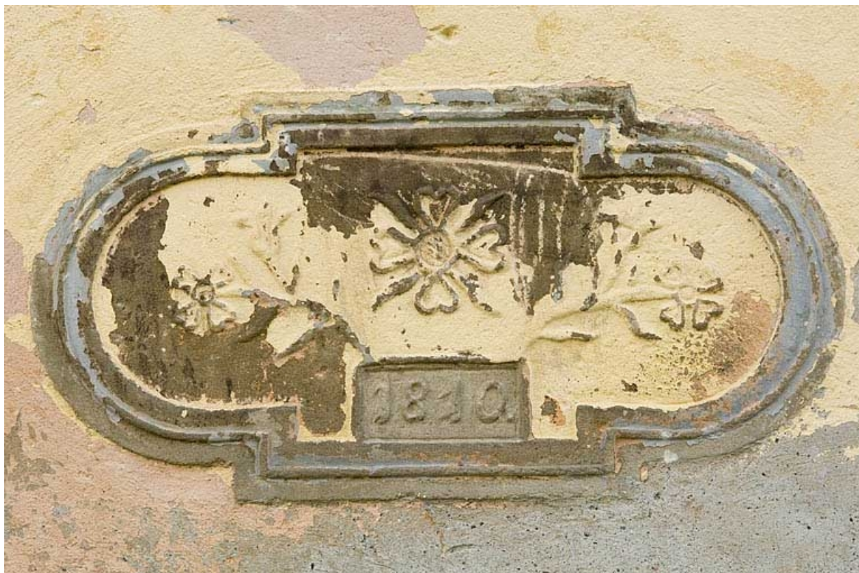
Cartouche placé sur la façade occidentale des logements ouvriers.
