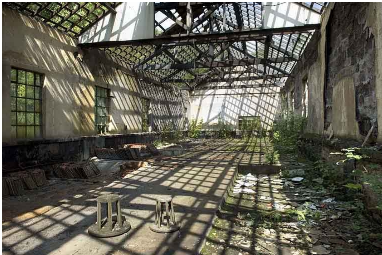
Intérieur de l'ancien atelier de galvanisation et de trempe. Extrémité nord. 70, Aillevillers-et-Lyaumont, 21 à 31 route de Plombières, lieudit : la Chaudéau
