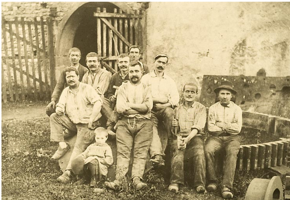
Ouvriers posant devant l'atelier de forge.
